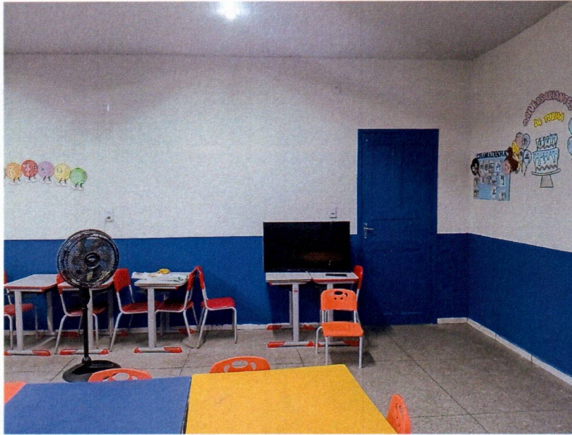
Imagem 11 – Execução da pintura interna.
