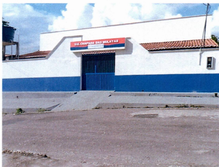
Imagem 1 – Pintura externa da escola e pintura das grades da fachada.
