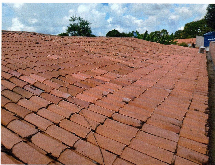
Imagem 6 – Retelhamento com telha cerâmica.
