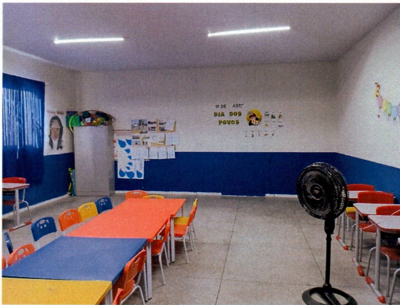
Imagem 12 – Execução da pintura interna.
