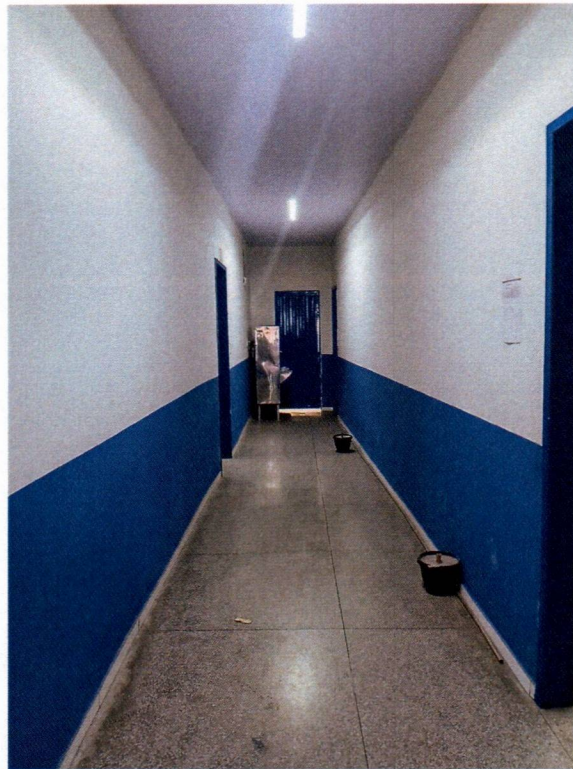
Imagem 9 – Execução da pintura interna.
