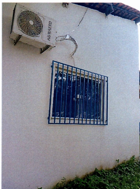
Imagem 5 – Pintura externa e pintura das grades metálicas.
