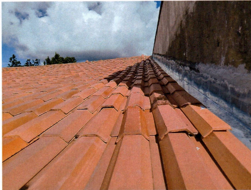
Imagem 7 – Substituição do rufo metálico e retelhamento com telha cerâmica.
