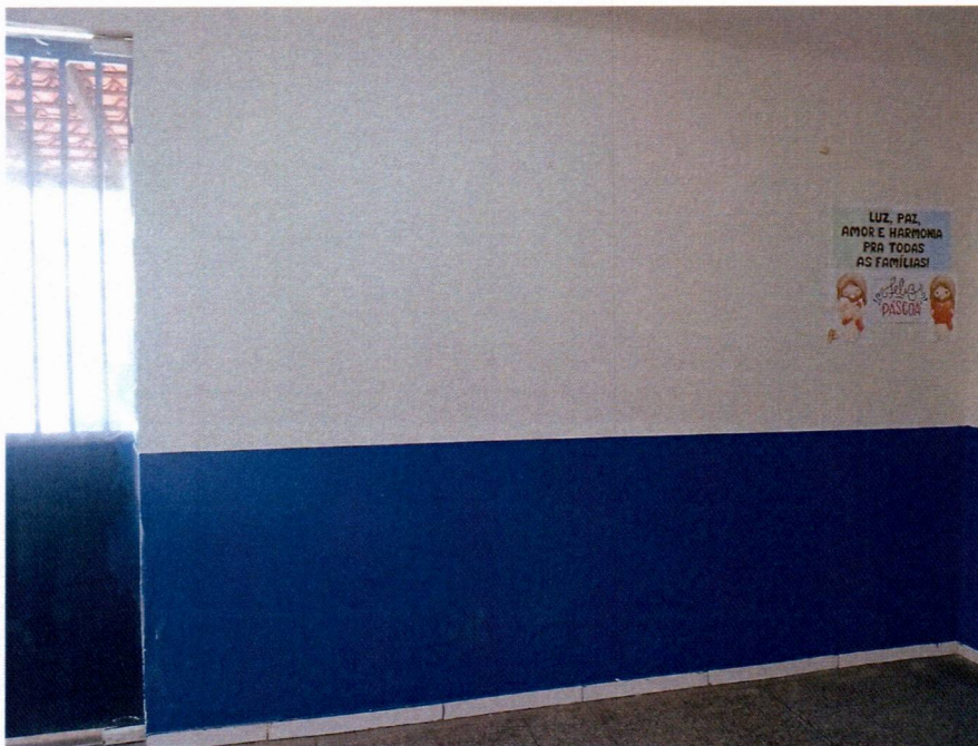
Imagem 8 – Pintura interna e pintura das esquadrias metálicas.
