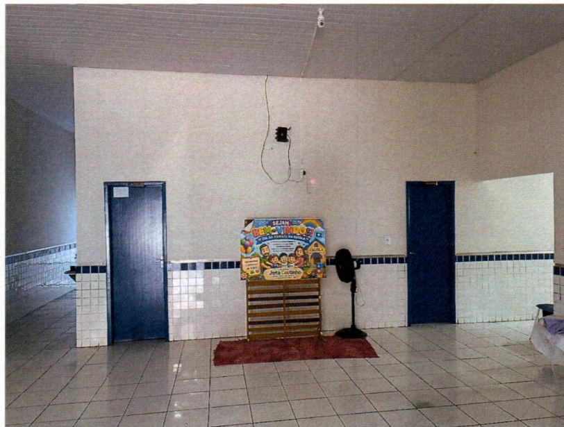
Imagem 12 – Execução da pintura interna.
