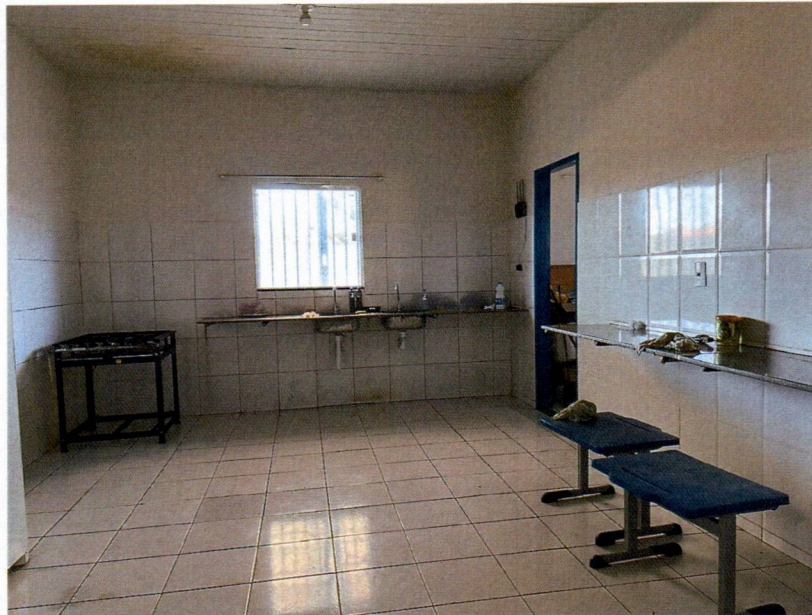
Imagem 11 – Execução da pintura interna na cozinha.
