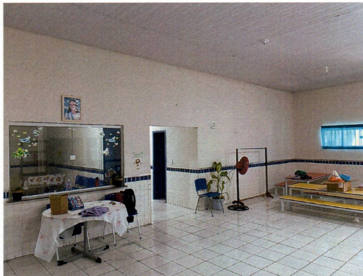
Imagem 10– Execução da pintura interna e substituição das lampadas de led.
