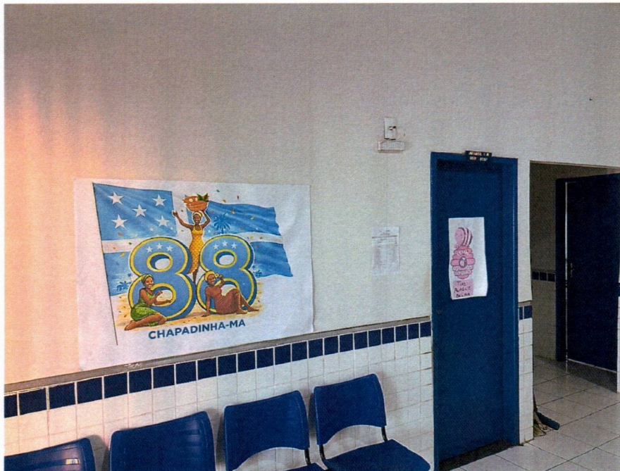
Imagem 8 – Pintura interna e pintura das esquadrias de madeira.
