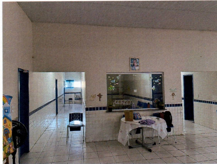
Imagem 9 – Execução da pintura interna.
