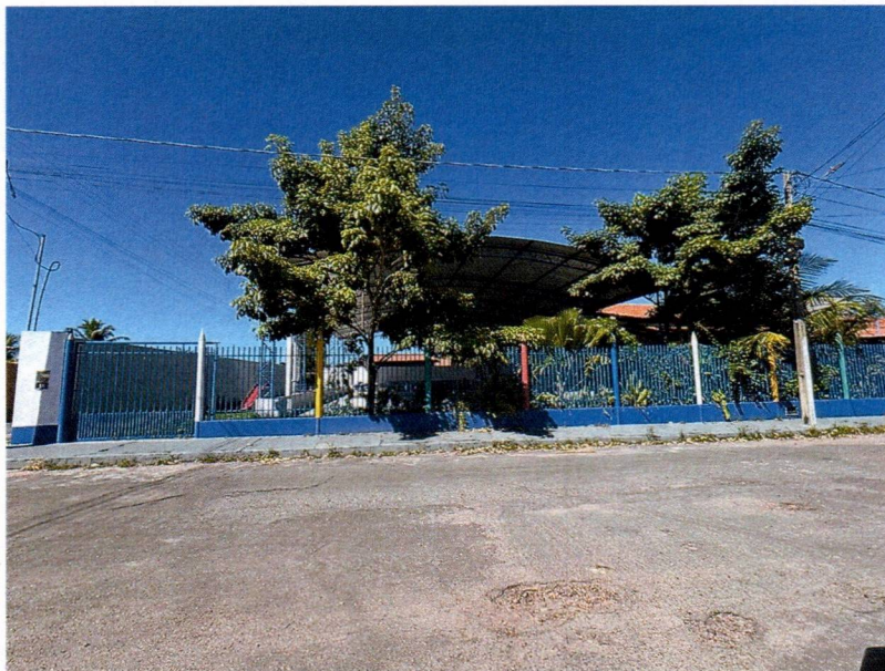
Imagem 2 – Pintura externa da escola e pintura das grades da fachada.
