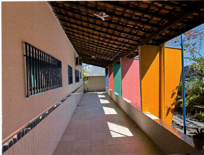
Imagem 7 – Pintura interna da escola.
