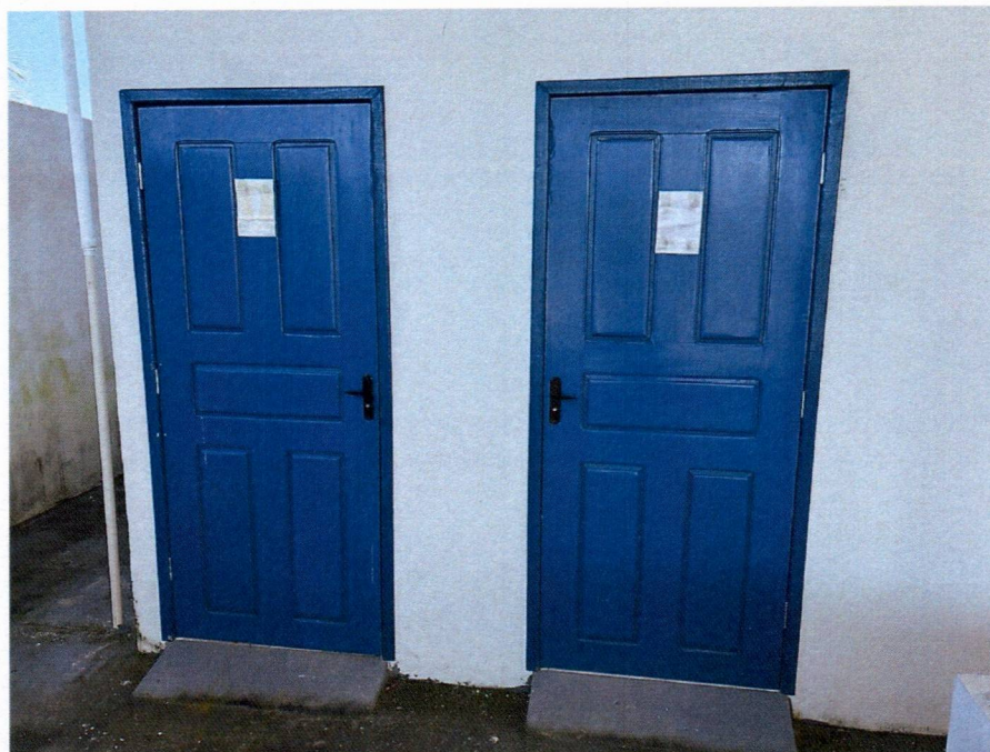
Imagem 5 – Substituição das esquadrias de madeira e das fechaduras.
