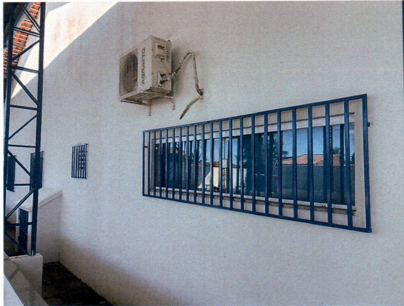
Imagem 3 – Recuperação do reboco externo e pintura externa e pintura das grades.
