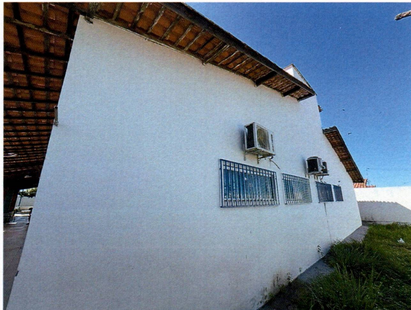
Imagem 4 – Recuperação do reboco externo e pintura externa e pintura das grades.
