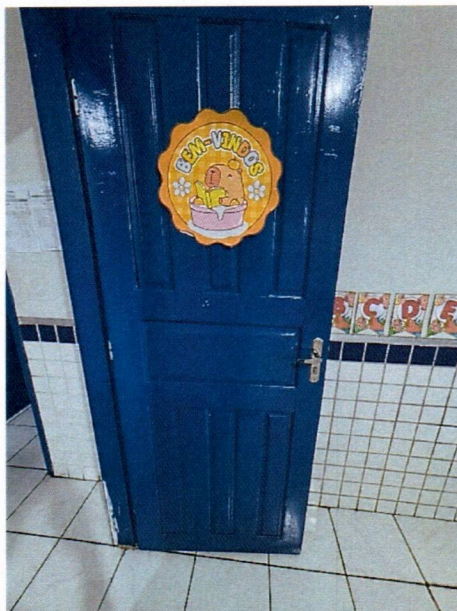
Imagem 15 – Execução da pintura das esquadrias de madeira e substituição das fechaduras internas.
