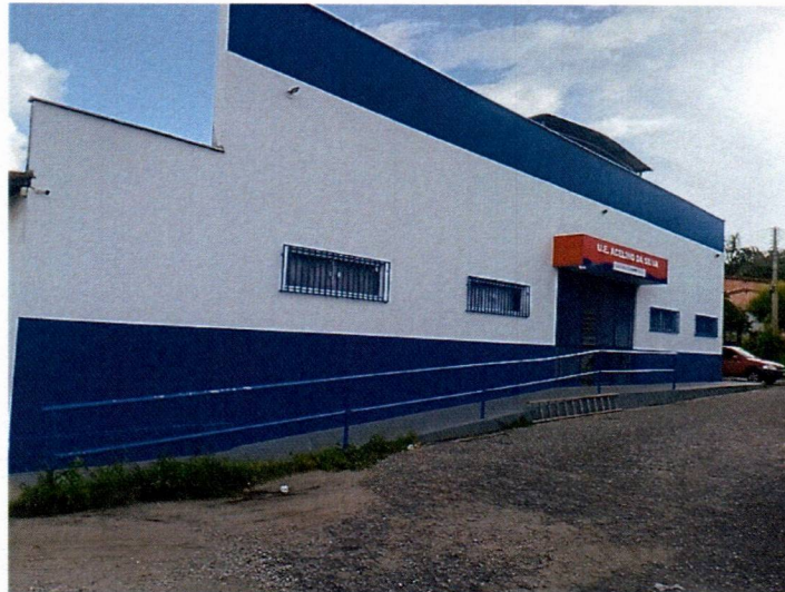
Imagem 1 – Pintura externa da escola e pintura das grades da fachada.
