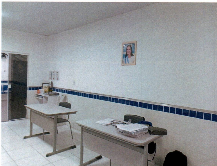
Imagem 9 – Pintura interna e substituição do revestimento cerâmico 45x45 dos comodos da escola
