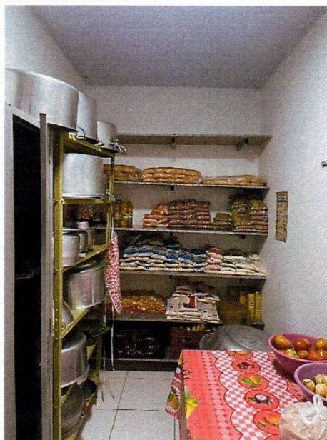
Imagem 15 – Instalação das bancadas de granito no depósito da cozinha.
