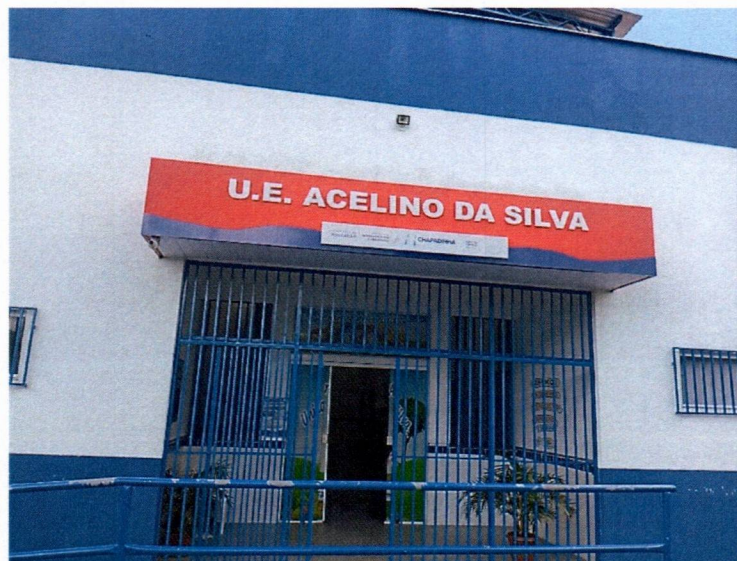
Imagem 2 – Pintura externa da escola e pintura das grades da fachada.
