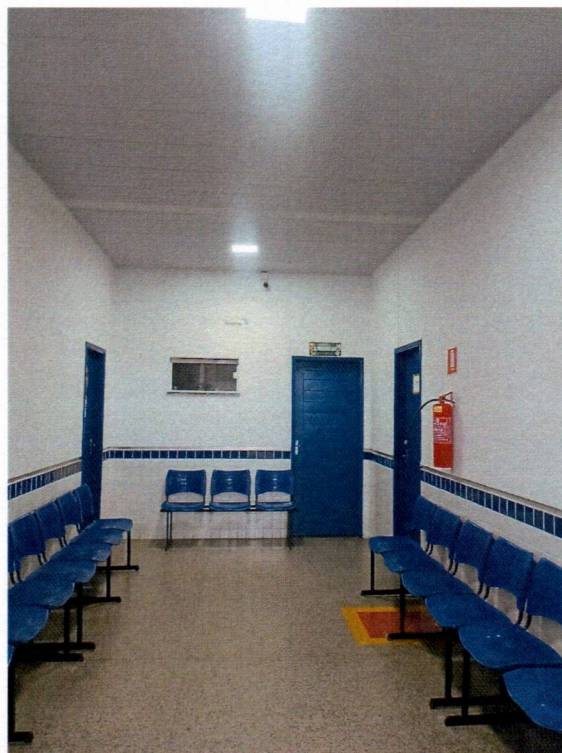
Imagem 8 – Pintura interna e pintura das esquadrias de madeira.
