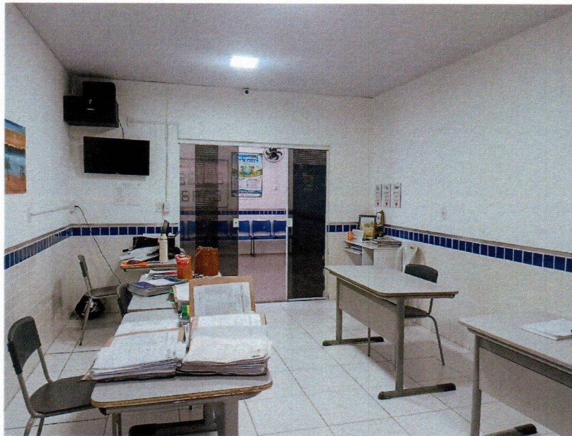
Imagem 11 – Pintura interna e substituição do revestimento cerâmico 45x45 dos comodos da escola
