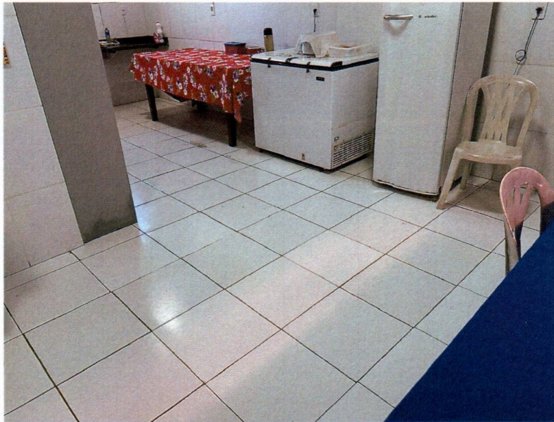
Imagem 13 – Substituição do revestimento cerâmico danificados, 45x45 dos comodos da escola.
