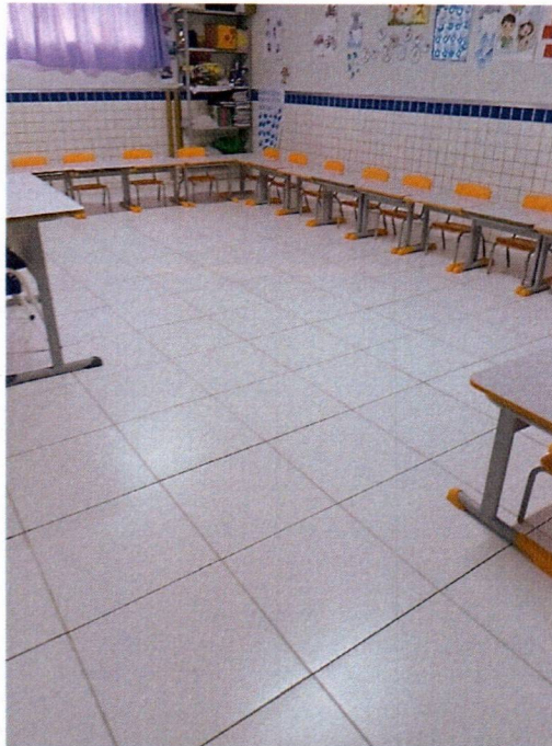
Imagem 13 – Substituição de revestimento cerâmico 45x45 na sala de aula.
