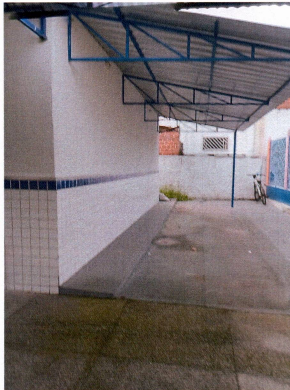
Imagem 2 – Pintura externa da escola e pintura das grades da fachada.
