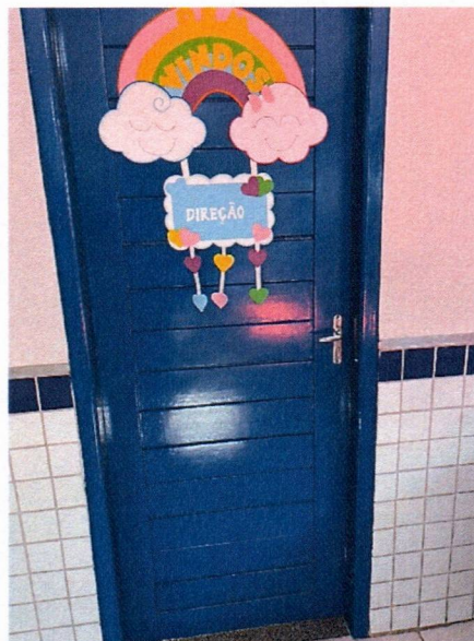
Imagem 16– Substituição das fechaduras das portas.
