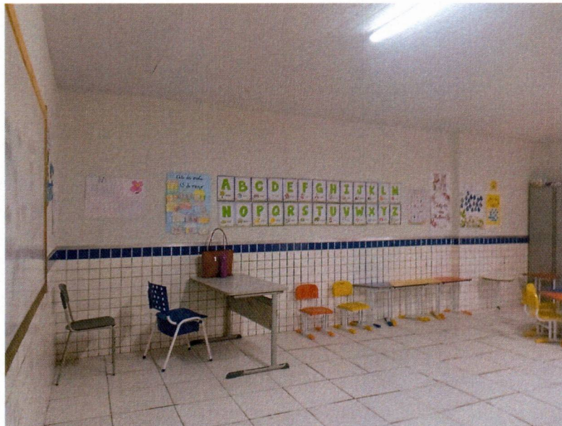
Imagem 14– Execução da pintura interna.
