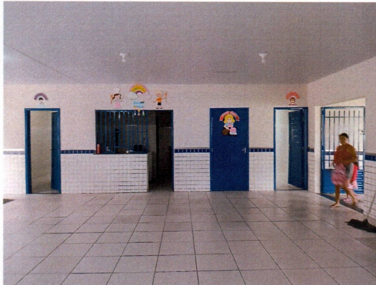
Imagem 9 – Execução da pintura interna e pintura das esquadrias de madeira e metálica.
