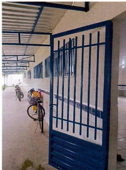
Imagem 10– Execução da pintura interna e pintura das esquadrias
