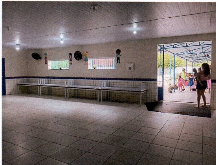
Imagem 15 – Execução da pintura interna.
