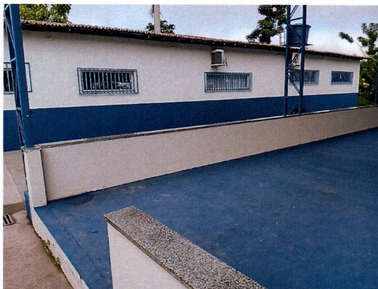
Imagem 7 – Pintura externa e pintura do piso da quadra.
