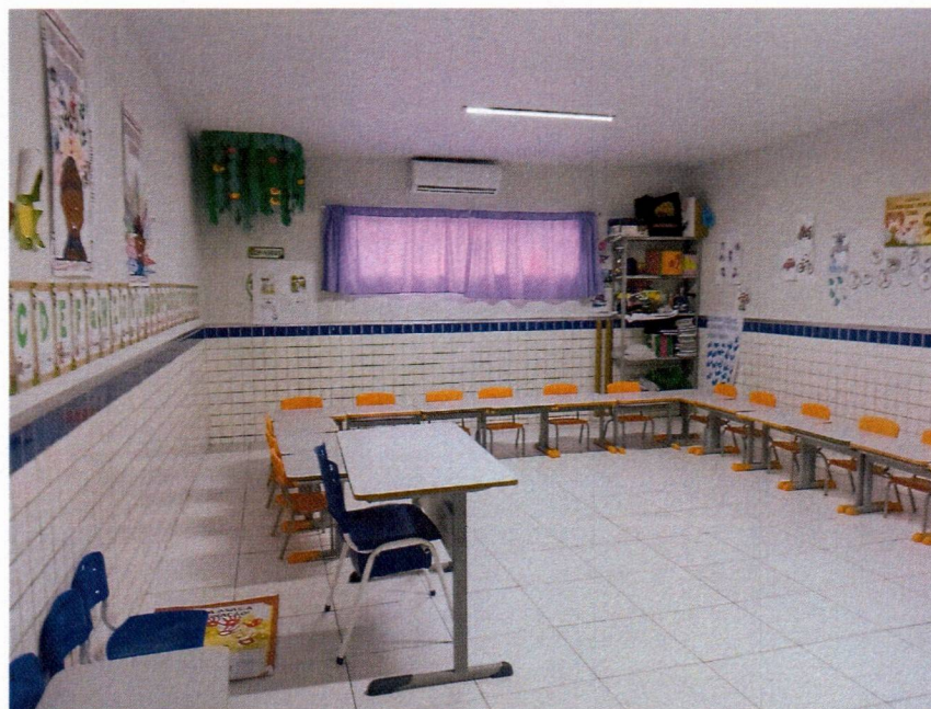
Imagem 12 – Substituição de revestimento cerâmico 45x45 na sala de aula.
