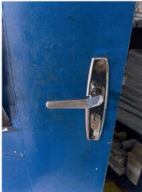
Imagem 12– Substituição das fechaduras das portas.
