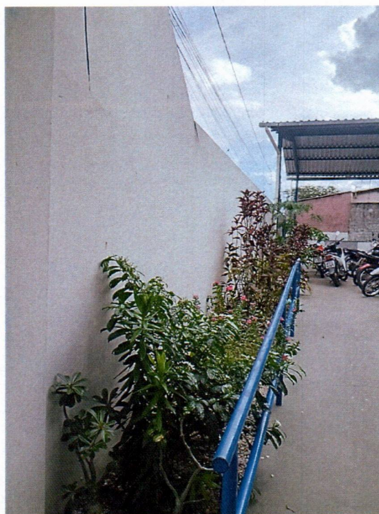
Imagem 3 – Pintura interna dos muros da escola.
