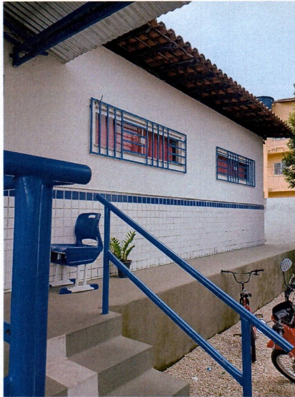
Imagem 5 – Pintura externa, pintura do piso e pintura dos guarda corpos da escada.
