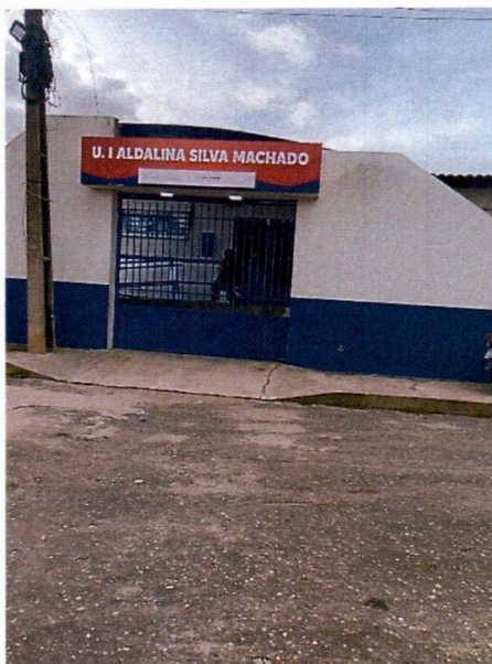
Imagem 1 – Pintura externa da escola e pintura das grades da fachada.
