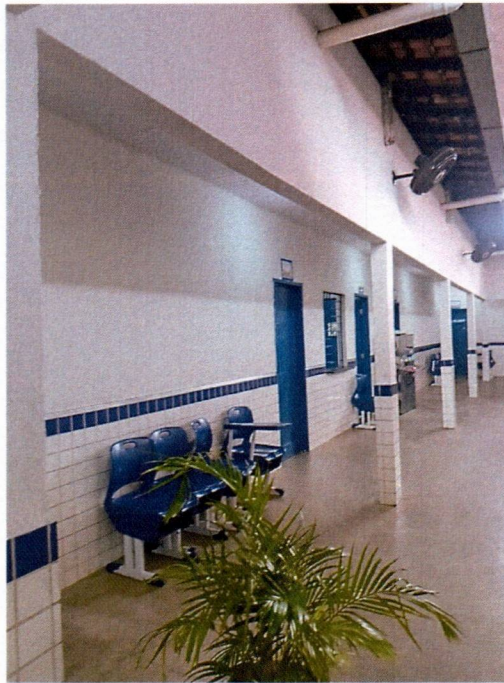
Imagem 7 – Pintura interna da escola.
