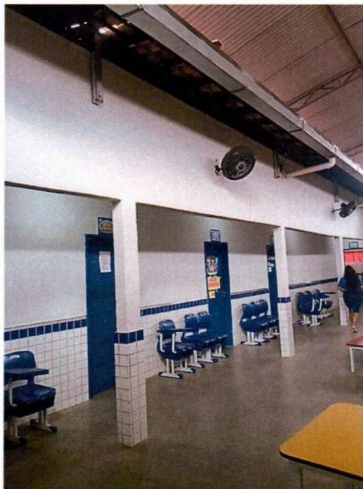
Imagem 6 – Pintura interna da escola.
