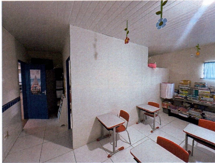
Imagem 11 – Execução da parede de gesso e instalação da porta de madeira.
