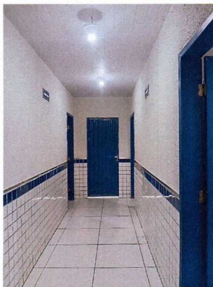
Imagem 10– Execução da pintura interna, pintura das esquadrias e substituição das luminárias.
