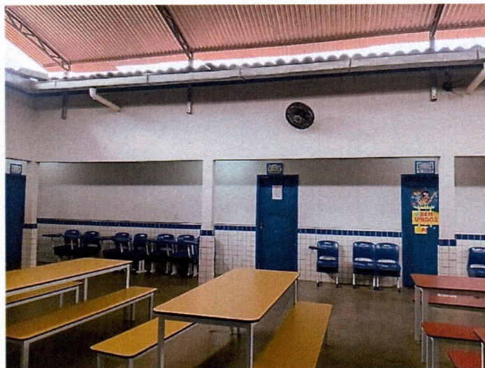
Imagem 9 – Execução da pintura interna e substituição das luminárias.
