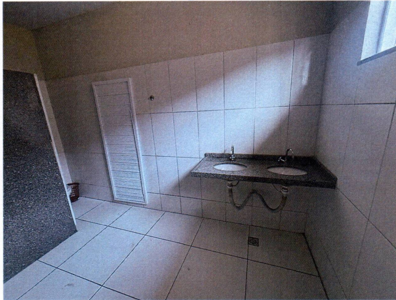
Imagem 13– Execução da revisão dos pontos hidrosanitários.
