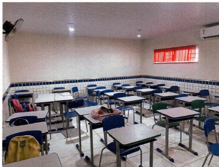
Imagem 8 – Execução da pintura interna e substituição das luminárias.
