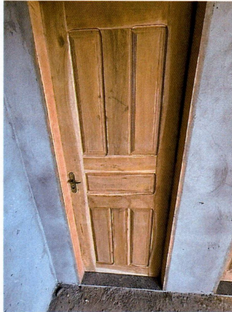
Imagem 11 – Instalação das esquadrias de madeira.
