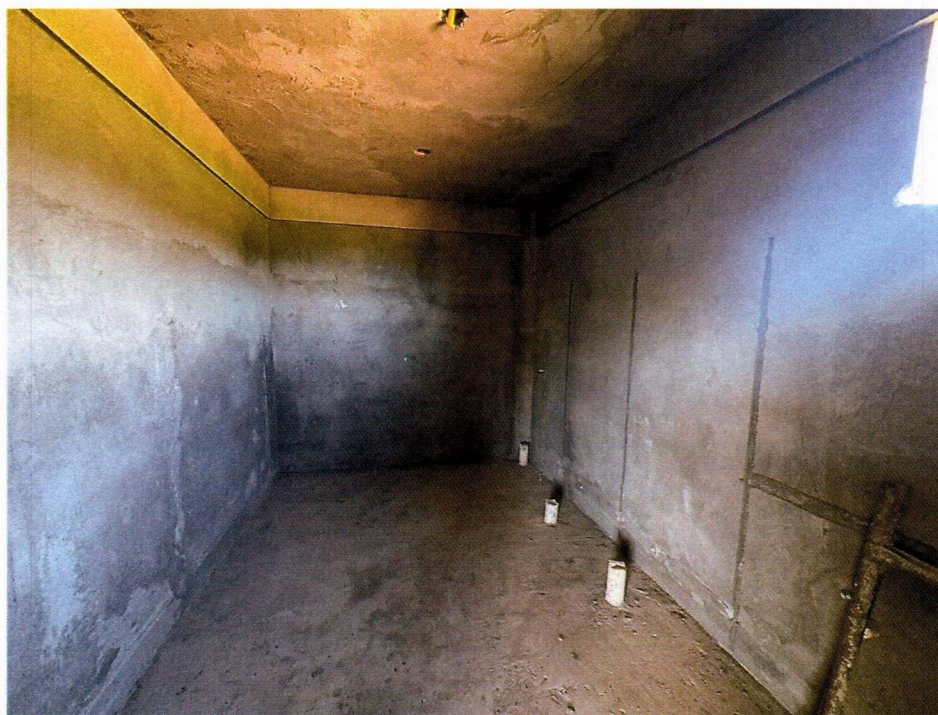
Imagem 6 – Execução do contrapiso, emboço e instalações hidrosanitárias dos banheiros.
