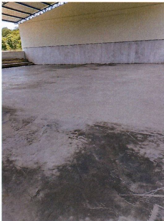
Imagem 9 – Execução do piso da quadra e pintura interna da quadra.
