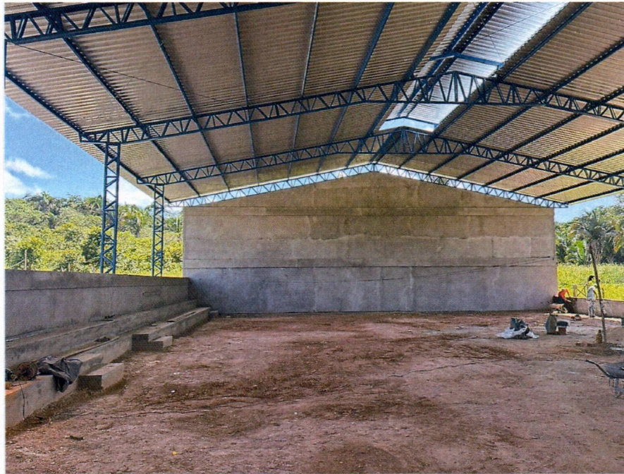
Imagem 1 – Execução da cobertura metálica.
