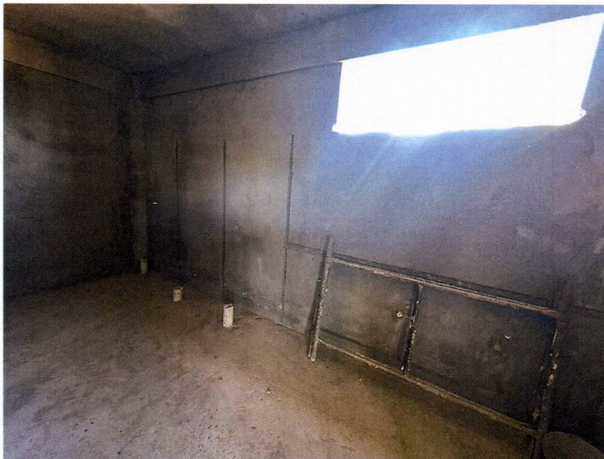
Imagem 7 – Execução do contrapiso, emboço e instalações hidrosanitárias dos banheiros.
