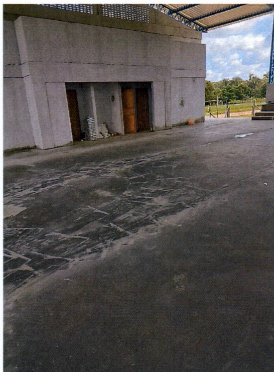
Imagem 8 – Execução do piso da quadra.
