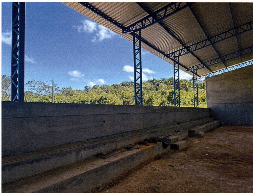
Imagem 5 – Execução do reboco e concretagem do piso da arquibancada.
