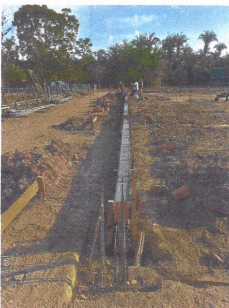
Imagem 6 – Execução da concretagem das vigas baldrame.
