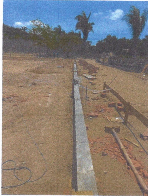
Imagem 7 – Execução da concretagem das vigas baldrame.
