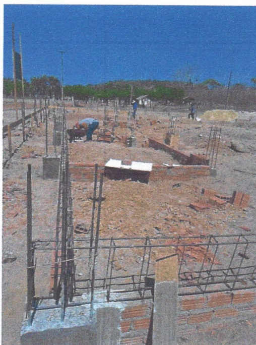
Imagem 4 – Execução da armação da viga baldrame.
