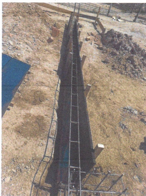
Imagem 3 – Execução da armação da viga baldrame e montagem das formas de madeira.
