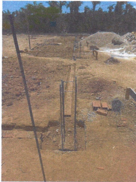
Imagem 1 – Execução do nivelamento do terreno com alvenaria e arranque dos pilares.
