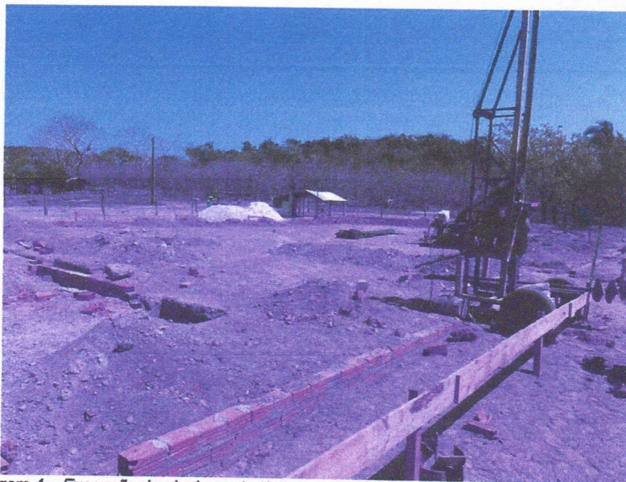
Imagem 4 – Execução do nivelamento do terreno com alvenaria e escavação das fundações.
