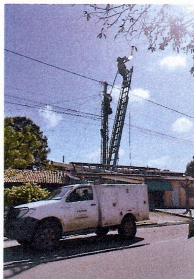
Figura 02: equipe em campo realizando substituições necessárias de Lâmpadas, cabo elétrico, conector, reator, arruela, braços com caminhonete adaptada.
