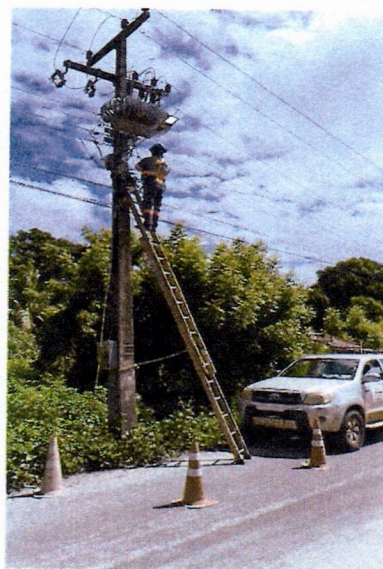
Figura 06: equipe em campo realizando substituições necessárias de Lâmpadas, cabo elétrico, conector, reator, arruela, braços com caminhonete adaptada.
