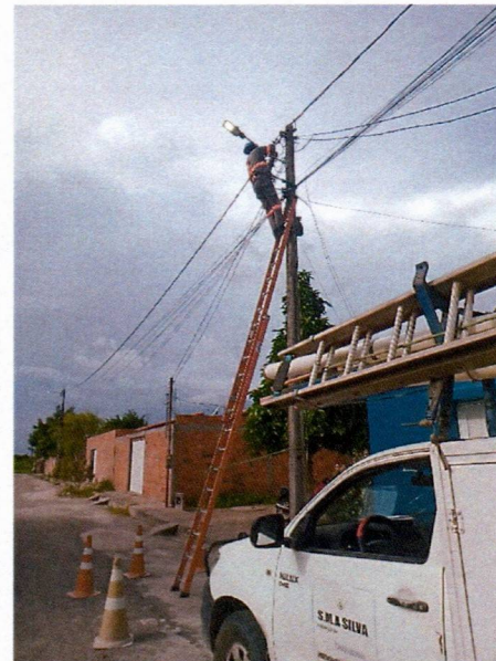
Figura 06: equipe em campo realizando substituições necessárias de Lâmpadas, cabo elétrico, conector, reator, arruela, braços com caminhonete adaptada.
