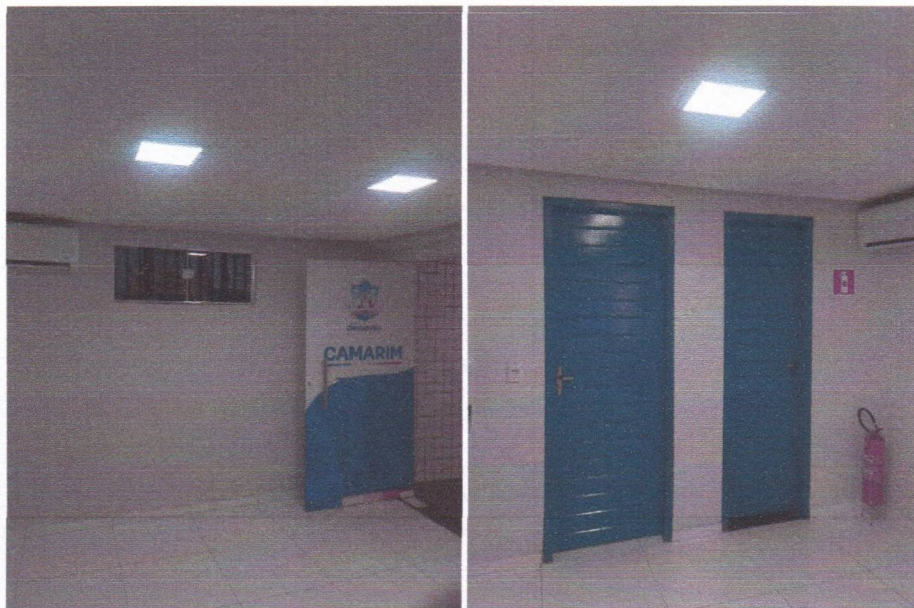
IMAGEM 02 – INSTALAÇÃO DAS ESQUADRIAS DE VIDRO E MADEIRA
