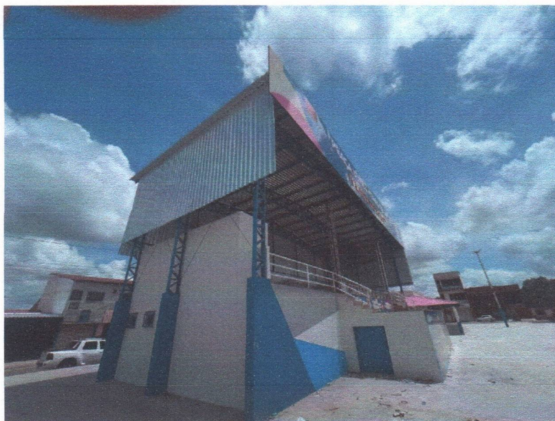
IMAGEM 06 – PALCO DA PRAÇA – ESTRUTUTA METALICA
