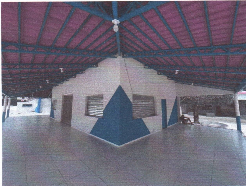
IMAGEM 04 – APLICAÇÃO DE PINTURA DO QUIOSQUE E INSTALAÇÃO DAS ESQUADRIAS
