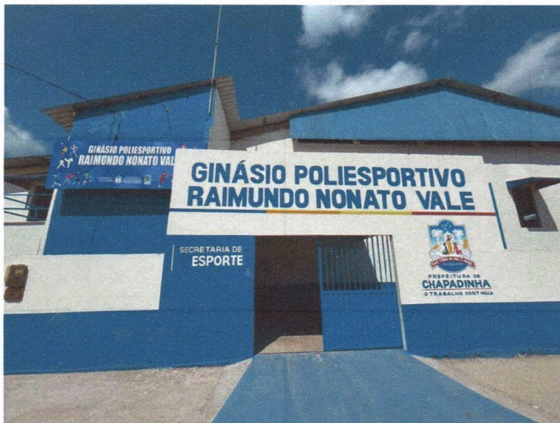
Imagem 1 – Execução da fachada do ginásio, com estrutura de concreto armado, alvenaria, chapisco, reboco, execução da cobertura metálica da entrada e instalação do portão metálico.
