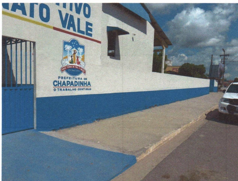
Imagem 2 – Execução da calçada externa do ginásio e pintura externa.
