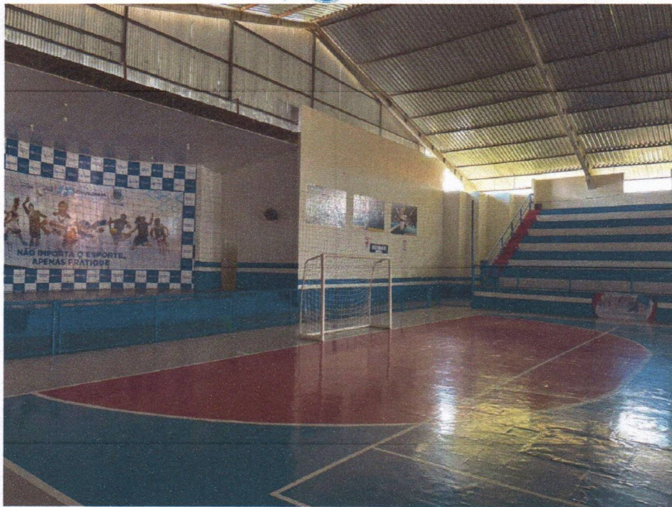
Imagem 7 – Pintura interna e pintura do piso da quadra com tinta epoxi.
