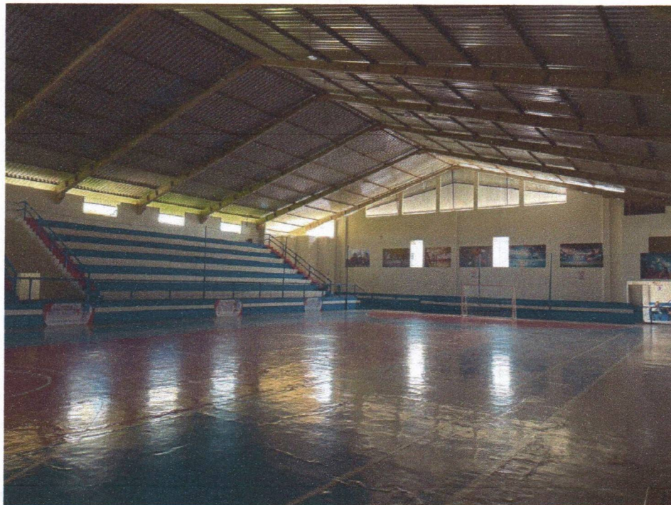
Imagem 8 – Pintura interna e pintura do piso da quadra com tinta epoxi.
