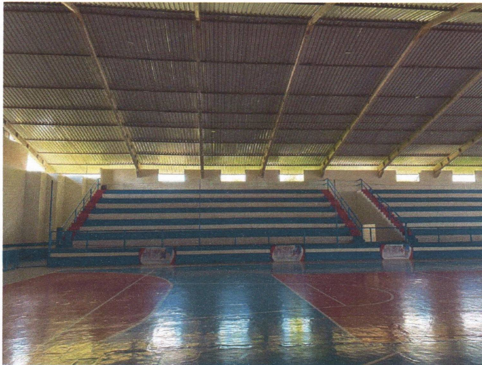
Imagem 6 – Pintura do piso da quadra com tinta epoxi.
