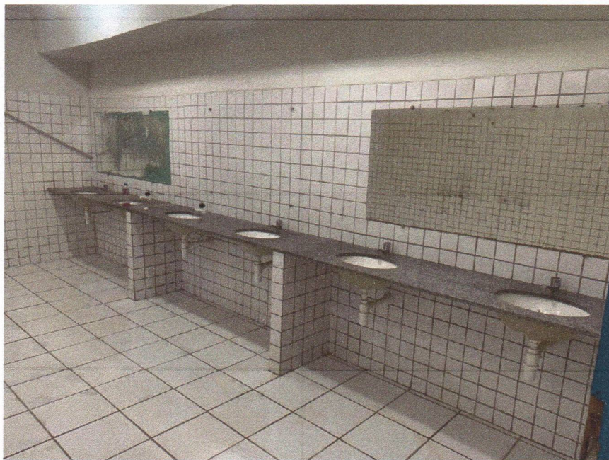
Imagem 9 – Revisão nos pontos hidráulicos dos banheiros.
