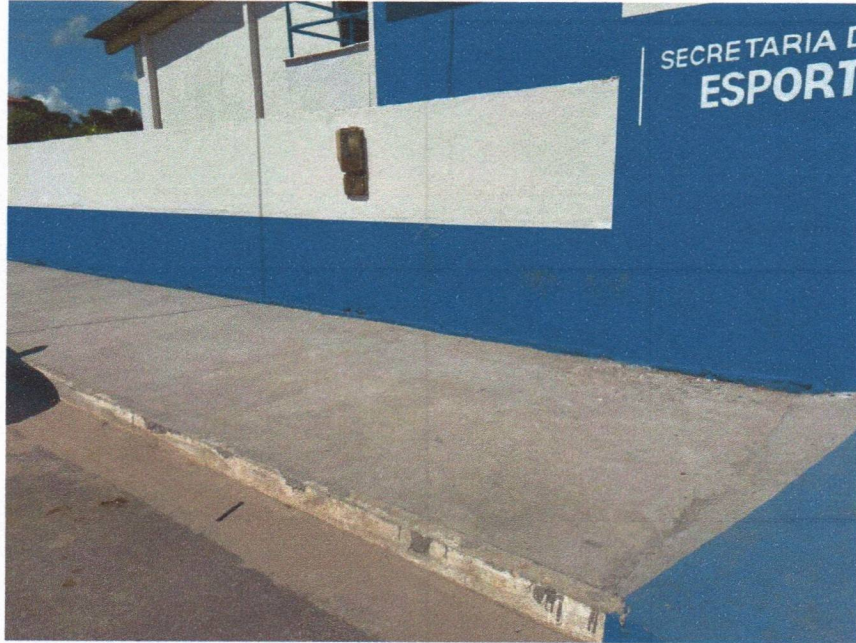
Imagem 3 – Execução da calçada externa do ginásio e pintura externa.
