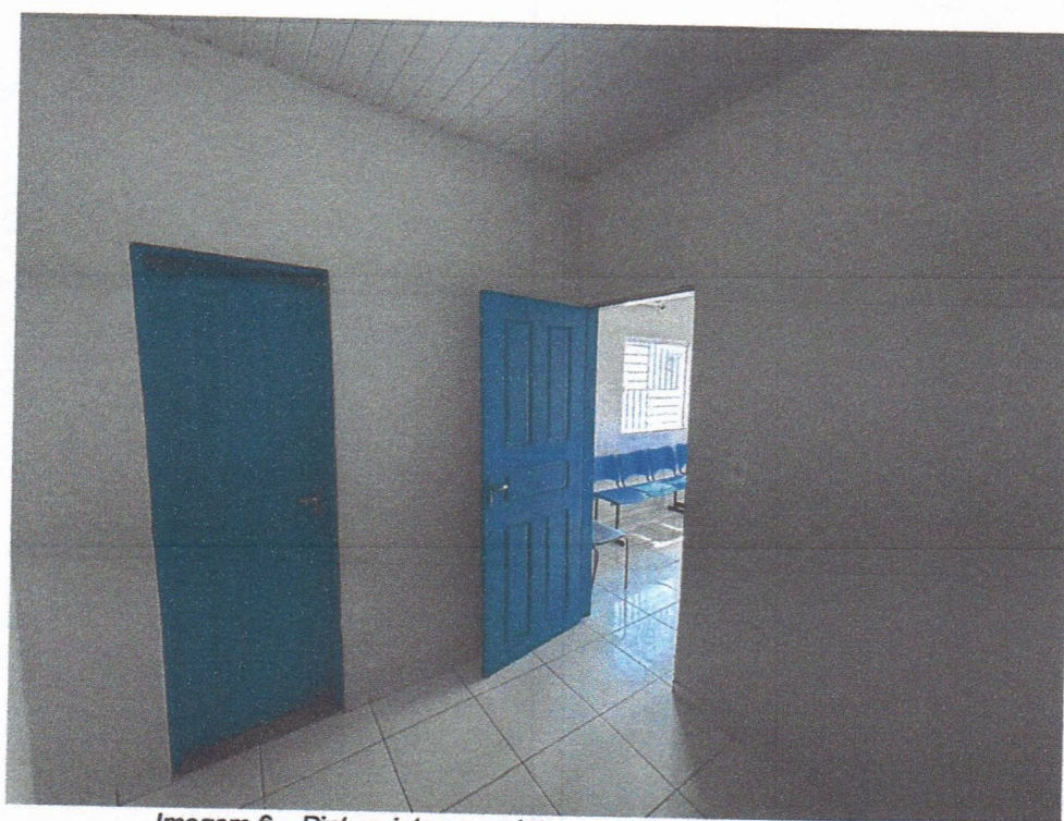
Imagem 6 – Pintura interna e pintura das esquadrias de madeira.
