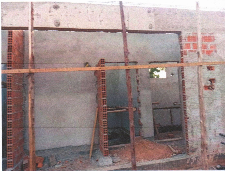
Imagem 6 – Execução da alvenaria, chapisco e reboco do vestiário.
