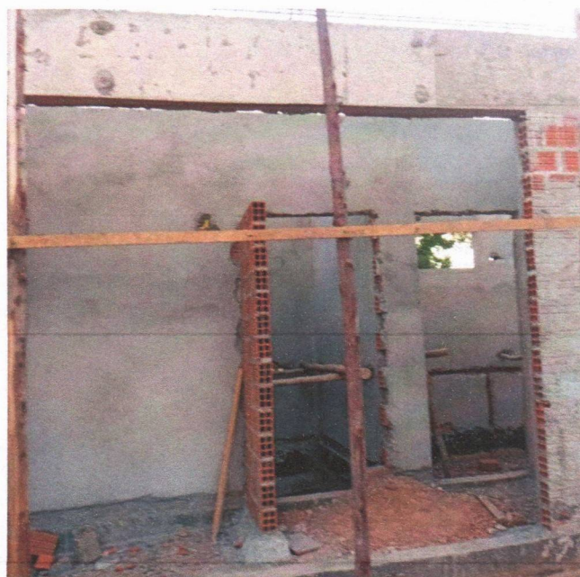
Imagem 07 – Serviços de reboco
