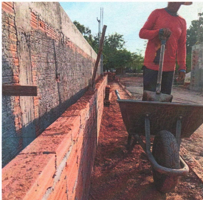
Imagem 13 – Serviços de alvenaria
