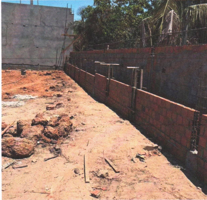
Imagem 02 – Serviços de alvenaria e estrutura de concreto
