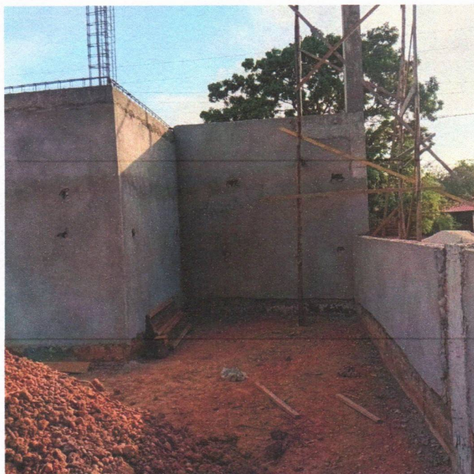
Imagem 14 – Serviços de reboco
