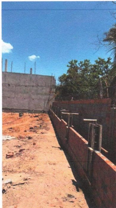
Imagem 4 – Execução da alvenaria e pilares das arquivancadas.
