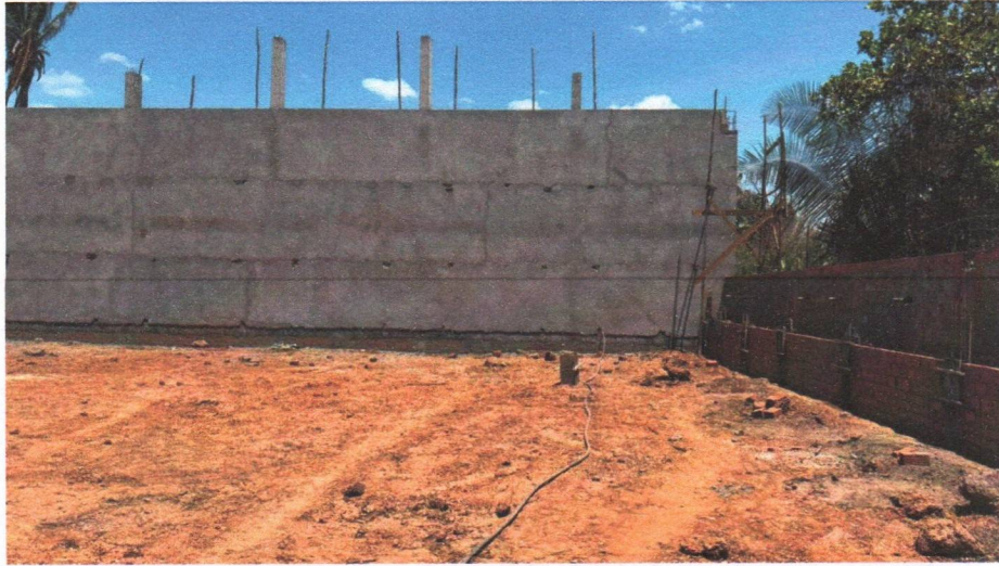
Imagem 3 - Execução dos pilares, chapisco e reboco interno da quadra.
