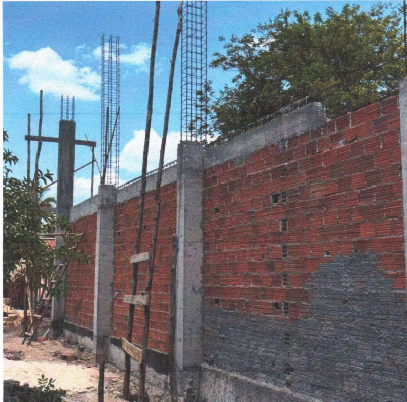
Imagem 06 – Serviços de alvenaria e estrutura de concreto
