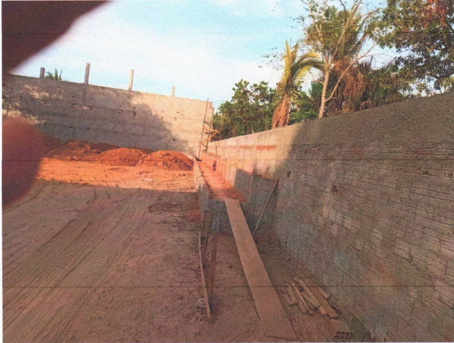
Imagem 5 – Execução do aterro das arquibancadas e da quadra.
