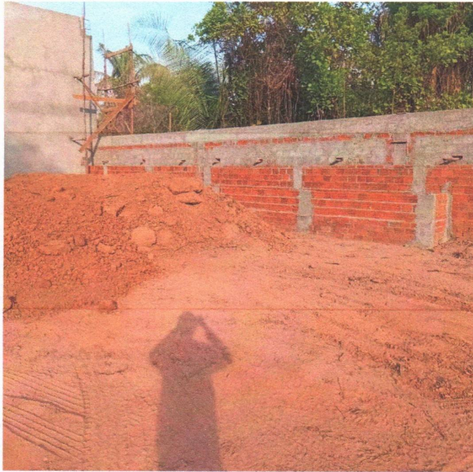
Imagem 08 – Serviços de movimentações de solos para aterro
