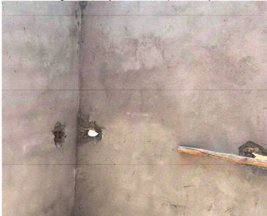
Imagem 05 – Serviços de reboco
