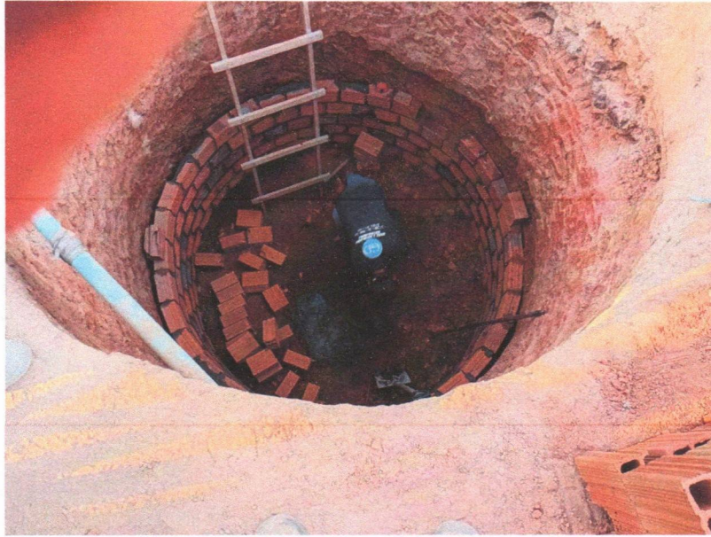
Imagem 7 – Execução do sumidouro em alvenaria.
