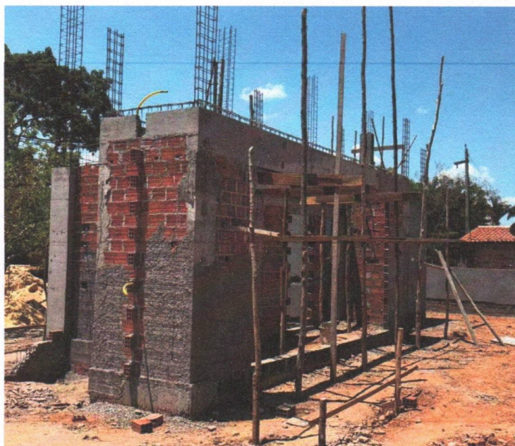
Imagem 01 – Serviços de alvenaria e estrutura de concreto
