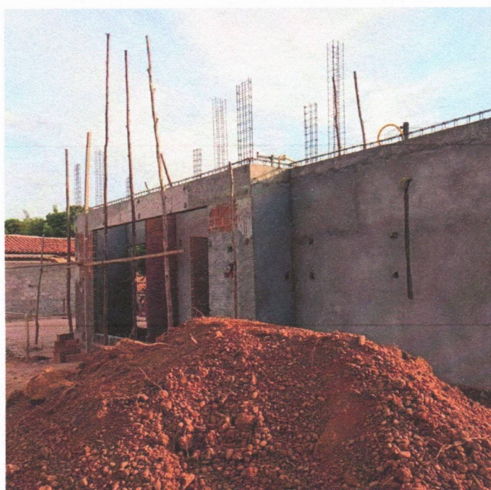
Imagem 11 – Serviços de reboco
