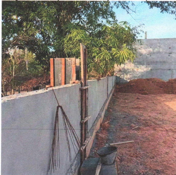
Imagem 09 – Serviços de reboco
