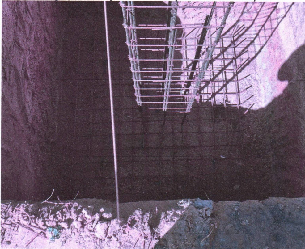
Imagem 05 – Serviços de movimentações de solos e fundações
