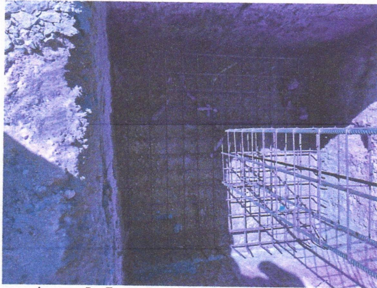
Imagem 5 – Execução das armações da sapata e pilares.
