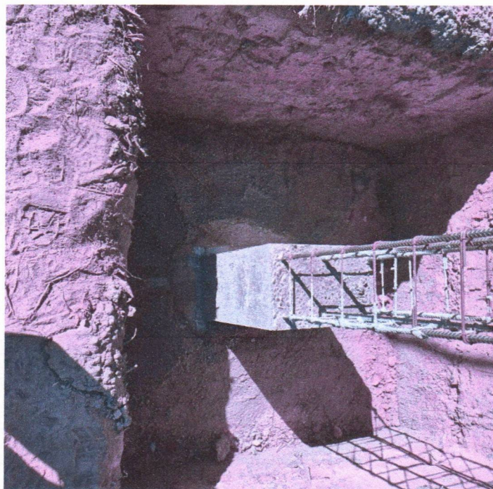
Imagem 07 – Serviços de movimentações de solos e fundações
