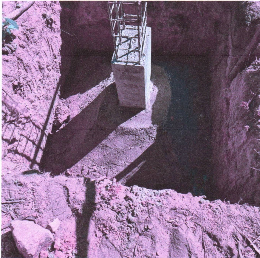
Imagem 06 – Serviços de movimentações de solos e fundações
