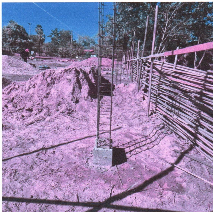
Imagem 11 – Serviços de movimentações de solos e fundações
