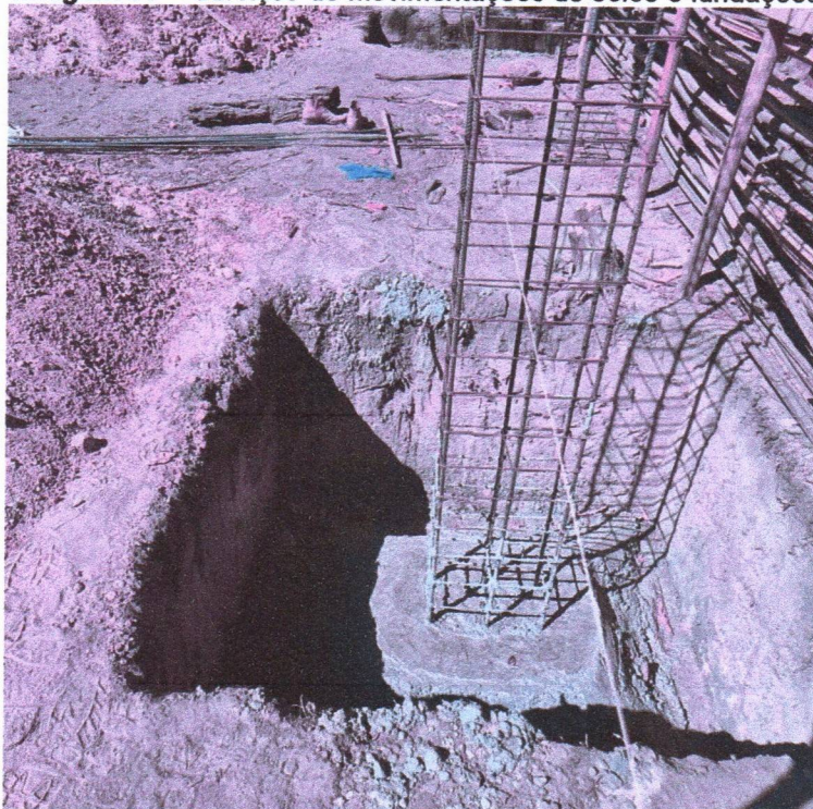
Imagem 09 – Serviços de movimentações de solos e fundações
