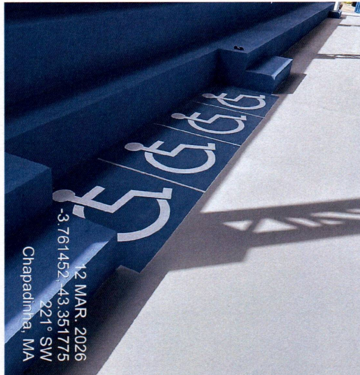
Imagem 06 – Serviços de pintura
