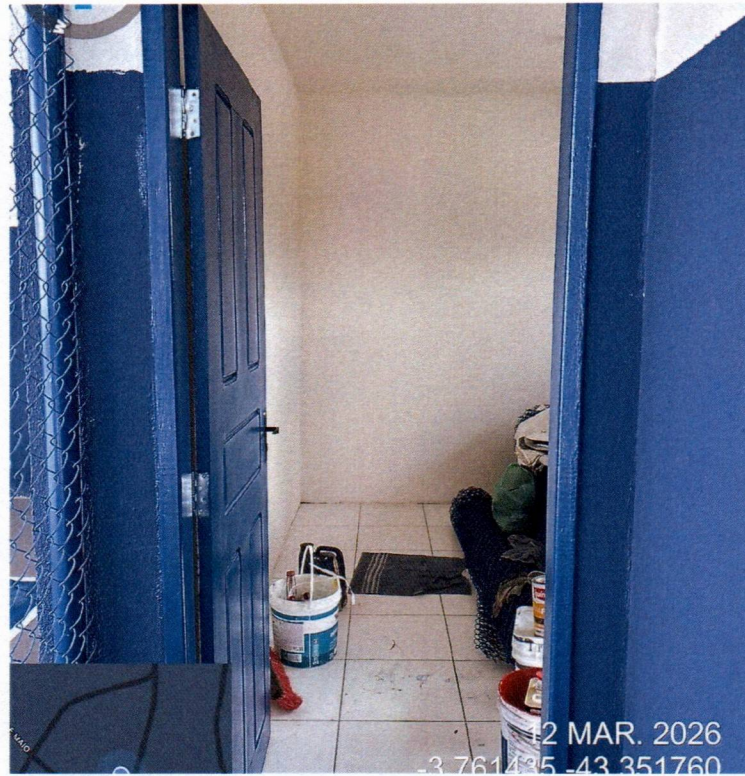
Imagem 02 – Serviços de pintura de esquadrias
