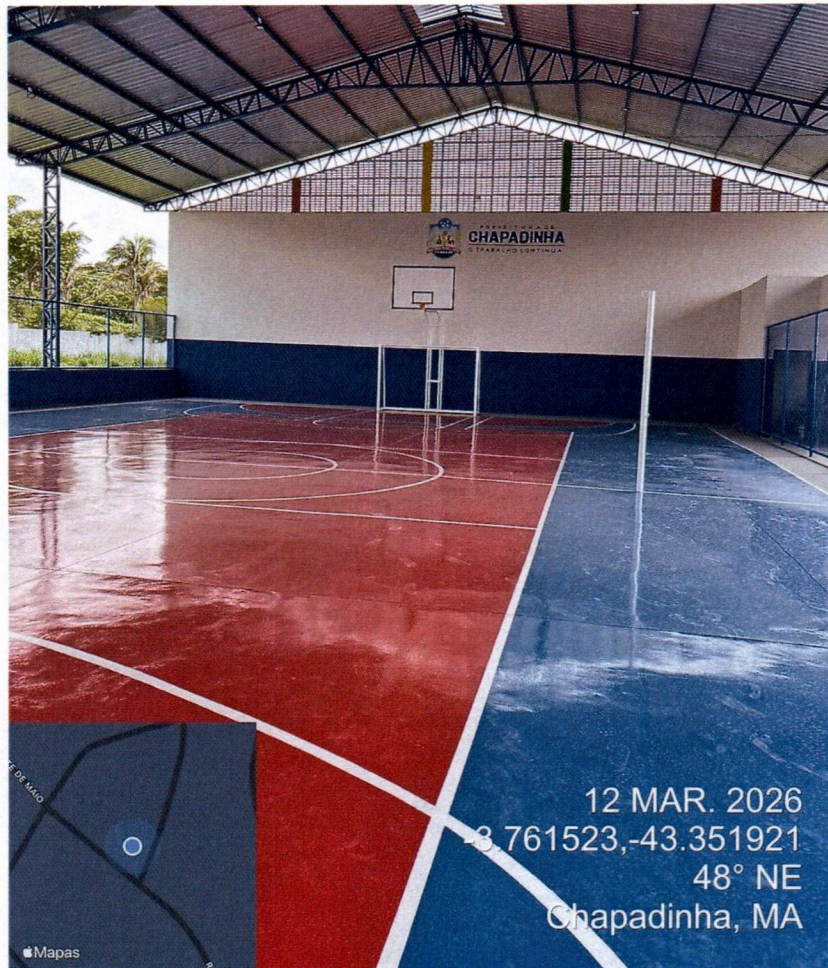
Imagem 10 – Serviços de pintura
