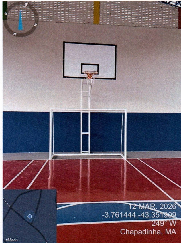
Imagem 04 – Serviços de pintura e equipamentos
