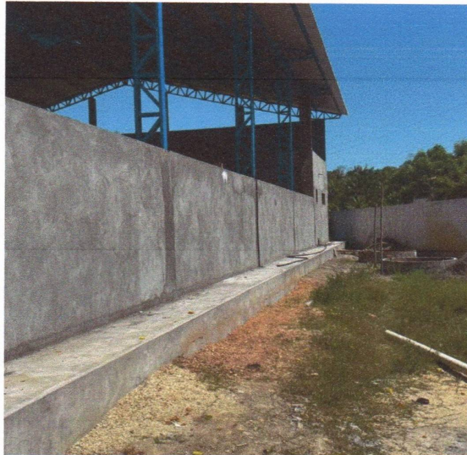
Imagem 02 – Serviços de reboco e calçada
