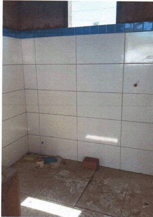
Imagem 12 – Serviços de revestimentos cerâmicos
