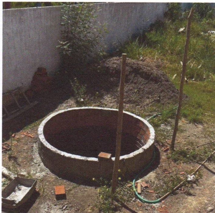
Imagem 09 – Serviços de fossa
