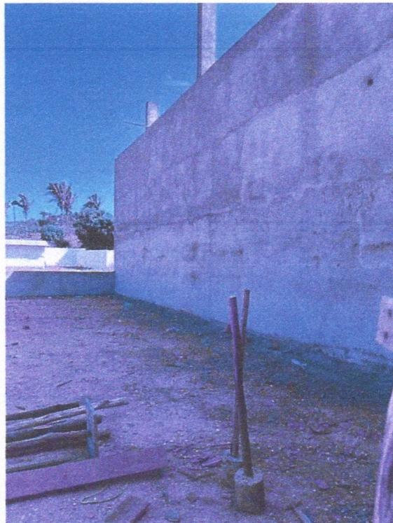
Imagem 03 – Serviços de Reboco
