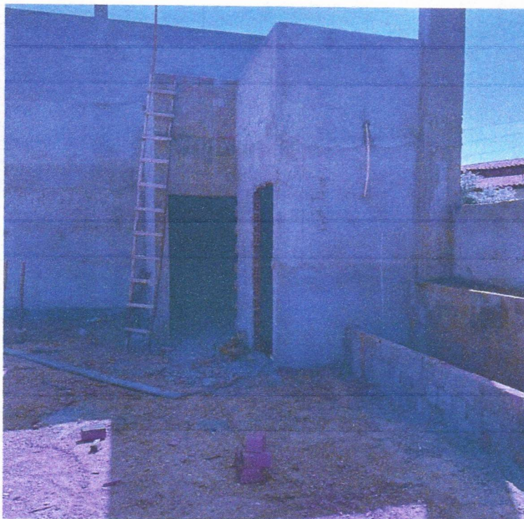
Imagem 10 – Serviços de reboco
