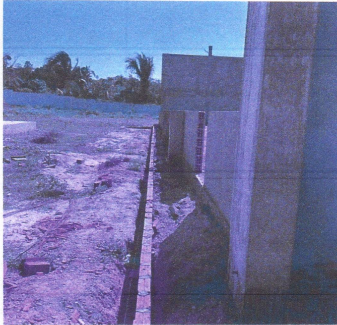
Imagem 02 – Serviços de reboco e calçada
