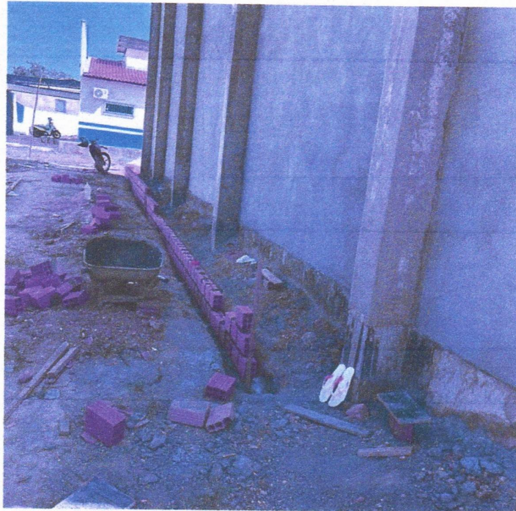
Imagem 08 – Serviços de reboco e calçada
