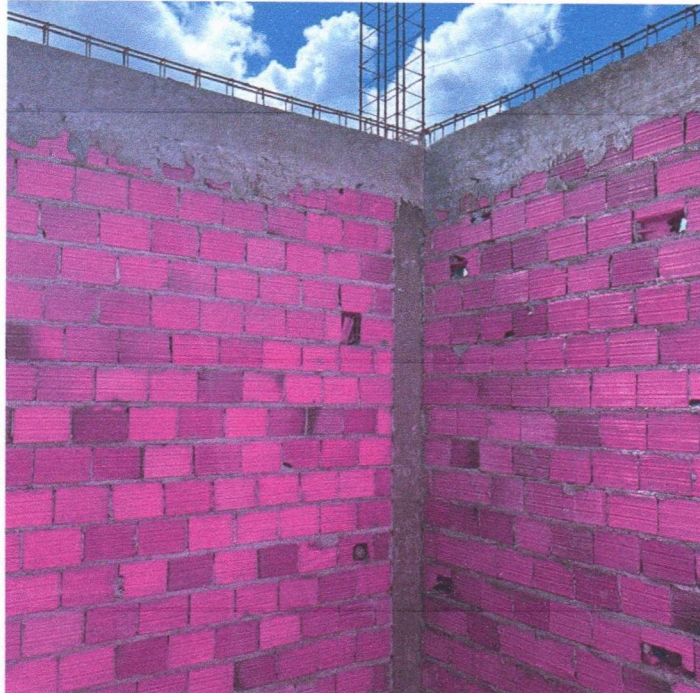
Imagem 19 – Serviços de alvenaria.
