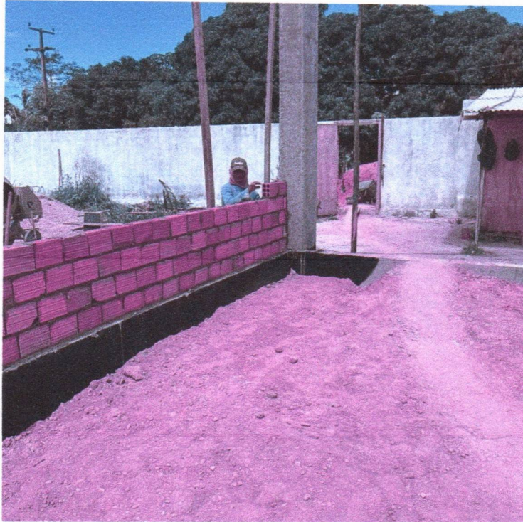
Imagem 15 – Serviços de alvenaria.
