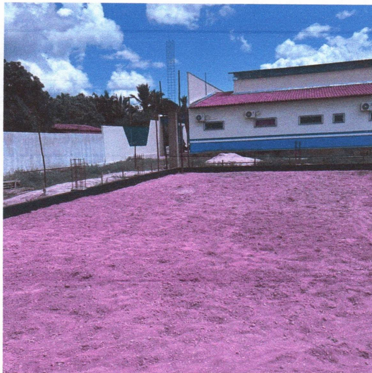
Imagem 14 – Serviços de impermeabilização.
