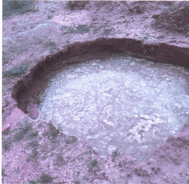
Imagem 02 – Serviços de fundações.
