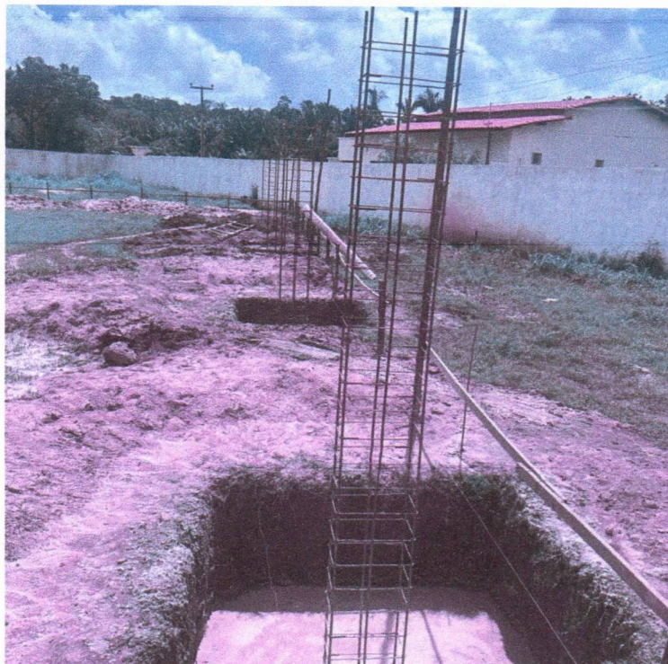
Imagem 10 – Serviços de fundações.
