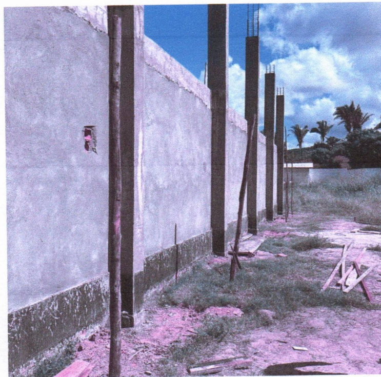
Imagem 22 – Serviços de reboco.
