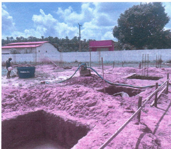
Imagem 01 – Serviços de fundações.
