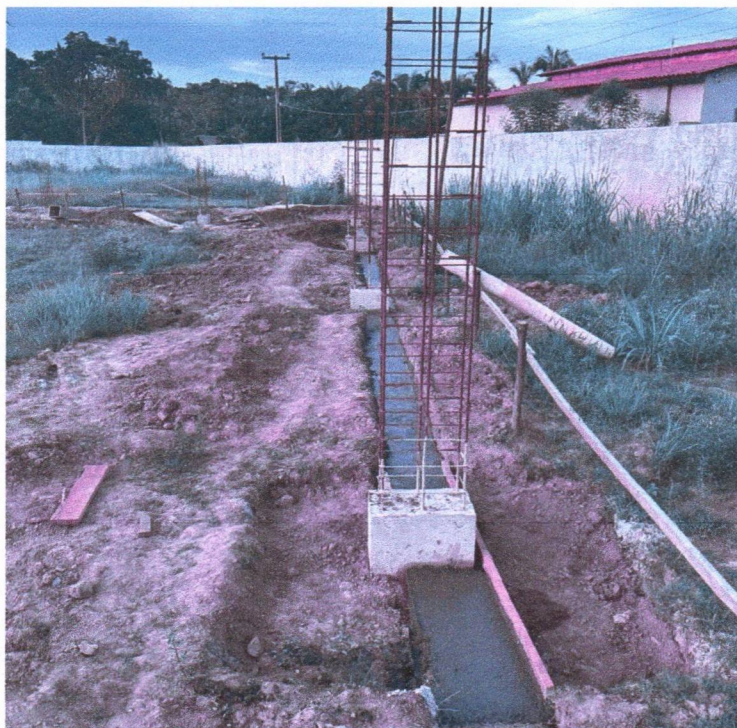
Imagem 12 – Serviços de fundações.
