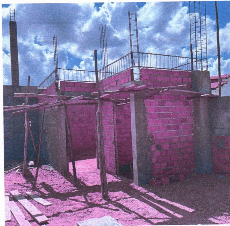
Imagem 18 – Serviços de alvenaria.
