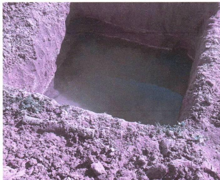
Imagem 05 – Serviços de fundações.
