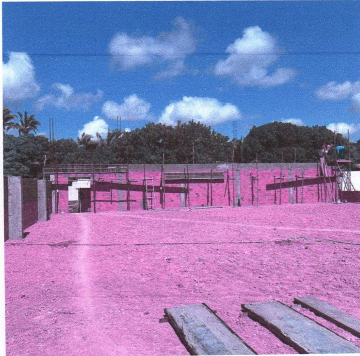
Imagem 17 – Serviços de alvenaria.
