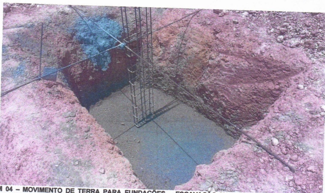
IMAGEM 03 – MOVIMENTO DE TERRA PARA FUNDAÇÕES – ESCAVAÇÃO MANUAL PARA VIGA BALDRAME OU SAPATAS CORRIDA; PREPARO DE FUNDO DE VALA COM LARGURA MAIOR A 1,5M E MENOR QUE 2,5M; LASTRO DE CONCRETO MAGRO, APLICADO EM BLOCO DE COROAMENTO OU SAPATAS; ARMAÇÃO DE ESTRUTURAS DIVERSAS DE CONCRETO ARMADO, UTILIZANDO AÇO CA-50 DE 10,0MM; CONCRETAGEM DE SAPATA, FCK 30 MPA.
