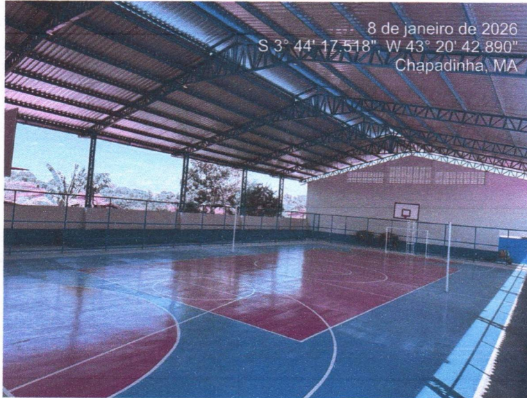
IMAGEM 11: execução de alambrado e drenagem de águas pluviais
