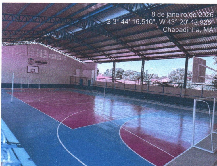
IMAGEM 12: execução de alambrado e drenagem de águas pluviais
