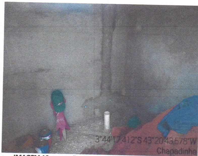
IMAGEM 10: execução de instalações hidráulicas e sanitárias
