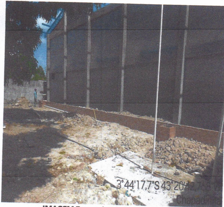
IMAGEM 7: paredes do fundo rebocadas
