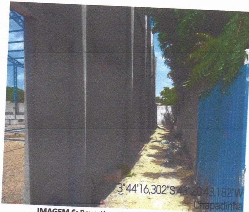
IMAGEM 6: Revestimento em paredes - Reboco
