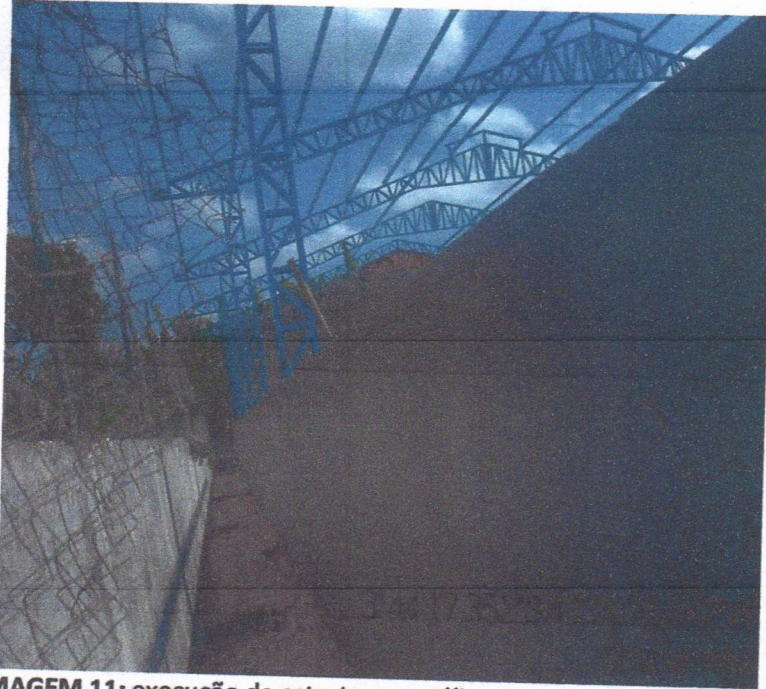
IMAGEM 11: execução de estrutura metálica e parede lateral rebocada
