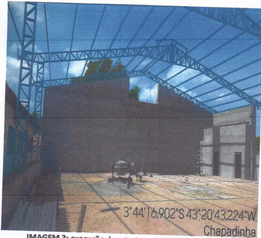
IMAGEM 3: execução da estrutura metálica da cobertura
