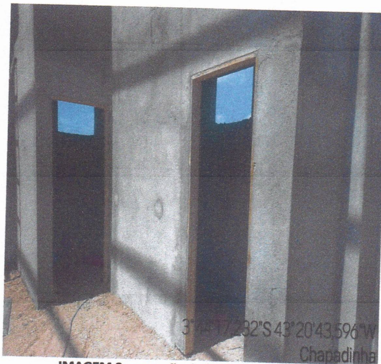
IMAGEM 8: execução do banheiro e depósito
