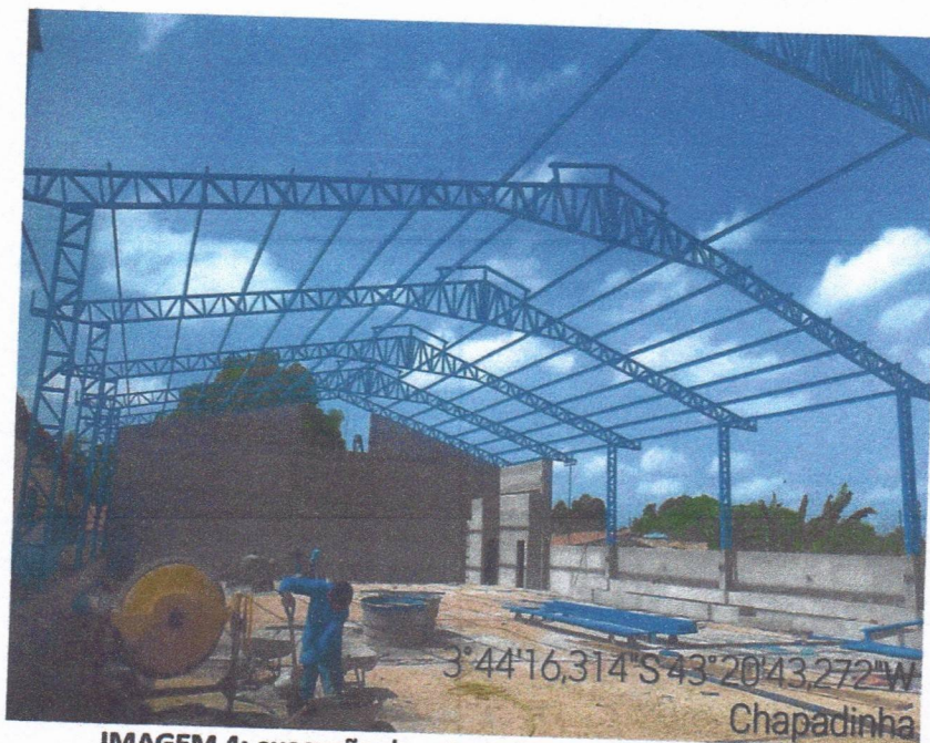
IMAGEM 4: execução da estrutura metálica da cobertura
