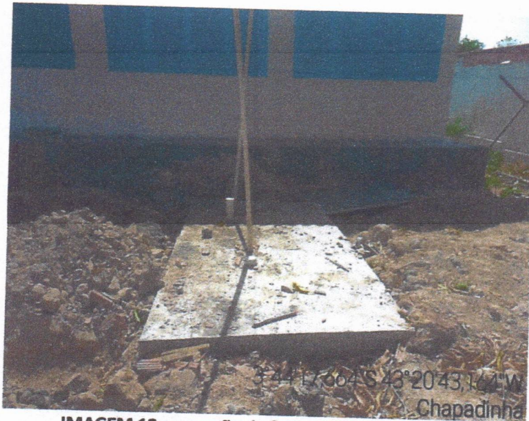
IMAGEM 12: execução de fossa séptica e bebedouro
