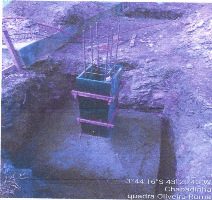
IMAGEM 7: concretagem das sapatas
