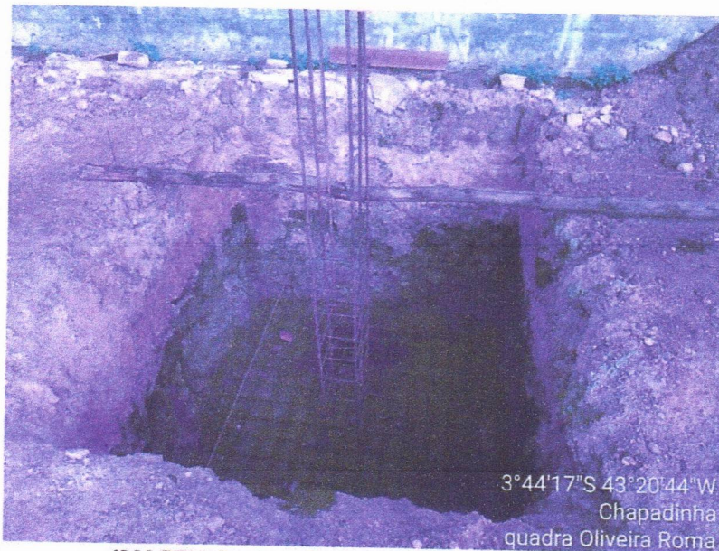
IMAGEM 6: armação das sapatas de fundações
