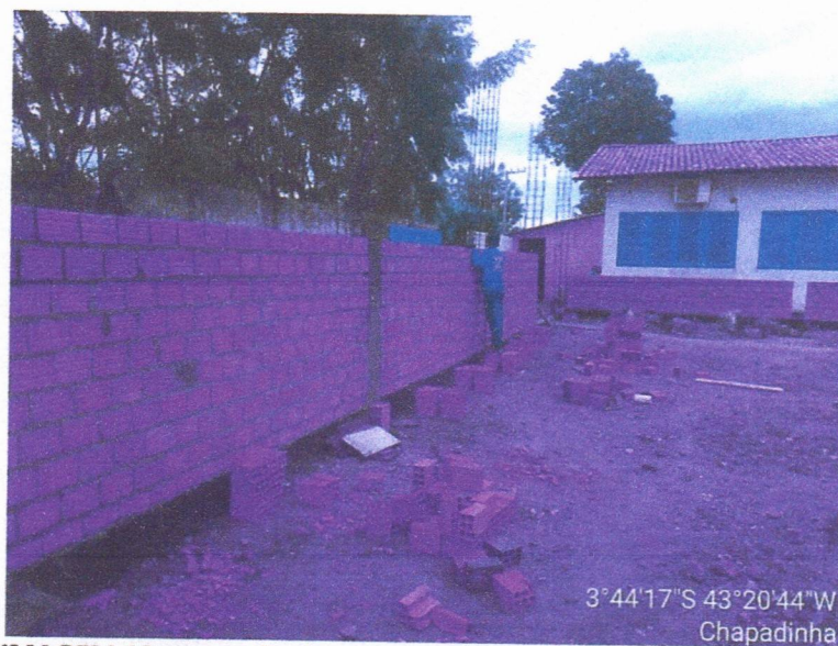
IMAGEM 12: execução de paredes em alvenaria de tijolos cerâmicos
