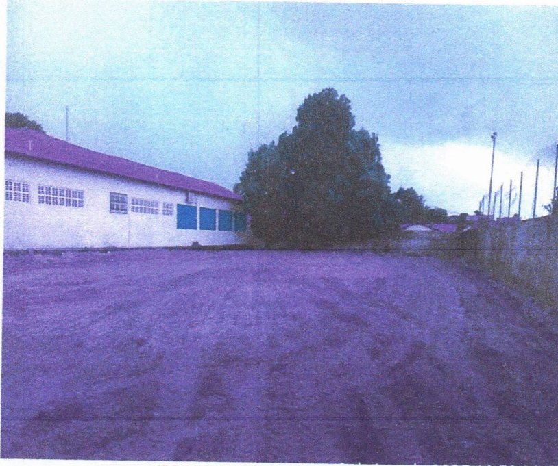
IMAGEM 3: limpeza do terreno
