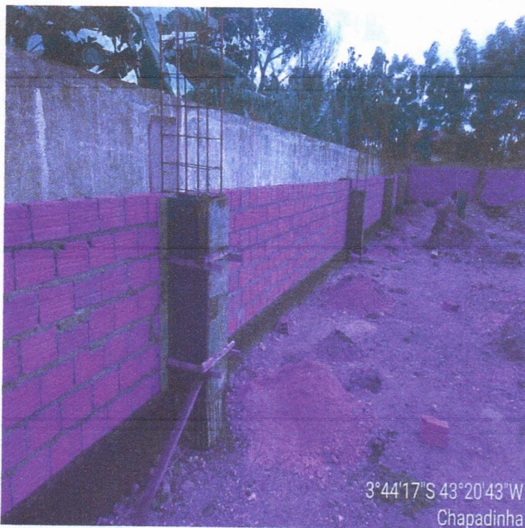
IMAGEM 11: execução dos pilares e paredes de alvenaria de tijolos cerâmicos
