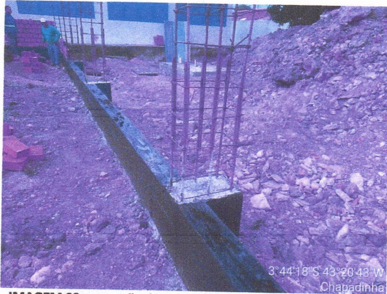
3°44'18" S 43°20'43" W Chapadinha IMAGEM 09: execução das vigas baldrame e impermeabilização
