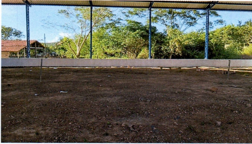
Imagem 9 – Execução do nivelamento do aterro para o piso de concreto da quadra.
