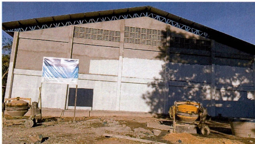
Imagem 1 – Execução da cobertura metálica e aplicação do fundo selador na parte externa da quadra.
