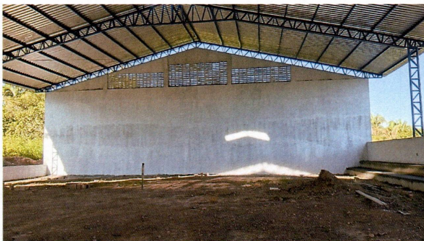
Imagem 2 – Execução da cobertura metálica e aplicação do fundo selador na parte interna da quadra.
