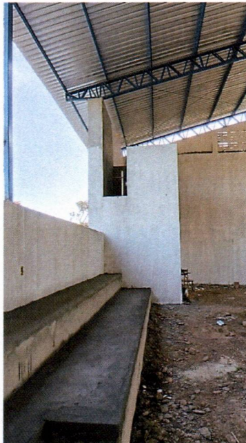
Imagem 8 – Execução do piso da arquivada.
