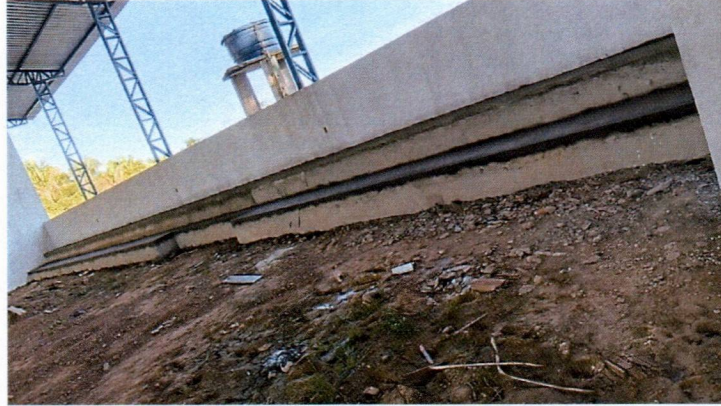
Imagem 7 – Execução do piso da arquivada.
