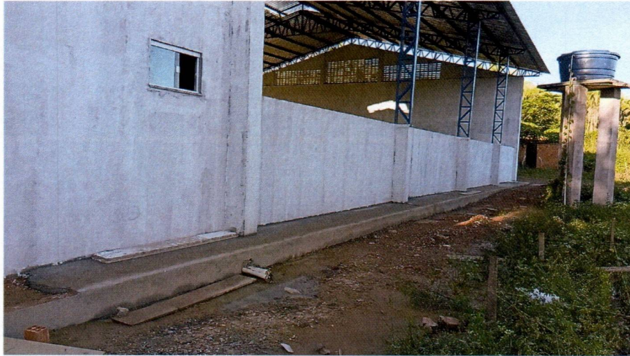
Imagem 3 – Execução da cobertura metálica e aplicação do fundo selador na parte externa da quadra.
