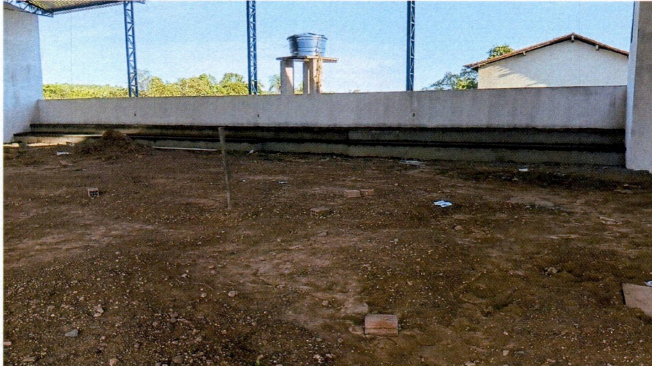
Imagem 4 – Execução da cobertura metálica e aplicação do fundo selador na parte interna da quadra.
