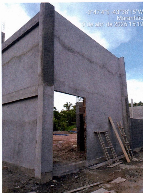
Imagem 5 – Execução do reboco externo da quadra.
