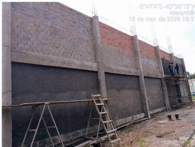
Imagem 2 – Execução da alvenaria, chapisco, reboco e armação das vigas superiores.
