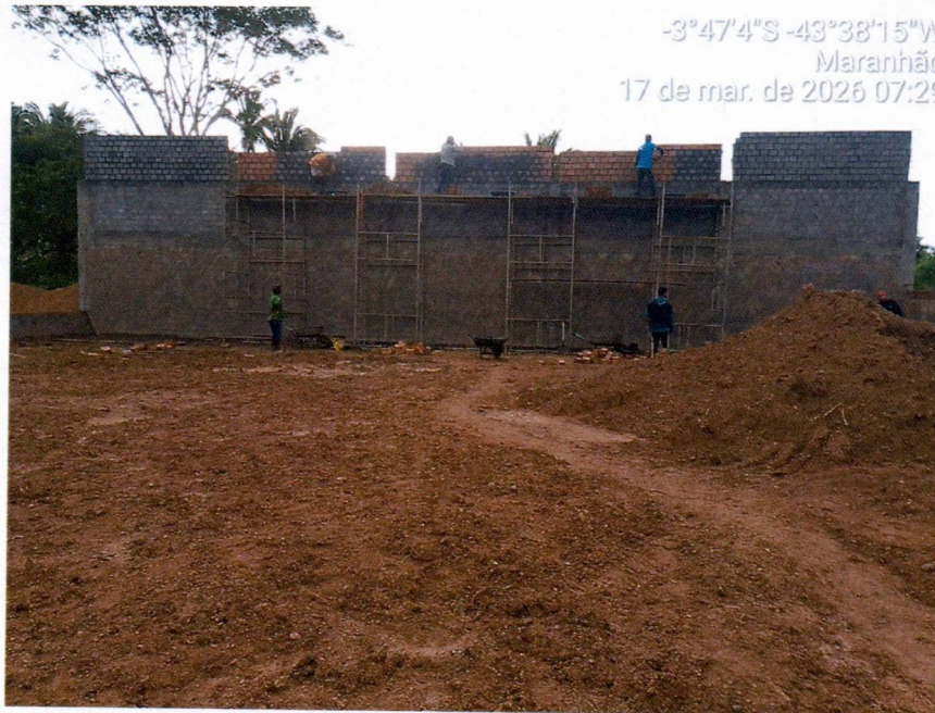
Imagem 3 – Execução da alvenaria, chapisco e reboco.
