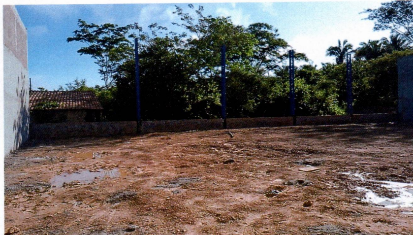
Imagem 11 – Instalação dos pilares da cobertura metálica.
