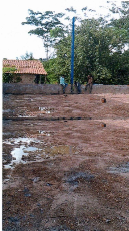
Imagem 10 – Instalação dos pilares da cobertura metálica.
