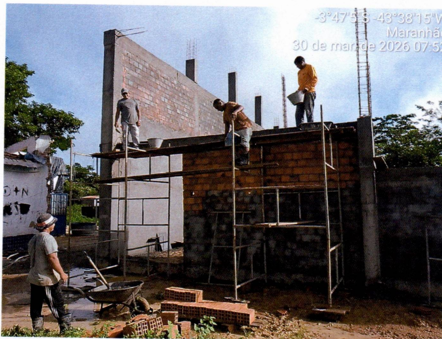
Imagem 4 – Execução da alvenaria, chapisco e reboco.
