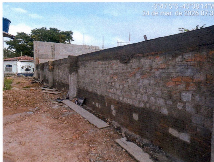
Imagem 8 – Execução do chapisco e reboco externo.
