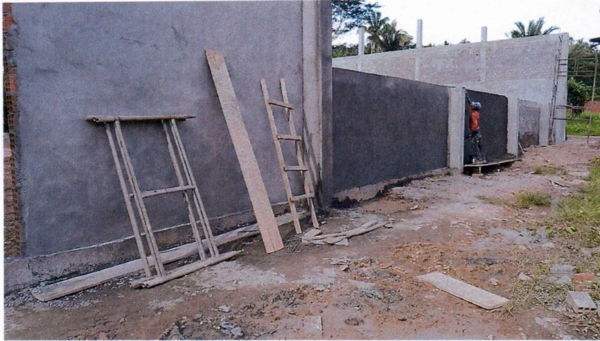
Imagem 9 – Execução do reboco externo.
