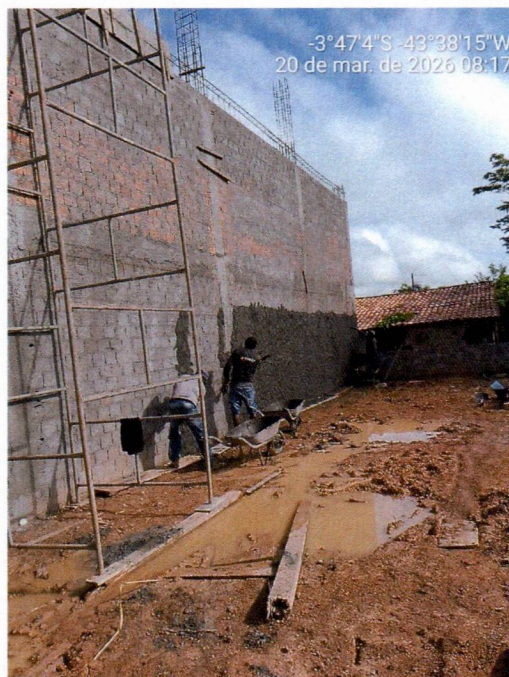
Imagem 6 – Execução do reboco interno da quadra.
