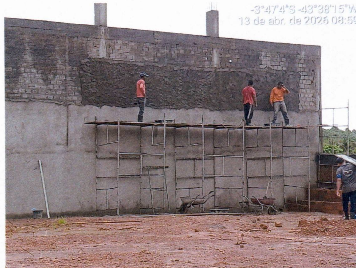
Imagem 7 – Execução das vigas superiores, alvenaria, pilares, chapisco e reboco.
