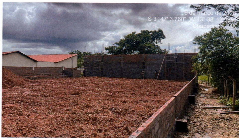
Imagem 8 – Execução do aterro da quadra.
