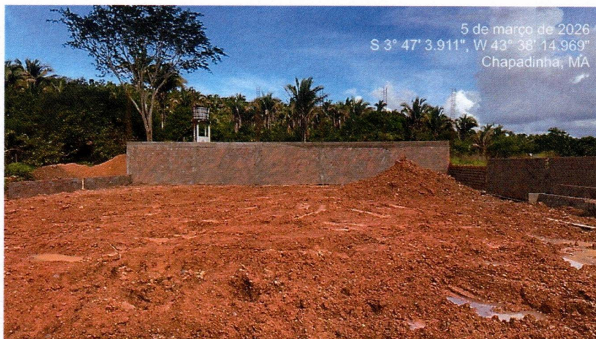
Imagem 9 – Execução do aterro da quadra.
