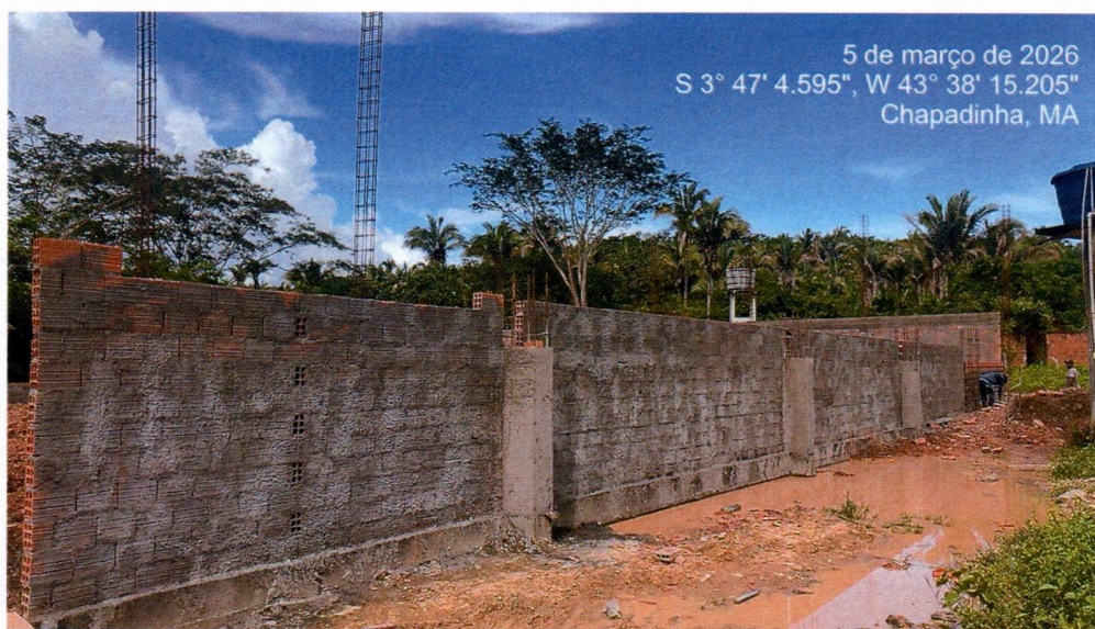
Imagem 6 – Execução das vigas baldrame, alvenaria, pilares e chapisco.
