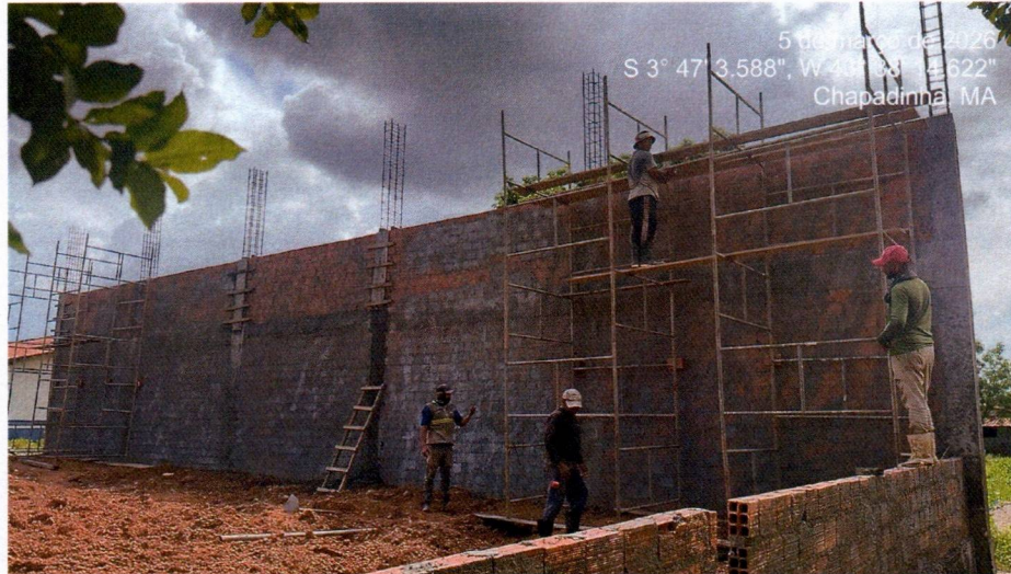
Imagem 3 – Execução das vigas baldrame, alvenaria, pilares, vigas superiores e chapisco.
