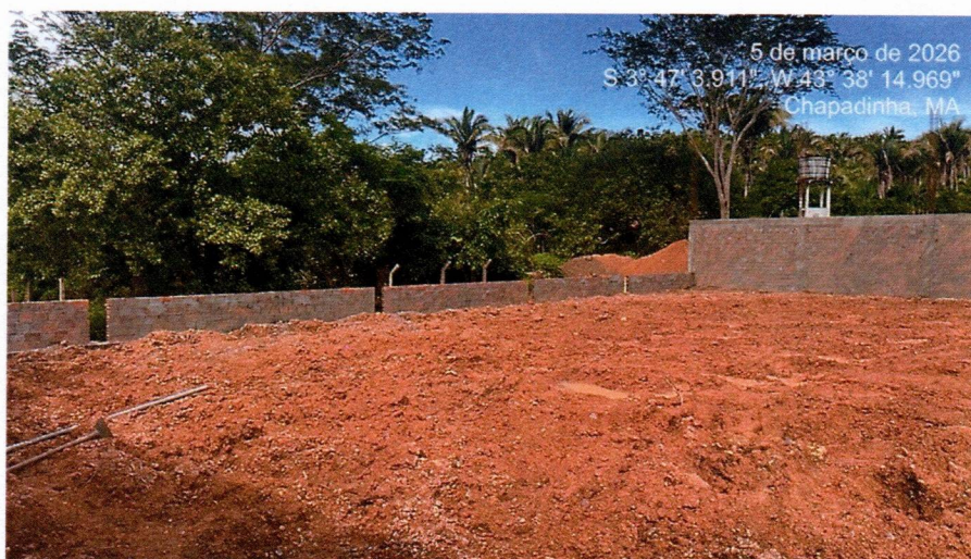
Imagem 10 – Execução do aterro da quadra.
