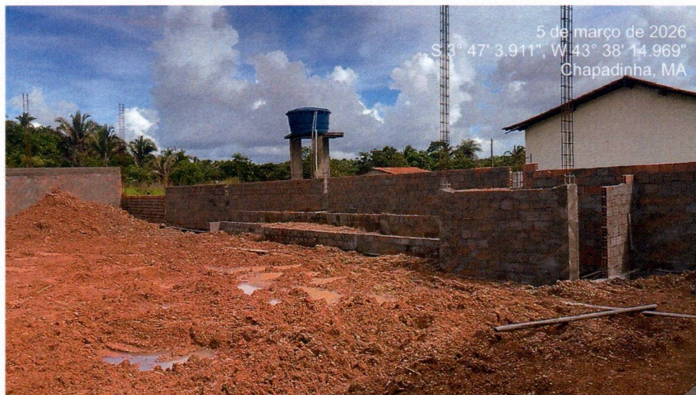
Imagem 5 – Execução das vigas baldrame, alvenaria, pilares, aterro da quadra e chapisco na alvenaria.
