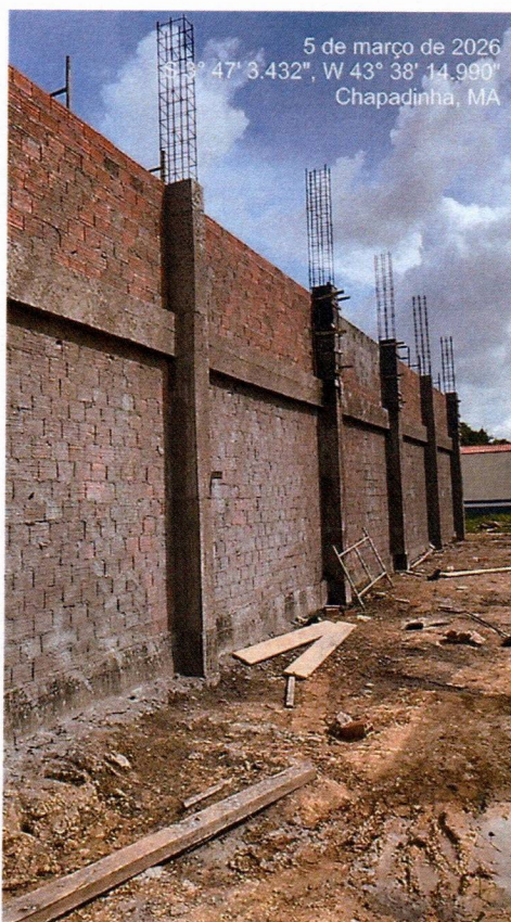
Imagem 2 – Execução das vigas baldrame, alvenaria, pilares, vigas superiores e chapisco.
