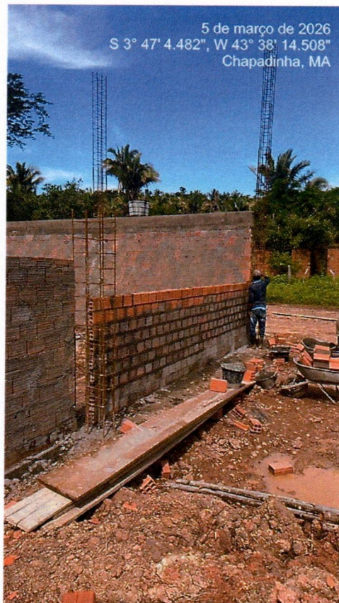
Imagem 7 – Execução das vigas baldrame, alvenaria, pilares e chapisco.
