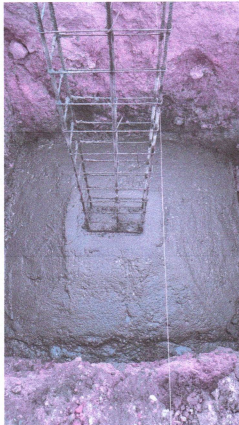
Imagem 11 – Execução da concretagem das sapatas.
