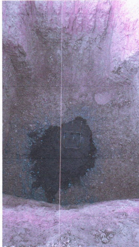
Imagem 9 – Execução da concretagem das estacas.
