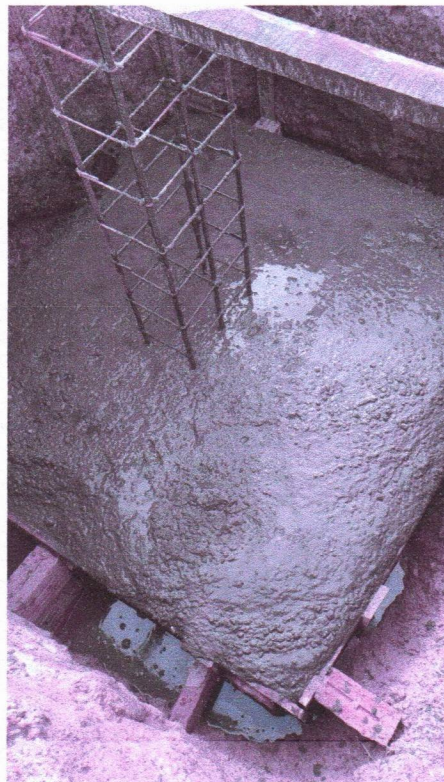
Imagem 12 – Execução da concretagem das sapatas.
