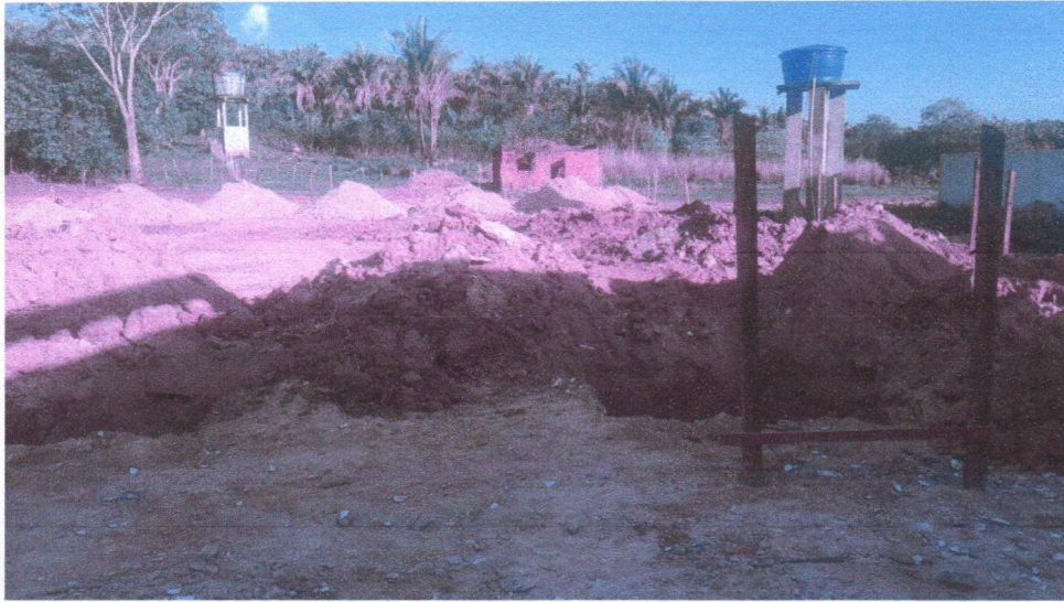
Imagem 5 – Execução da escavação da fundação.
