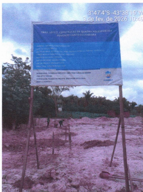
Imagem 1 – Instalação de placa de obra.
