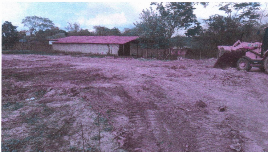
Imagem 2 – Limpeza mecanizada do terreno e terraplanagem.
