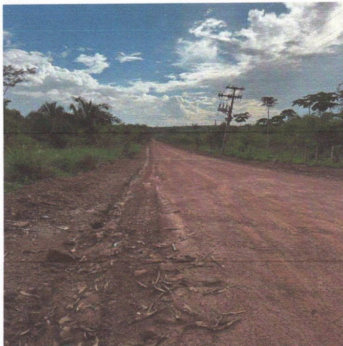
Imagens 21,22,23: Terraplenagem ecexutada.
