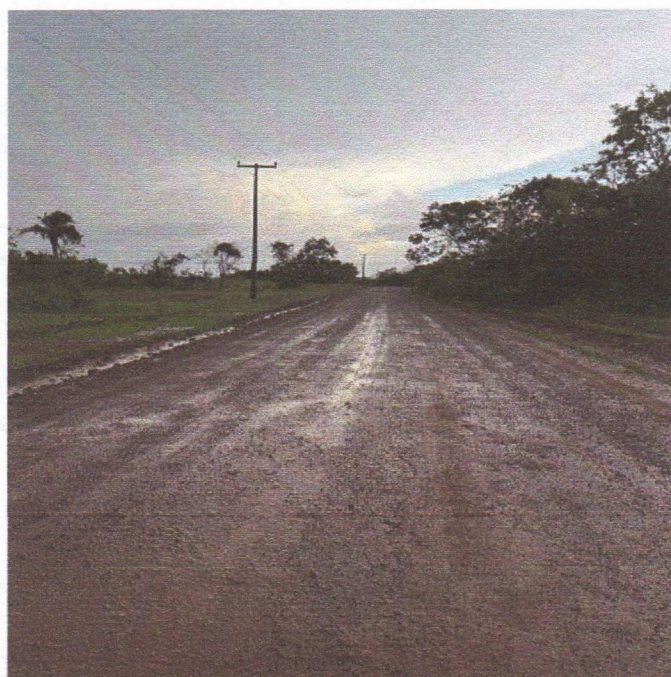
Imagens 19 e 20 : Trecho Concluído.
