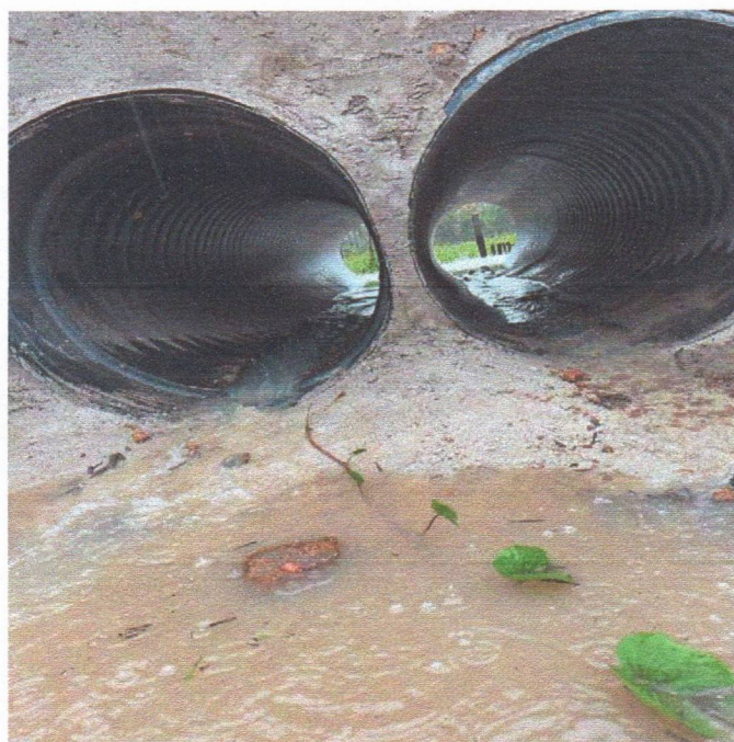
Imagem 18 : Obras de arte corrente (BDTC executado)
