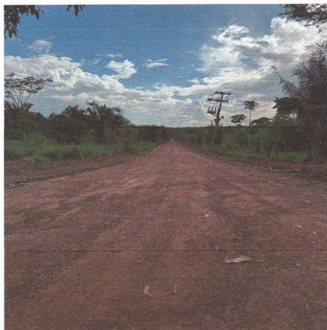
Imagem 3 e 4 : Revestimento primário compactado.
