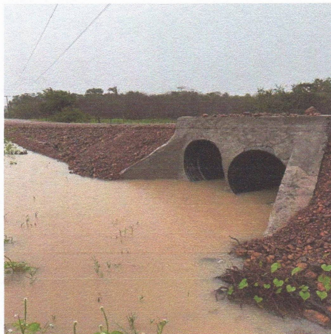
Imagem 25 e 26 : Terraplenagem e BDTC executados.
