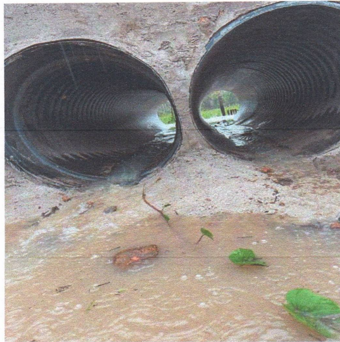
Imagem 11 : Obras de arte corrente( BDTTC executado)
