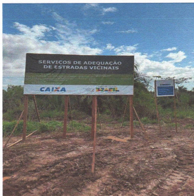
Imagem 1 e 2 : Terraplenagem executada e Placa indicativa de obra.
