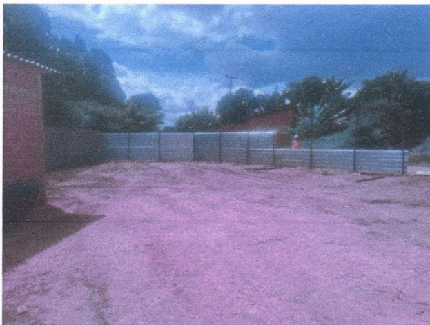
Tapume com telha metálica
