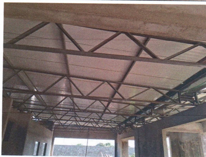
Estrutura metálica e cobertura em telha termoacústica
