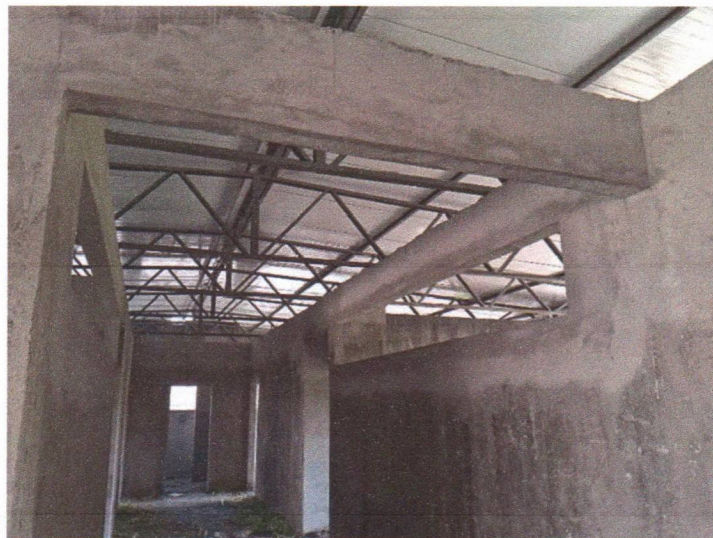
Avanço de acabamento de reboco
