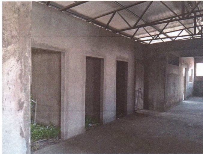
Avanço de acabamento de reboco
