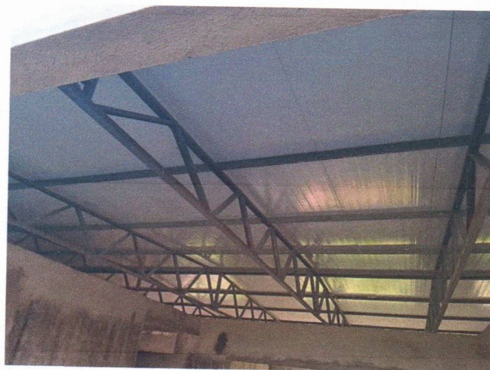
Estrutura metálica e cobertura em telha termoacústica
