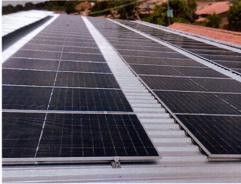
Imagem 11 – Instalações de painéis na quadra coberta da escola UI Professor Oliveira Roma no bairro Corrente
