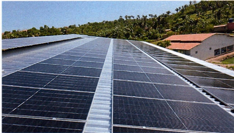
Imagem 01 – Instalações de painéis na quadra coberta da escola Jardim de Infância Antônio Lopes Lima no bairro Liberdade
