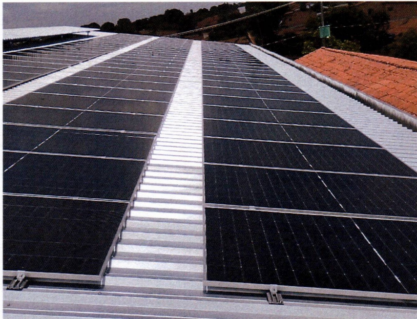
Imagem 08 – Instalações de painéis na quadra coberta da escola UI Professor Oliveira Roma no bairro Corrente
