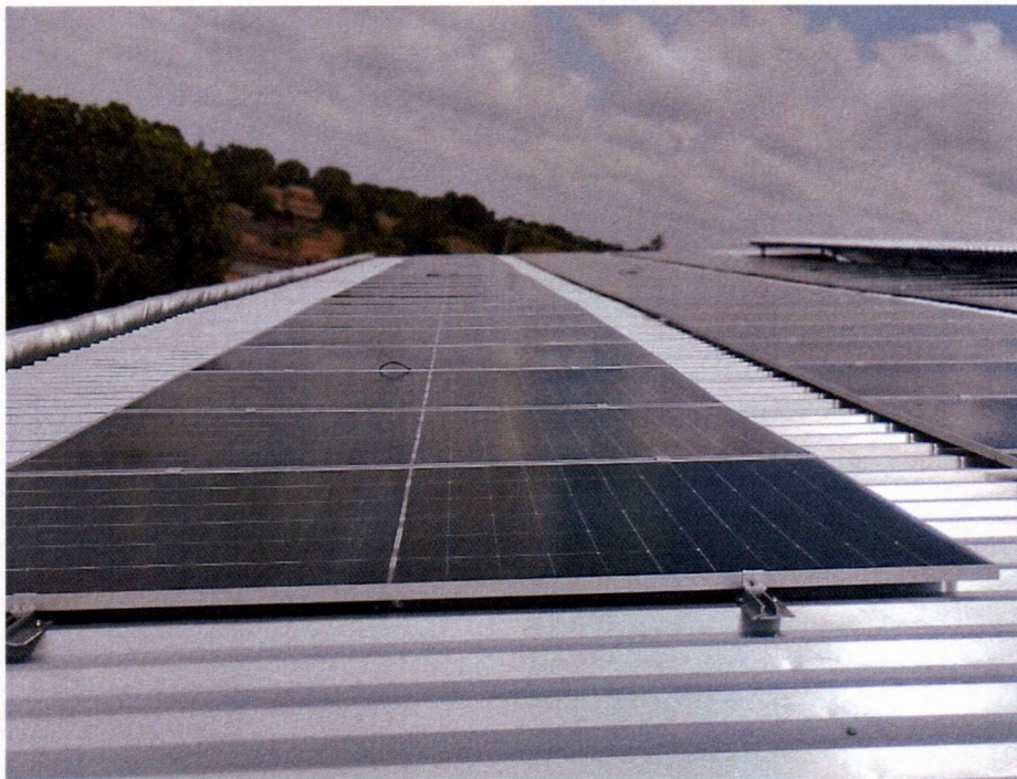
Imagem 10 – Instalações de painéis na quadra coberta da escola UI Professor Oliveira Roma no bairro Corrente
