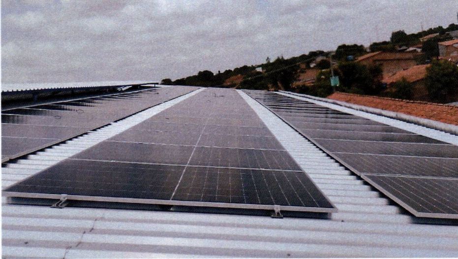
Imagem 07 – Instalações de painéis na quadra coberta da escola UI Professor Oliveira Roma no bairro Corrente
