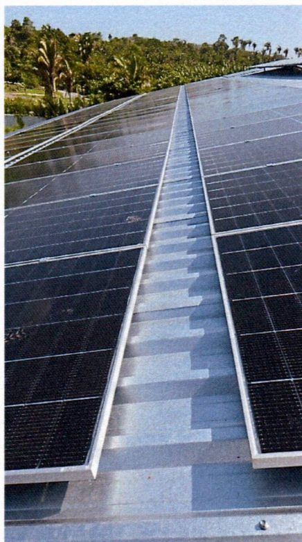
Imagem 04 – Instalações de painéis na quadra coberta da escola Jardim de Infância Antônio Lopes Lima no bairro Liberdade
