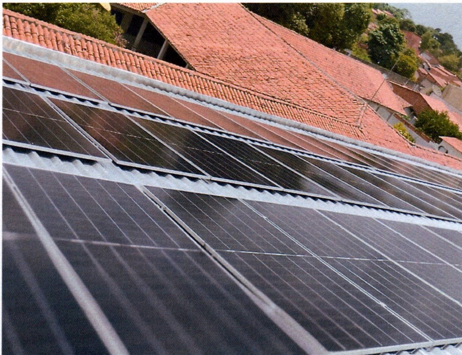
Imagem 12 – Instalações de painéis na quadra coberta da escola UI Professor Oliveira Roma no bairro Corrente
