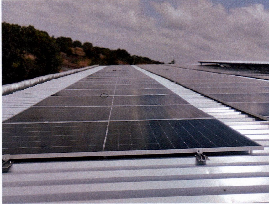
Imagem 09 – Instalações de painéis na quadra coberta da escola UI Professor Oliveira Roma no bairro Corrente
