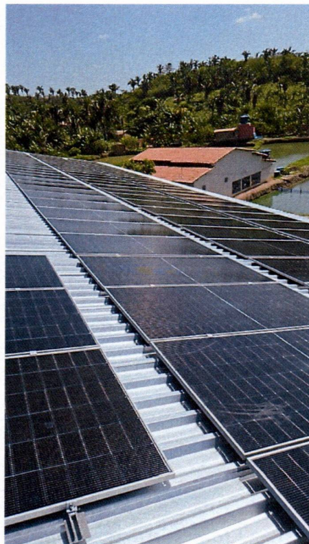
Imagem 02 – Instalações de painéis na quadra coberta da escola Jardim de Infância Antônio Lopes Lima no bairro Liberdade
