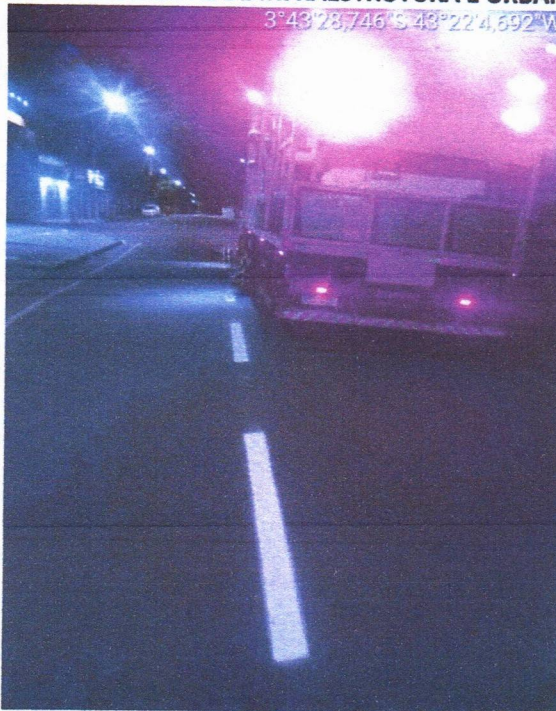
Imagem 02 – SERVIÇOS DE PINTURA DE FAIXAS E EIXOS
