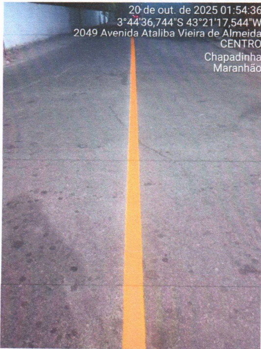
Imagem 06 – SERVIÇOS DE PINTURA E TACHÕES
