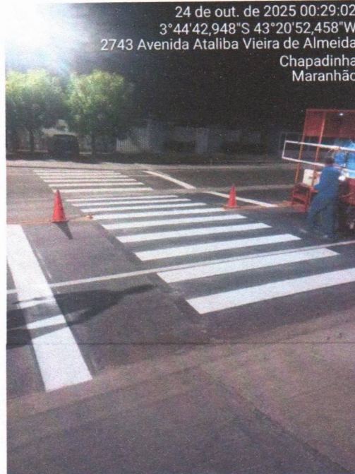
Imagem 09 – SERVIÇOS DE PINTURA E TACHÕES
