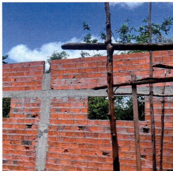
Imagem 08 – Serviços de estrutura e alvenaria
