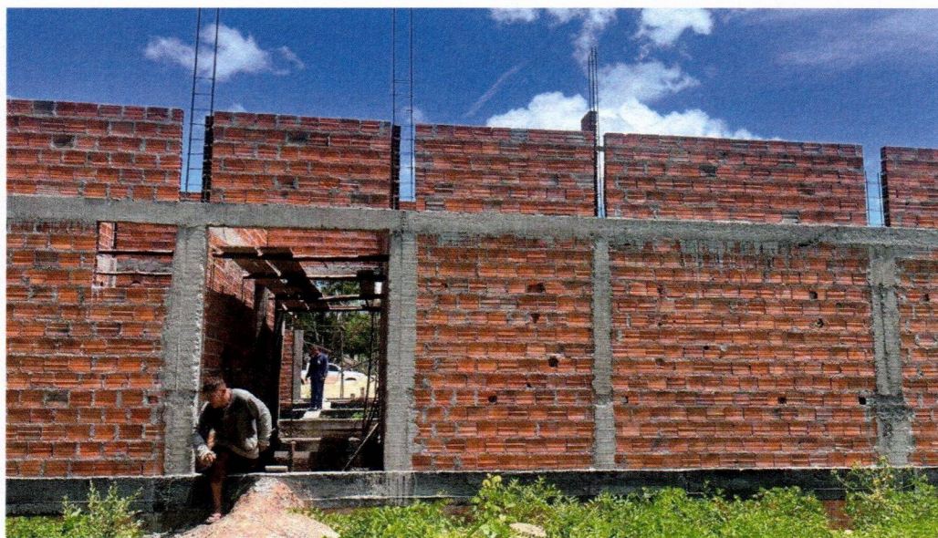
Imagem 03 – Serviços de estrutura e alvenaria.
