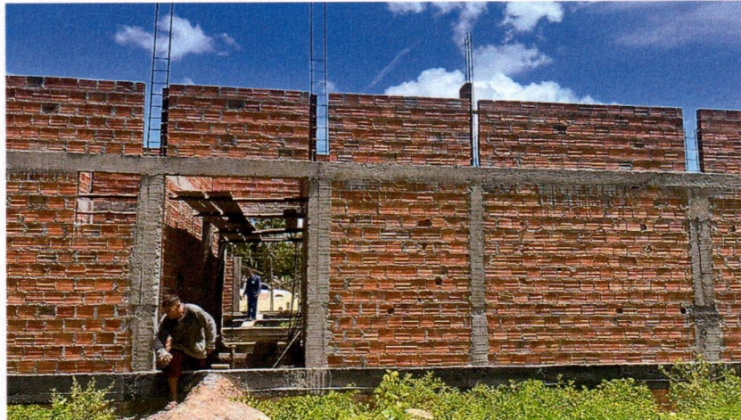
Imagem 5 – Execução da alvenaria, concretagem dos pilares e armação das vigas superiores.
