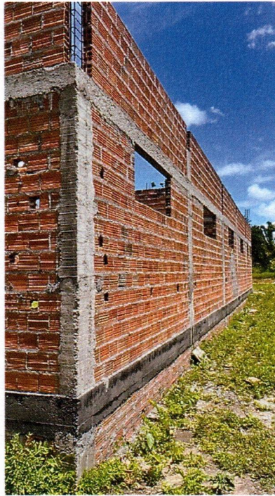
Imagem 3 – Execução da alvenaria, concretagem dos pilares e armação das vigas superiores.
