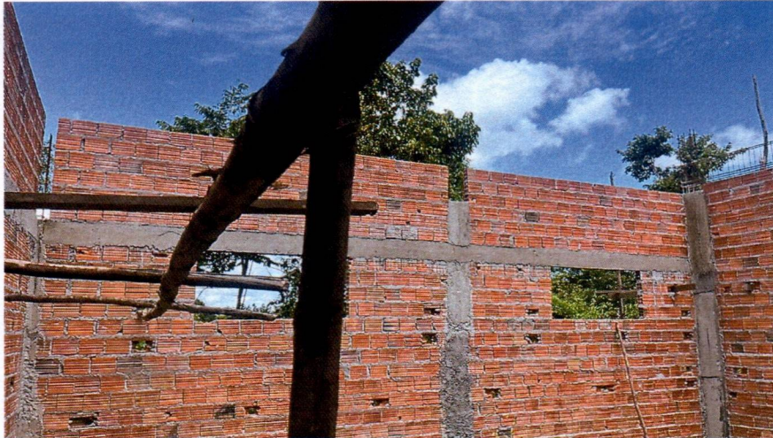
Imagem 7 – Execução da alvenaria, concretagem dos pilares e armação das vigas superiores.
