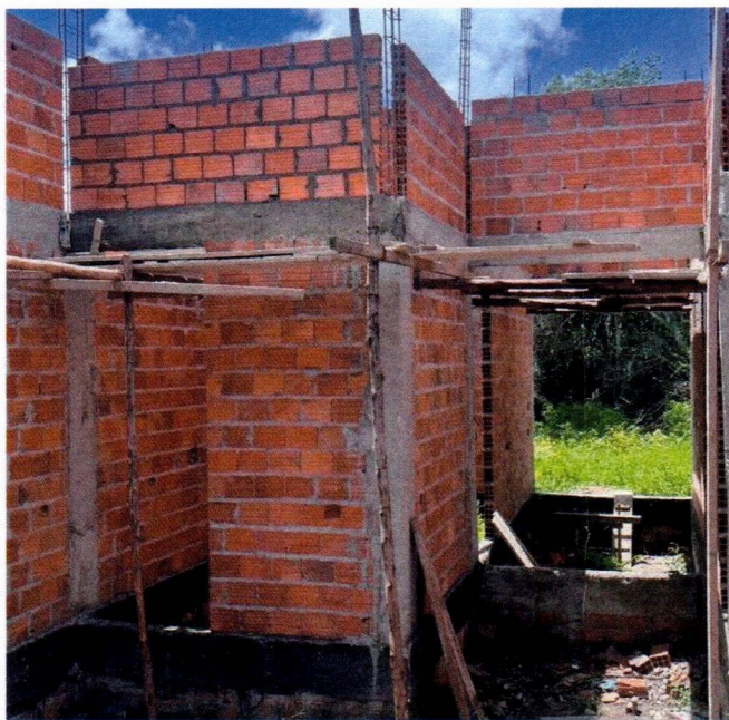
Imagem 02 – Serviços de estrutura e alvenaria
