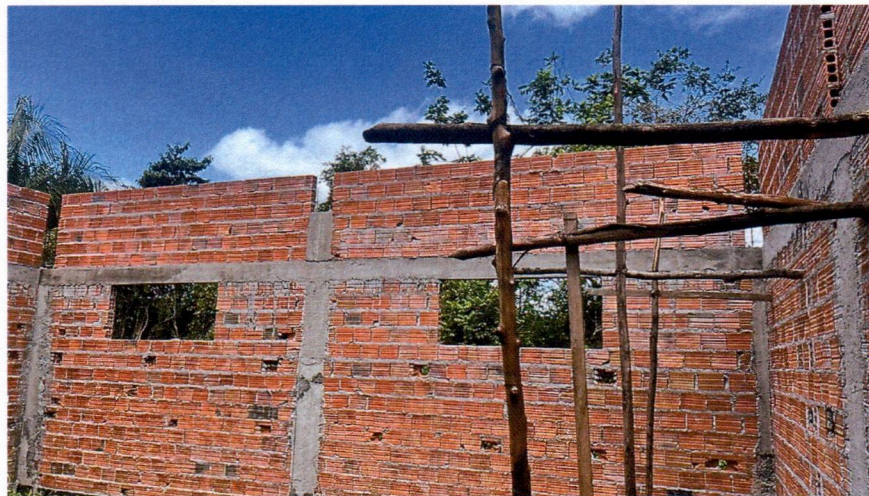
Imagem 8 – Execução da alvenaria, concretagem dos pilares e armação das vigas superiores.
