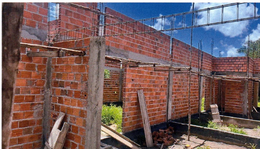
Imagem 2 – Execução da alvenaria, concretagem dos pilares e armação das vigas superiores.
