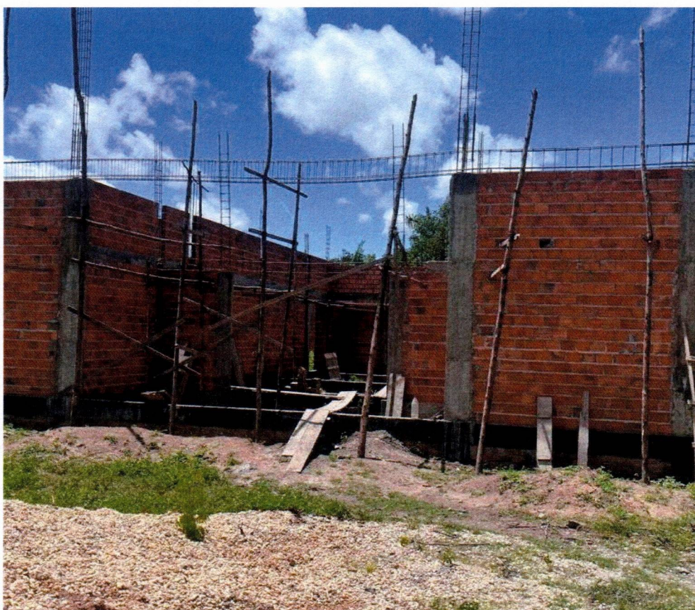
Imagem 01 – Serviços de estrutura e alvenaria
