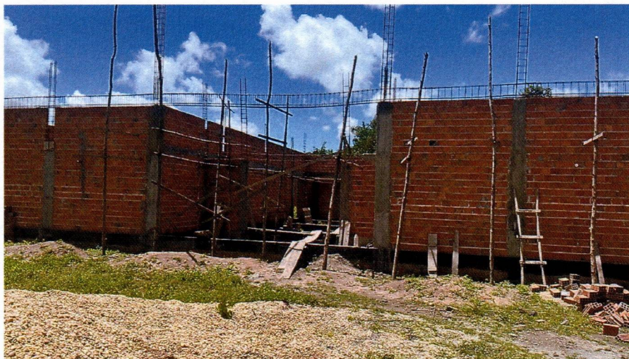
Imagem 1 – Execução da alvenaria, concretagem dos pilares e armação das vigas superiores.
