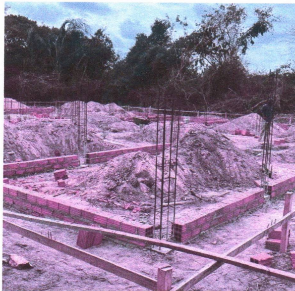
Imagem 15 – Serviços de movimentações de solo e fundações.
