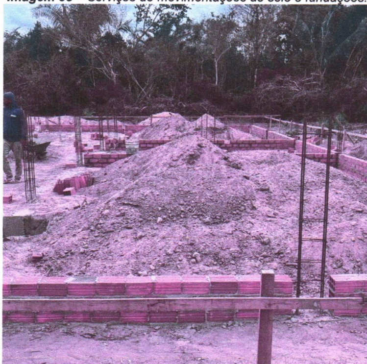
Imagem 09 – Serviços de movimentações de solo e fundações..
