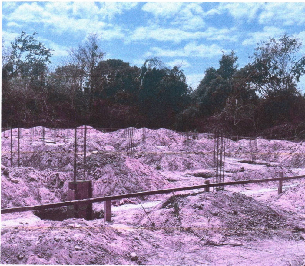
Imagem 01 – Serviços de movimentações de solo e fundações.
