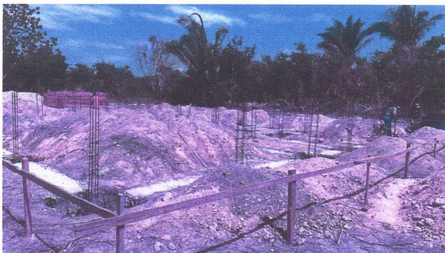
Imagem 2 – Execução do gabarito da obra, escavações das fundações, alicerce com pedra argamassada, e concretagem das sapatas.
