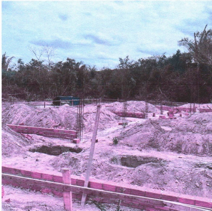
Imagem 10 – Serviços de movimentações de solo e fundações.
