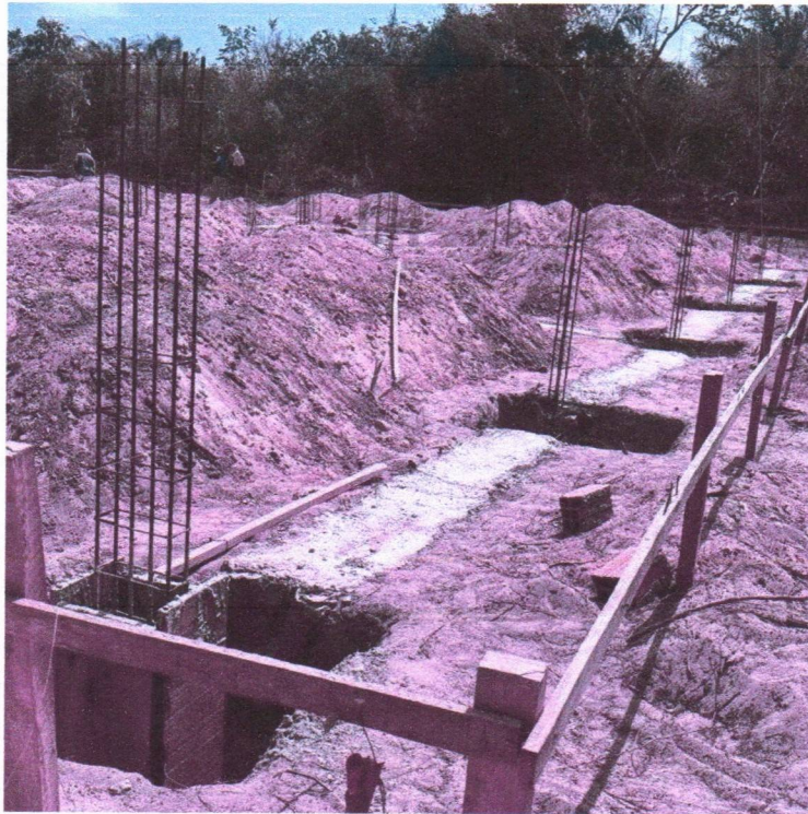
Imagem 14 – Serviços de movimentações de solo e fundações.
