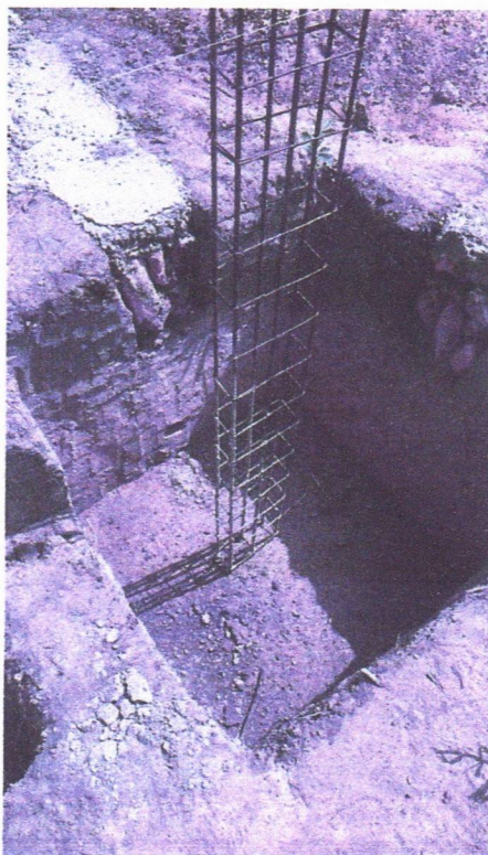
Imagem 4 – Execução da concretagem das sapatas.
