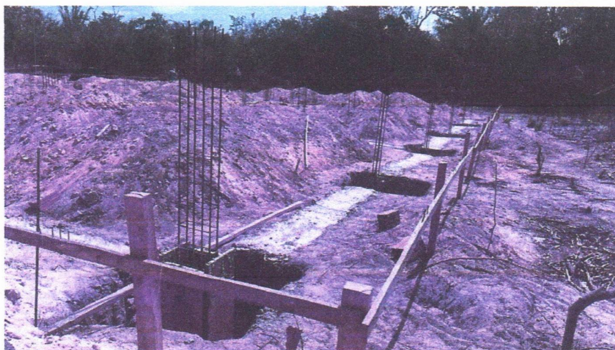
Imagem 1 – Execução do gabarito da obra, escavações das fundações, alicerce com pedra argamassada, e concretagem das sapatas.
