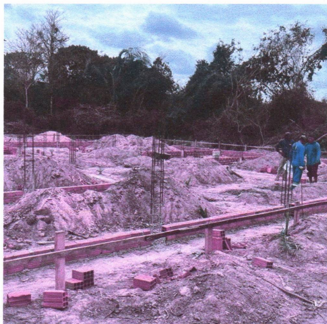
Imagem 11 – Serviços de movimentações de solo e fundações.
