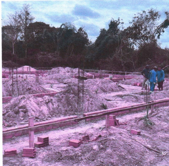
Imagem 16 – Serviços de movimentações de solo e fundações.
