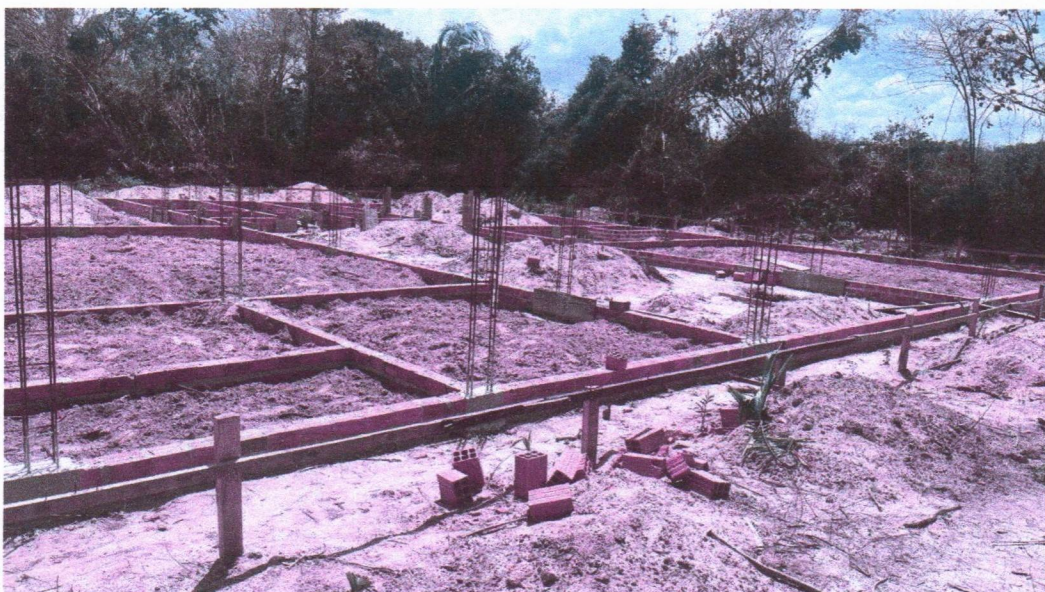
Imagem 13 – Serviços de movimentações de solo e fundações.
