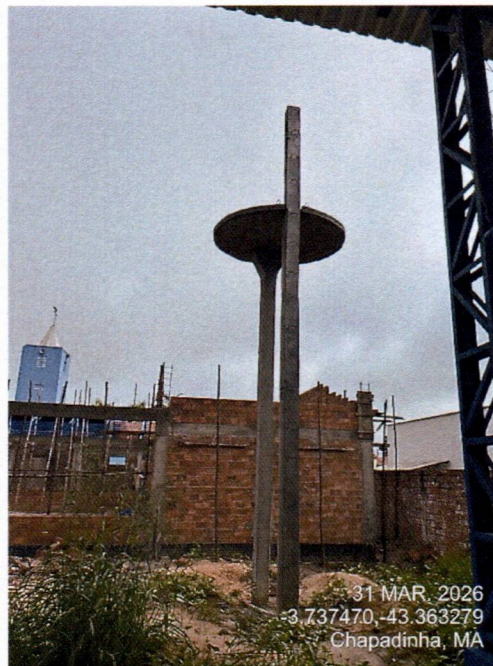
Imagem 14 – Instalação da base da caixa d'água elevada. Execução do chapisco, reboco interno e contrapiso em concreto.
