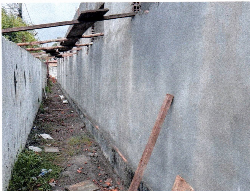
Imagem 02 – Serviços de chapisco e reboco
