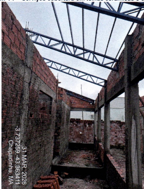
Imagem 15 – Serviços cobertura em telhas cerâmicas e estrutura metálica
