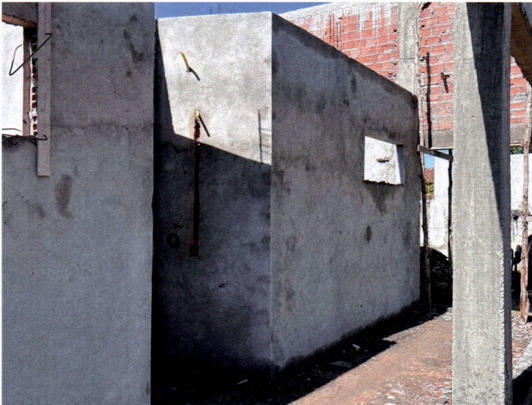
Imagem 01 – Serviços de chapisco e reboco
