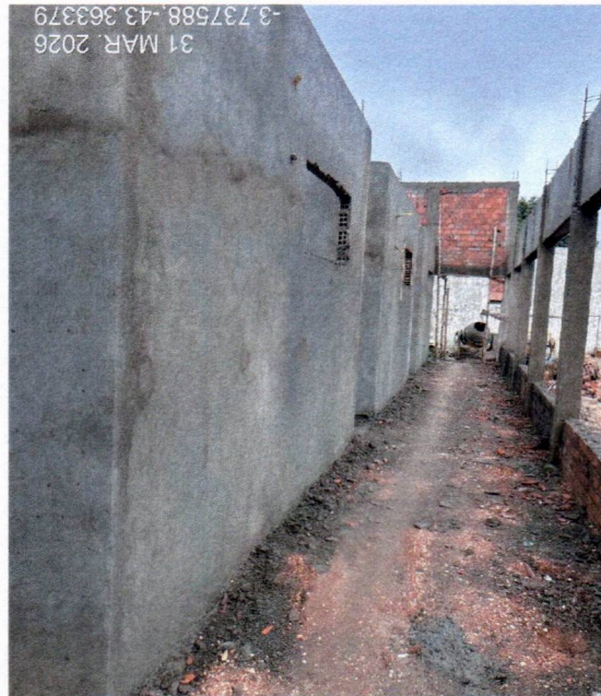
Imagem 06 – Serviços de chapisco e reboco
