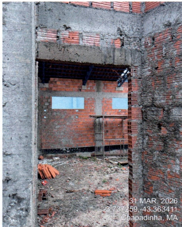
Imagem 07 – Serviços de alvenaria, estrutura e chapisco
