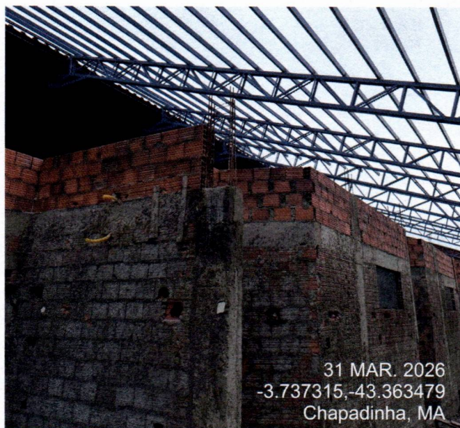
Imagem 14 – Serviços cobertura em telhas cerâmicas e estrutura metálica
