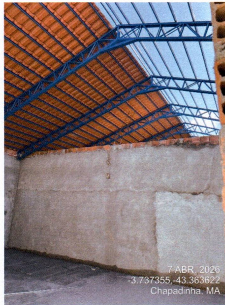
Imagem 13 – Execução da cobertura com trama metálica, treliça metálica e telhamento com telha dupla.
