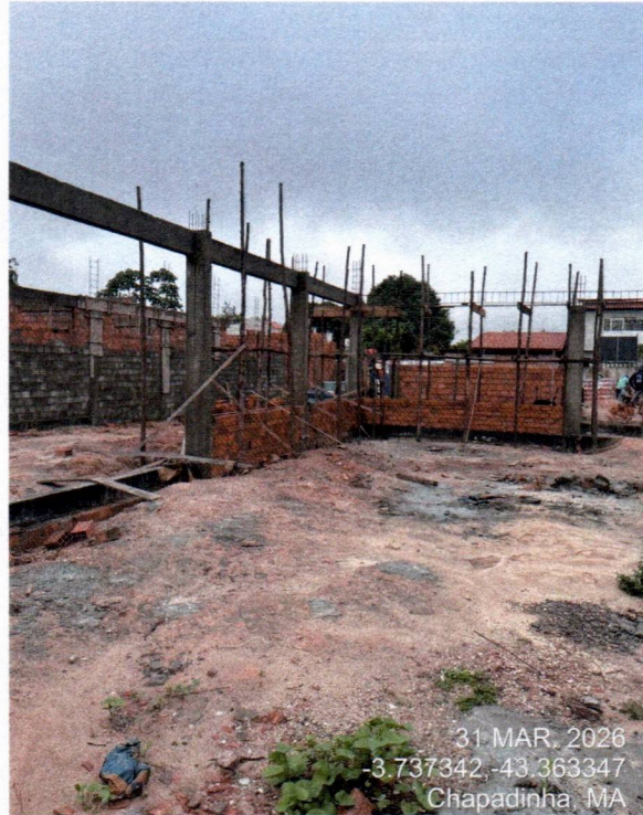
Imagem 10 – Serviços de alvenaria, estrutura e chapisco
