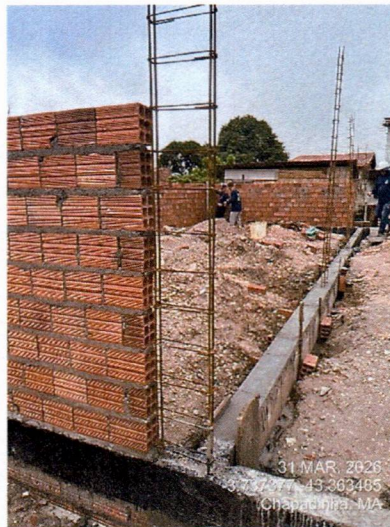
Imagem 1 – Execução das vigas baldrame, armação de pilares e execução de alvenaria.
