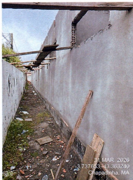
Imagem 7 – Execução do chapisco e reboco externo das salas.
