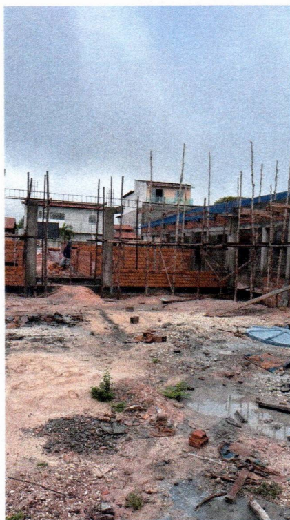
Imagem 03 – Serviços de estrutura e alvenaria
