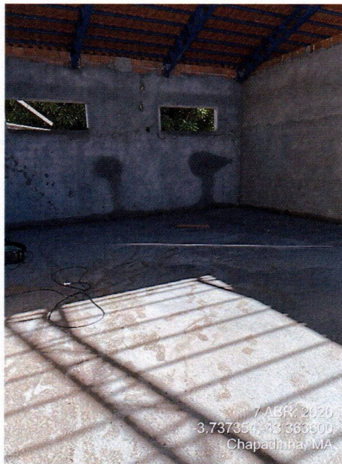
Imagem 12 – Execução do chapisco, reboco interno e contrapiso em concreto.
