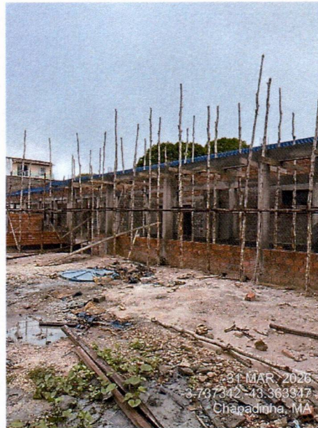
Imagem 5 – Execução da alvenaria do bloco da cozinha e concretagem dos pilares e vigas.
