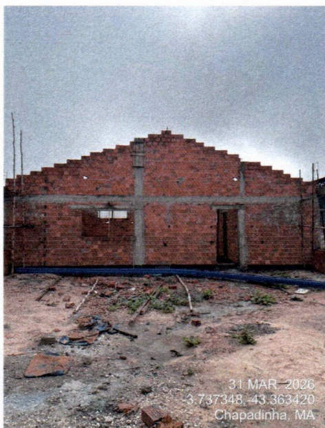
Imagem 08 – Serviços de alvenaria, estrutura e chapisco
