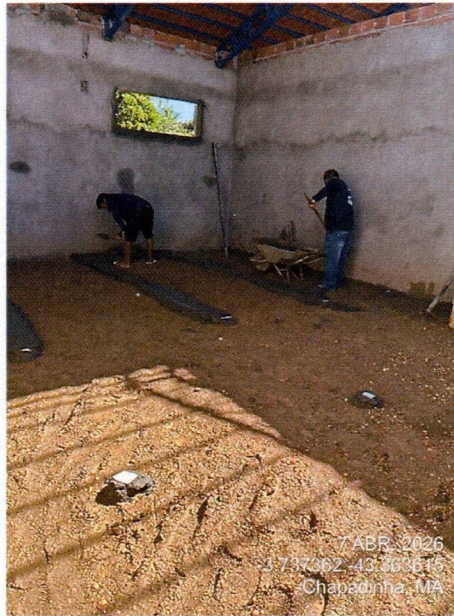
Imagem 11 – Execução do chapisco, reboco interno e contrapiso em concreto.
