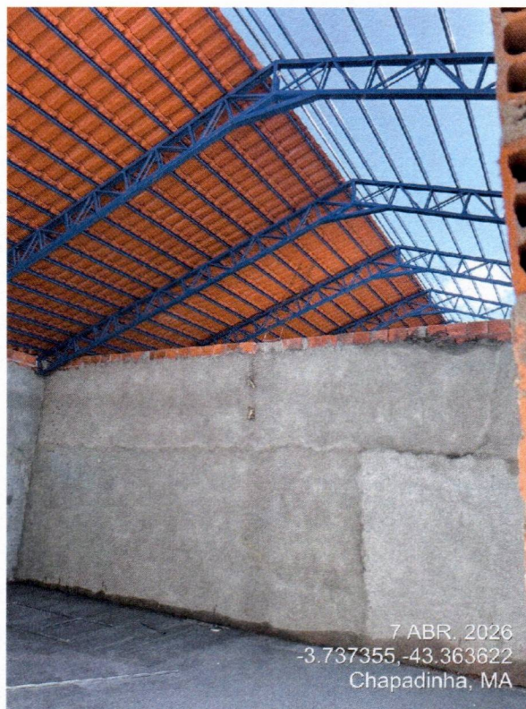
Imagem 13 – Serviços cobertura em telhas cerâmicas e estrutura metálica
