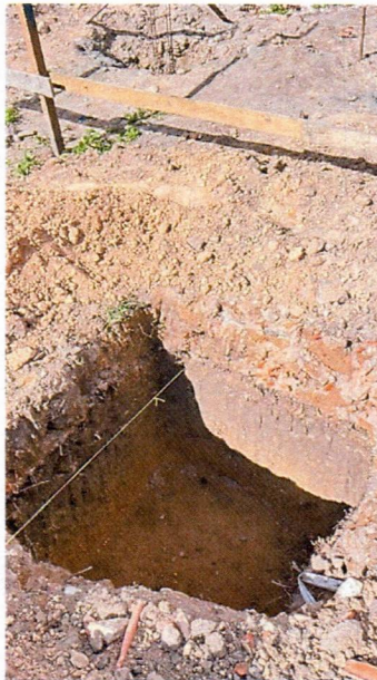
Imagem 1 – Execução das escavações das sapatas.
