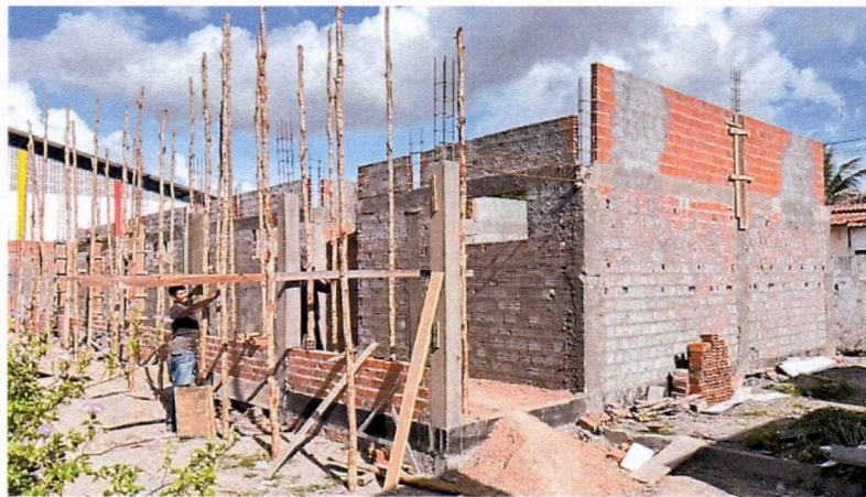
Imagem 16 – Execução da alvenaria, pilares, vigas superiores do corredor.
