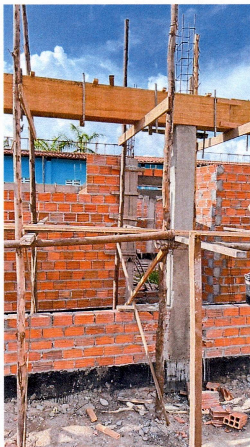
Imagem 14 – Execução da alvenaria, pilares, vigas superiores do corredor.
