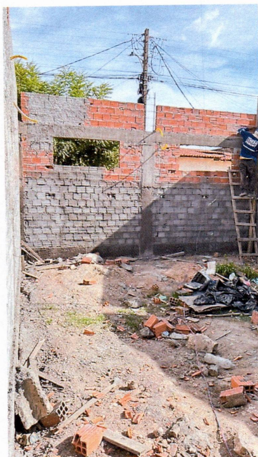
Imagem 8 – Execução da alvenaria, pilares, vigas superiores e chapisco.
