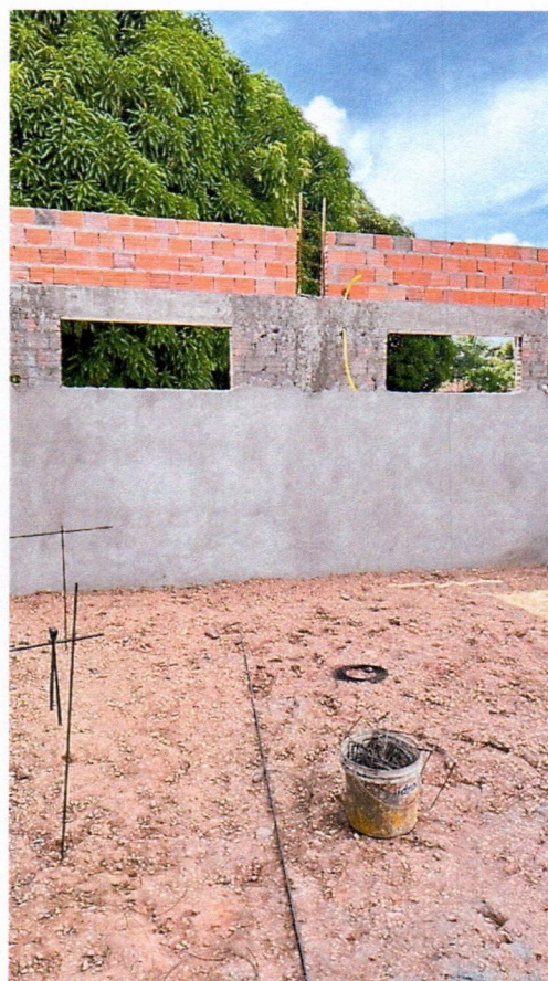
Imagem 10 – Execução da alvenaria, pilares, vigas superiores, chapisco e reboco.
