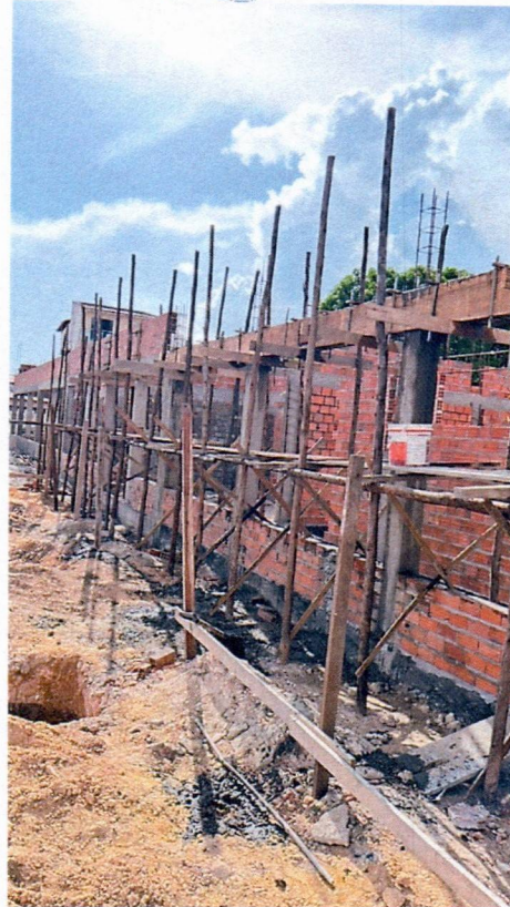
Imagem 15 – Execução da alvenaria, pilares, vigas superiores do corredor.
