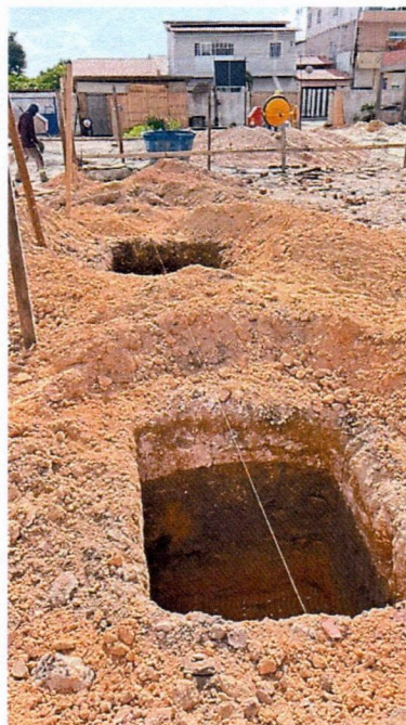
Imagem 2 – Execução das escavações das sapatas e execução do gabarito da obra.
