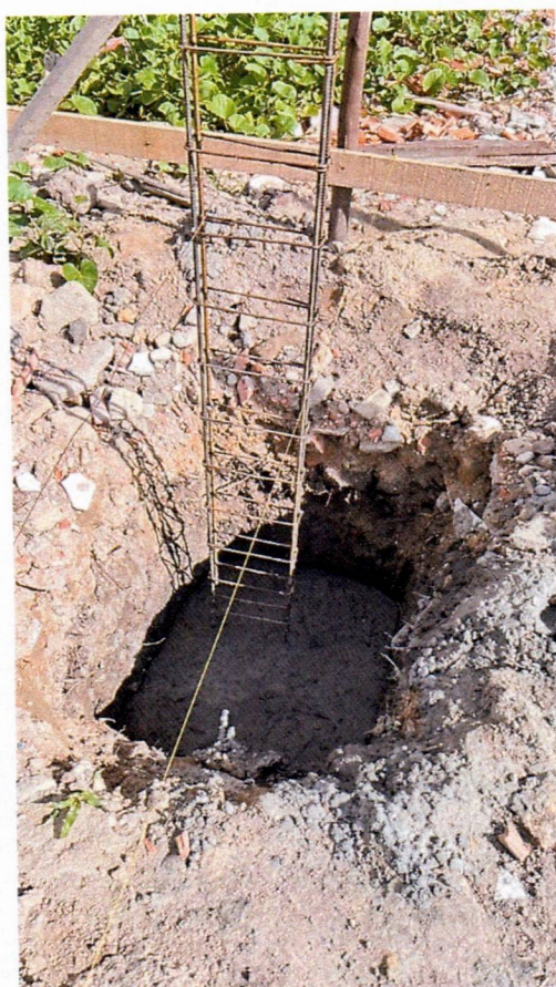
Imagem 4 – Execução da concretagem das sapatas e armação dos pilares.
