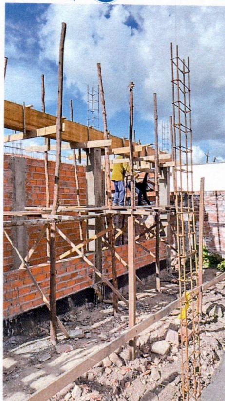
Imagem 17 – Execução da alvenaria, pilares, vigas superiores do corredor.
