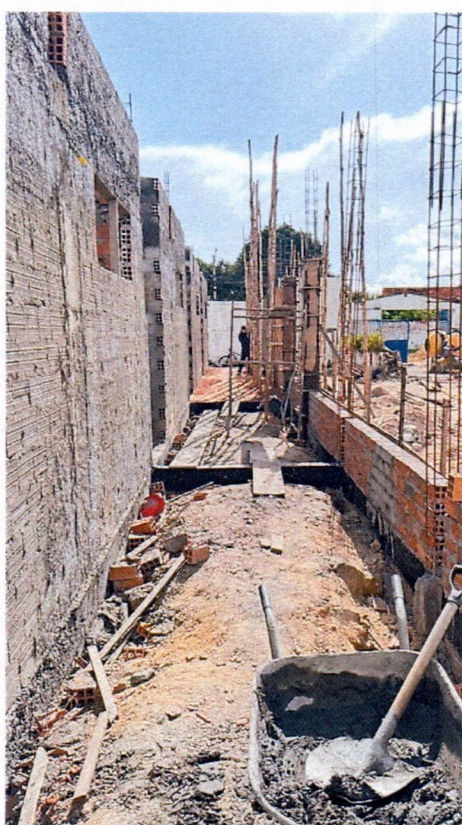
Imagem 18 – Execução da alvenaria, pilares, vigas superiores do corredor.
