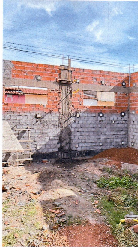
Imagem 9 – Execução da alvenaria, pilares, vigas superiores e chapisco.
