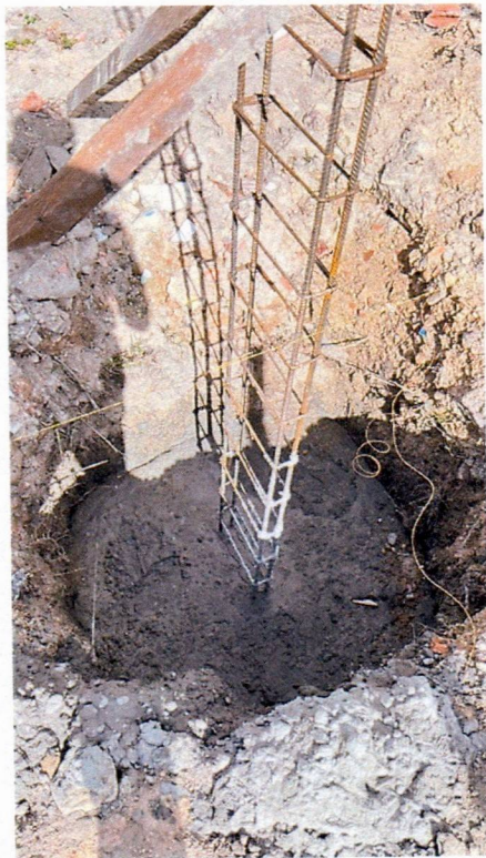
Imagem 3 – Execução da concretagem das sapatas e armação dos pilares.
