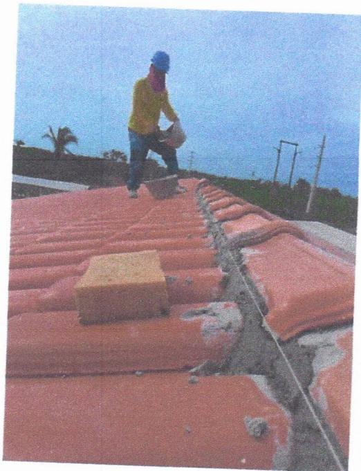
Cumeeira com telha cerâmica emboçada com argamassa
