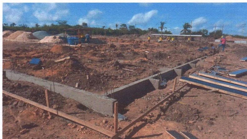
IMAGEM 9,10,11,12 e 13: Forma em madeira compensada plastificada e concretagem das vigas baldrame
