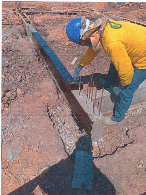
IMAGEM 14 e 15: Impermeabilização das vigas baldrame
