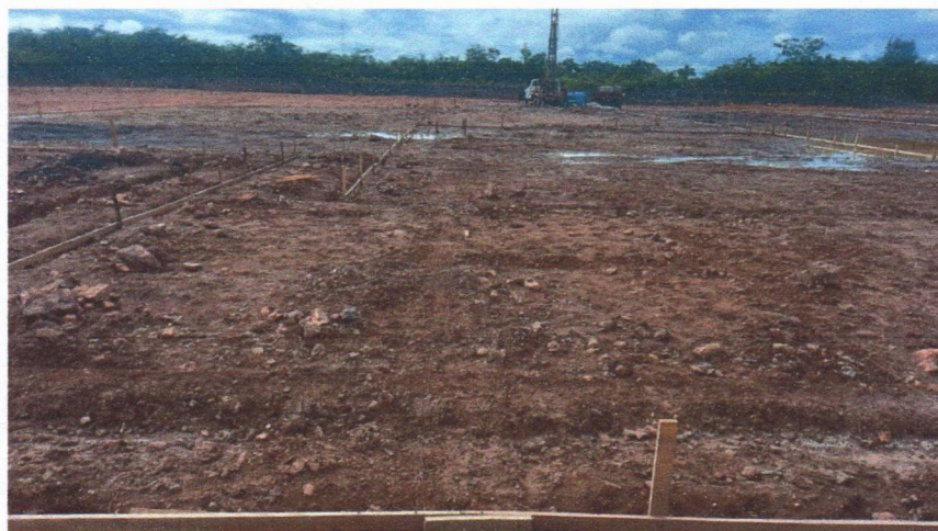
IMAGEM 2: locação da obra (gabaritos)
