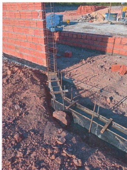
IMAGEM 18, 19, 20, 21 e 22: Assentamento de alvenaria, colocação das contra vergas e painel de forma para pilares.
