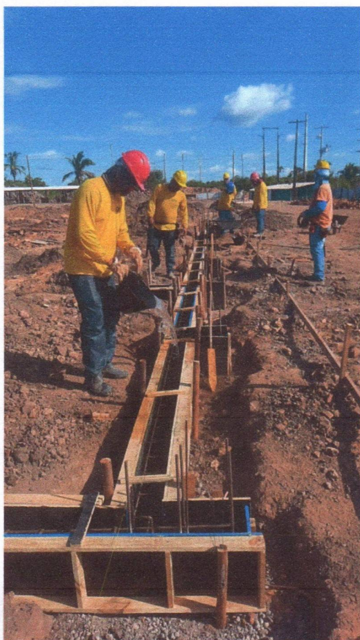
IMAGEM 9,10,11,12 e 13: Forma em madeira compensada plastificada e concretagem das vigas baldrame
