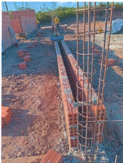
IMAGEM 18, 19, 20, 21 e 22: Assentamento de alvenaria, colocação das contra vergas e painel de forma para pilares.
