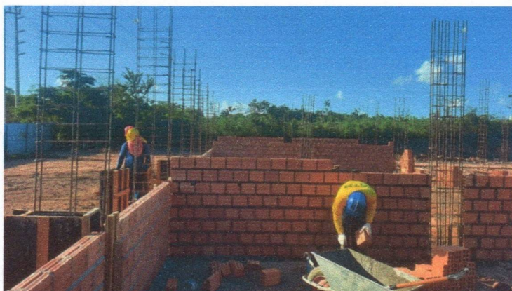
IMAGEM 16 e 17: Assentamento de alvenaria
