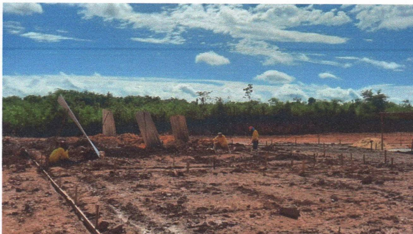
IMAGEM 3: Escavações das sapatas fundações
