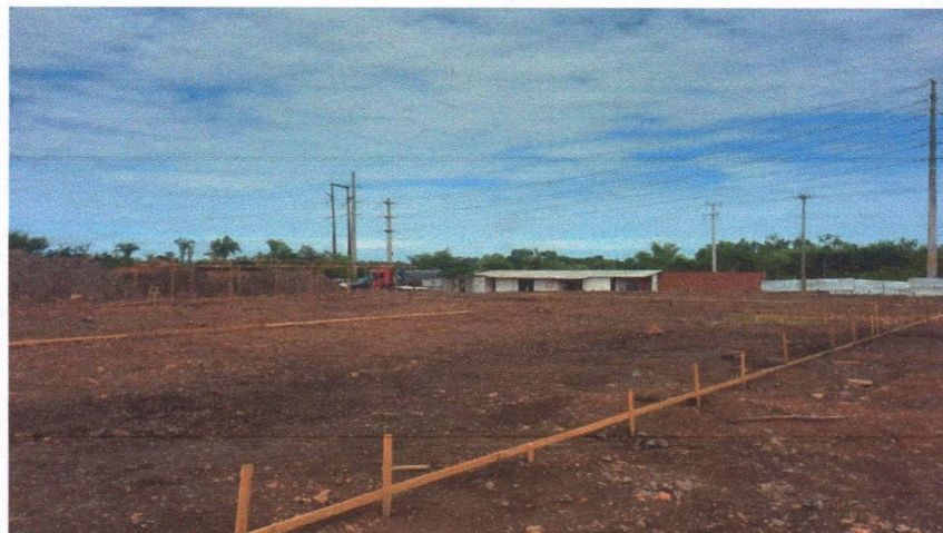
IMAGEM 1: locação da obra (gabaritos)
