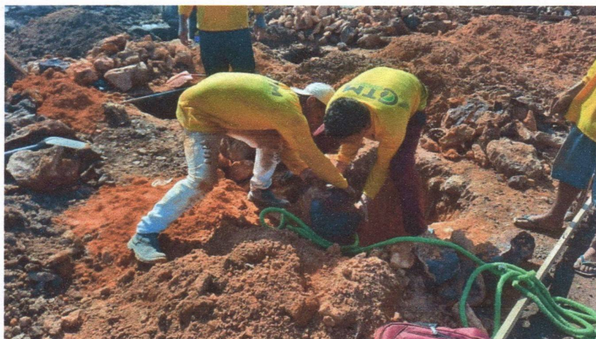
IMAGEM 4: Remoção de pedras
