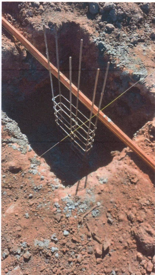
IMAGEM 5 e 6: Lastro de concreto, com armações de aço CA-50 em forma de madeira compensada plastificada.
