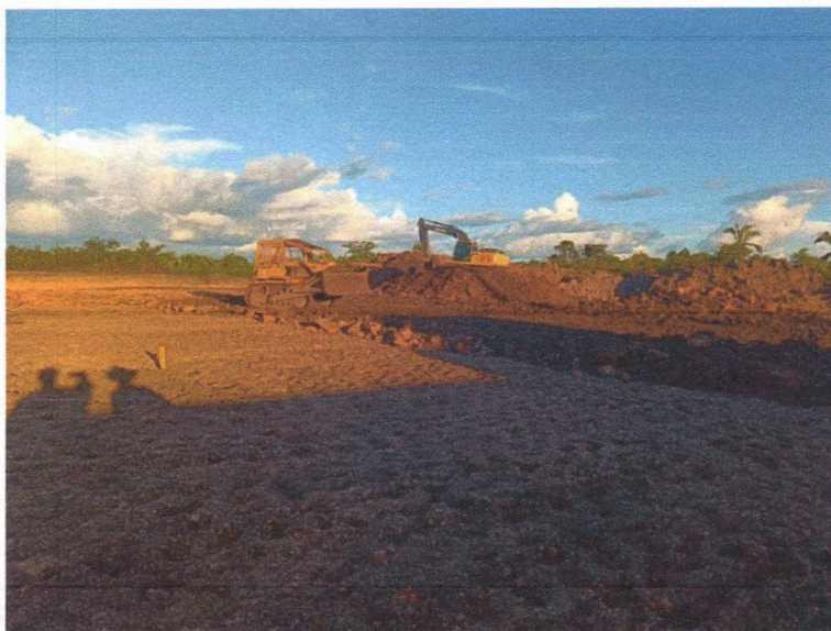
IMAGEM 11: limpeza mecanizada do terreno
