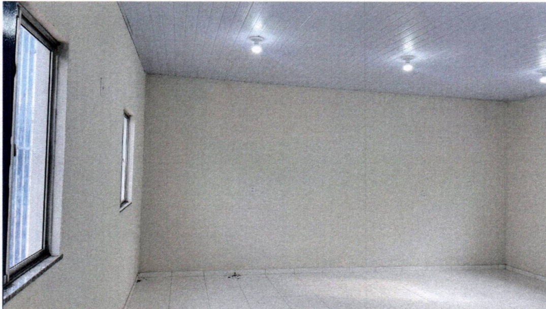
IMAGEM 06 – APLICAÇÃO DO PISO CERÂMICO; INSTALAÇÃO DO FORRO E ILUMINAÇÃO
