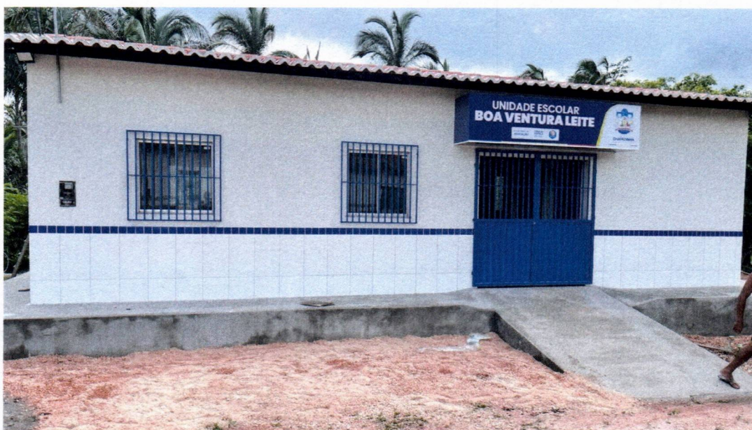
IMAGEM 02 – APLICAÇÃO DE REVESTIMENTO EXTERNO; PINTURA EXTERNA GERAL; INSTALAÇÃO DA PLACA EM ACM; INSTALAÇÃO DAS ESQUADRIAS E GRADIL.
