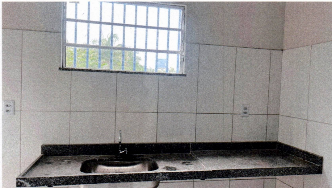
IMAGEM 08 – INSTALAÇÃO DA BANCADA EM GRANITO, APLICAÇÃO DO REVESTIMENTO.
