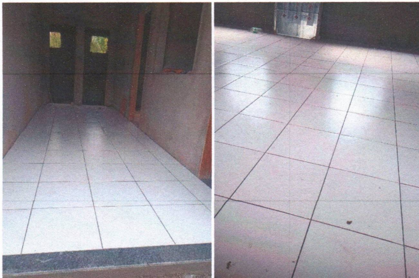
IMAGEM 06 – APLICAÇÃO DO PISO CERÂMICO; APLICAÇÃO DE CHAPISCO, REBOCO
