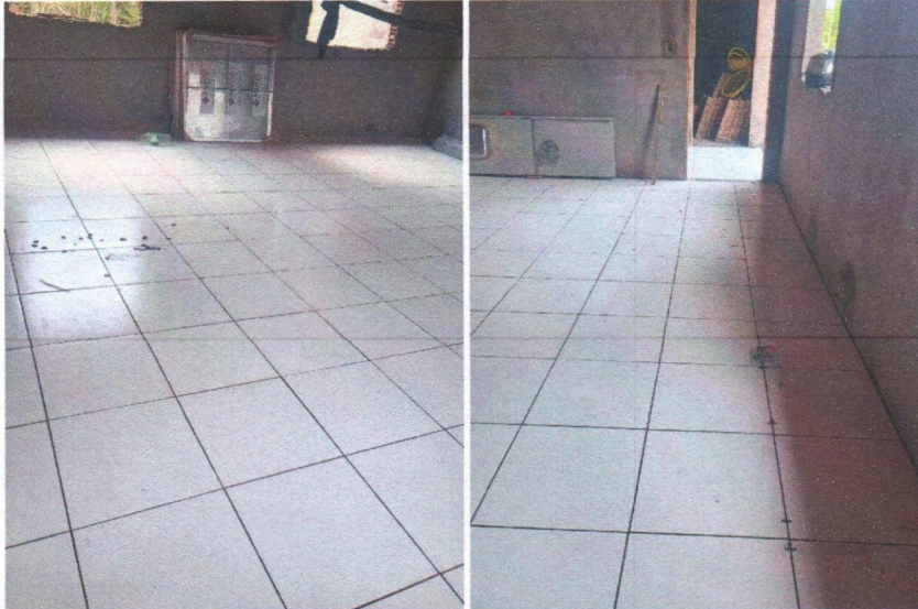
IMAGEM 05 – APLICAÇÃO DO PISO CERÂMICO; APLICAÇÃO DE CHAPISCO, REBOCO
