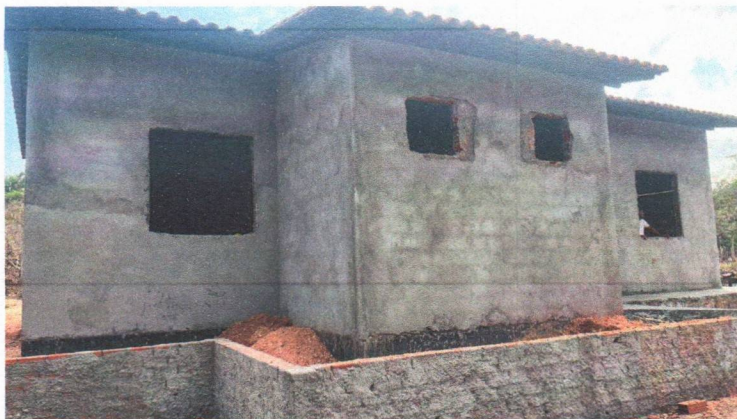
IMAGEM 03 – INSTALAÇÃO DA TRAMA DE MADEIRA; INSTALAÇÃO DAS TELHA CERÂMICA; CHAPISCO, REBOCO EXTERNO; CALÇADA.
