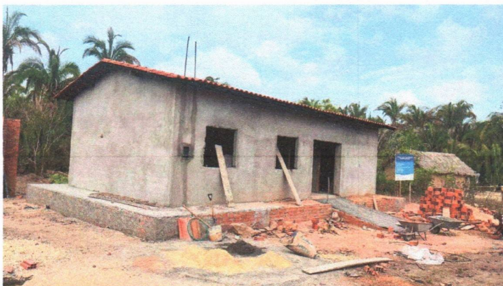
IMAGEM 04 – INSTALAÇÃO DA TRAMA DE MADEIRA; INSTALAÇÃO DAS TELHA CERÂMICA; CHAPISCO, REBOCO EXTERNO; CALÇADA.
