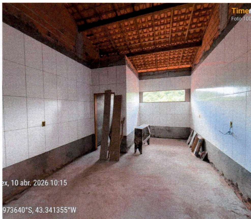
Imagem 01 – Serviços de Revestimentos cerâmicos
