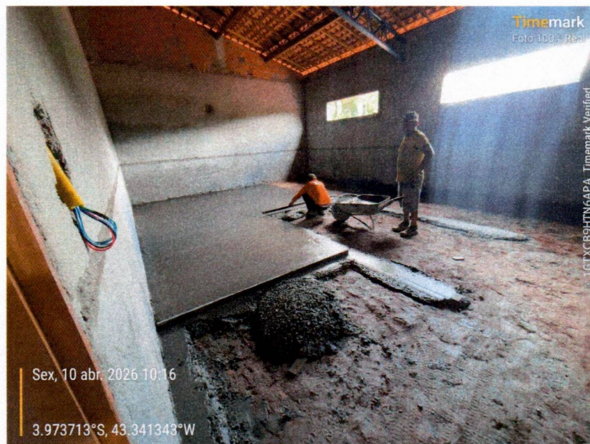
Imagem 02 – Serviços de contrapiso
