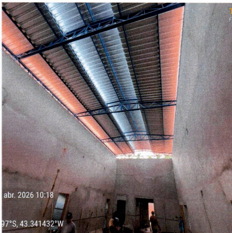
Imagem 08 – Serviços de chapisco e reboco
