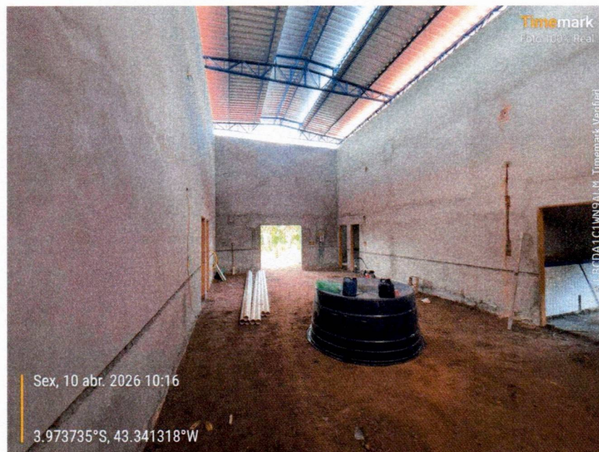
Imagem 03 – Serviços de cobertura metálica e reboco
