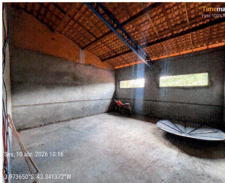
Imagem 05 – Serviços de contrapiso e rebooco
