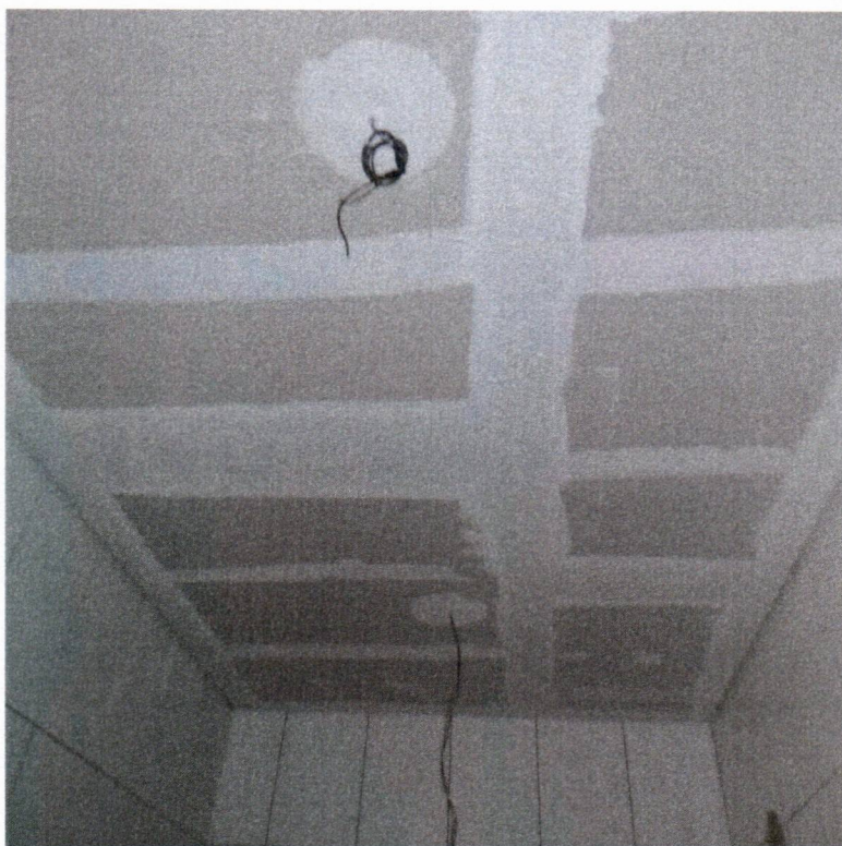
Imagem 12 – Serviços de forro em gesso e revestimentos cerâmicos
