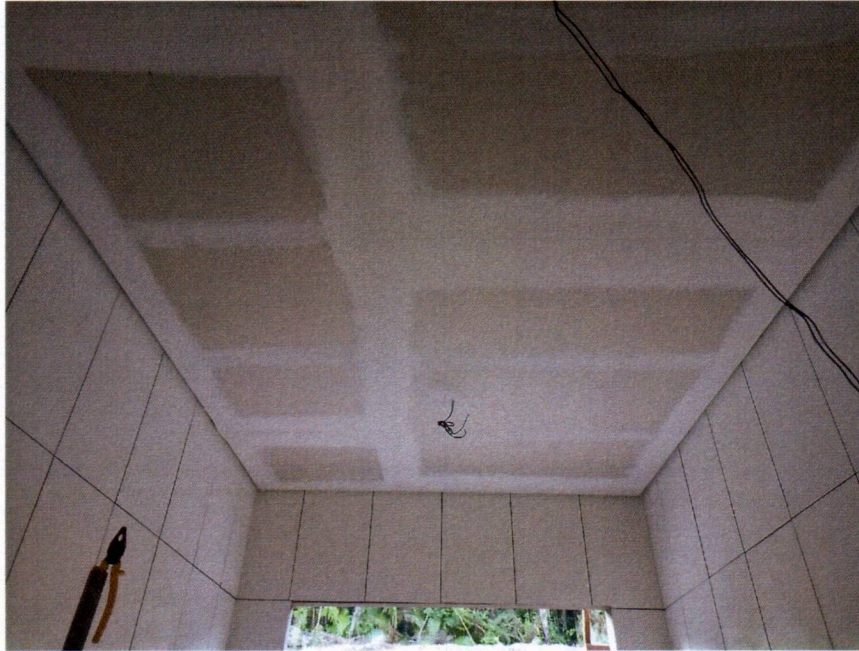
Imagem 9 – Execução do forro acartonado.
