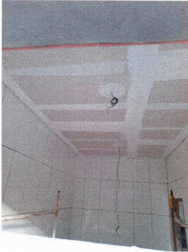
Imagem 14 – Serviços de forro em gesso e revestimentos cerâmicos
