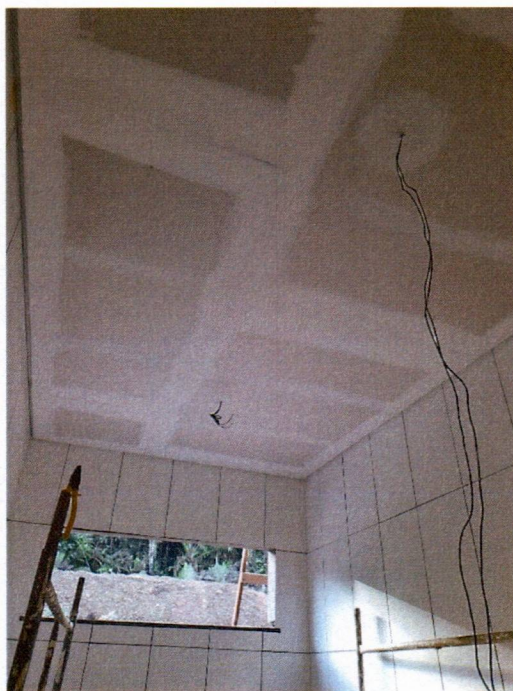
Imagem 8 – Execução do forro acartonado.
