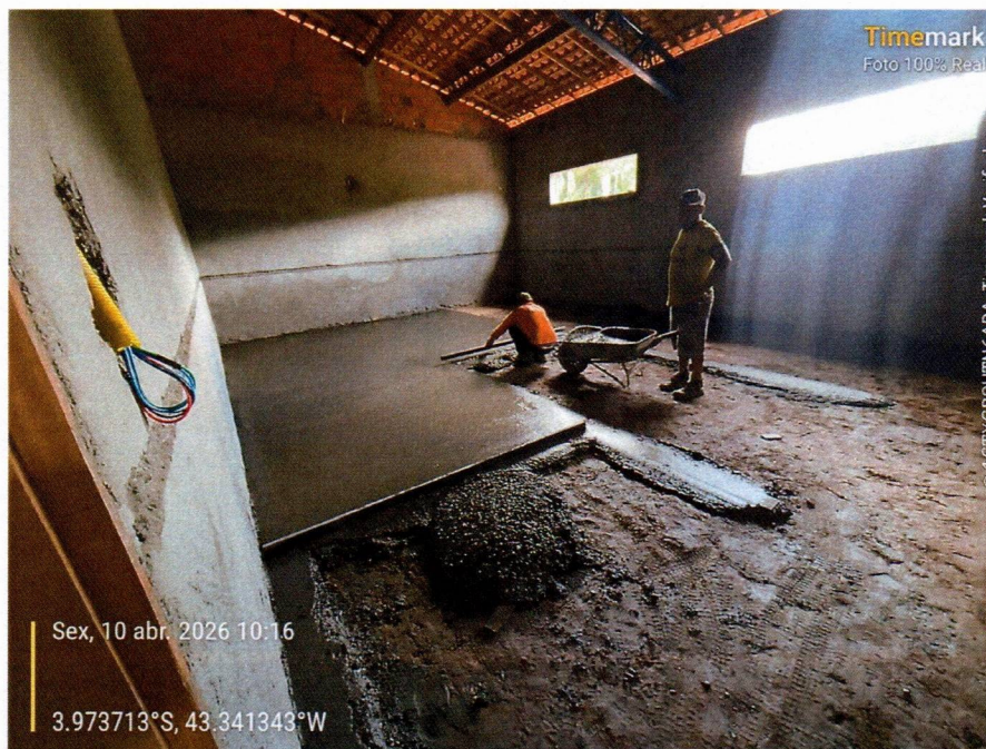
Imagem 2 – Execução do contrapiso interno.
