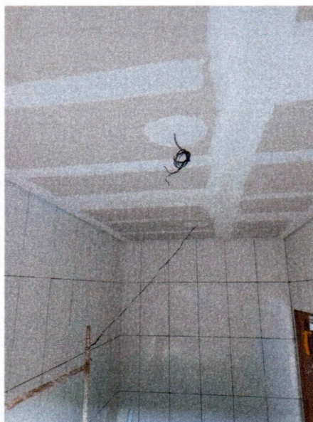
Imagem 13 – Serviços de forro em gesso e revestimentos cerâmicos
