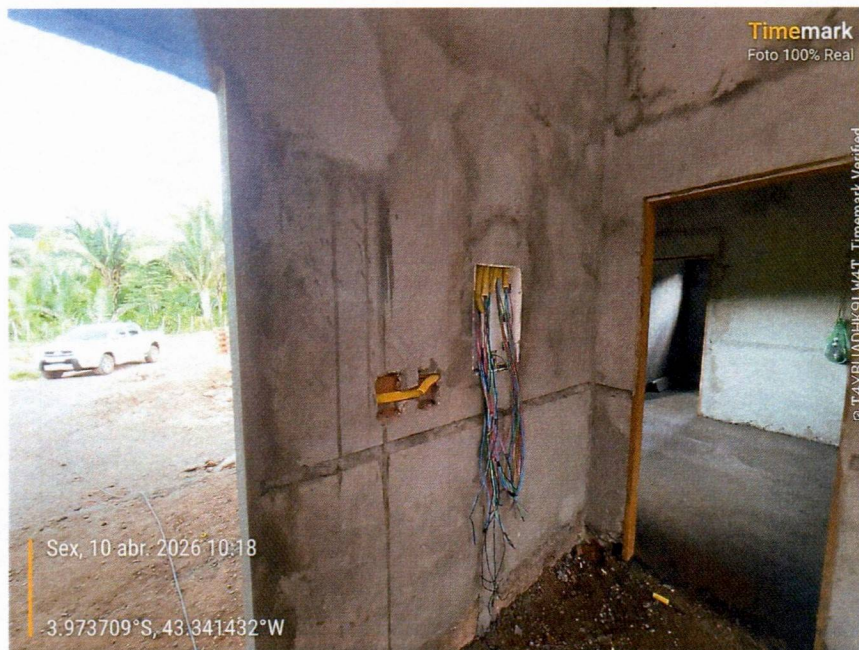
Imagem 4 – Instalação dos cabos de energia da escola.
