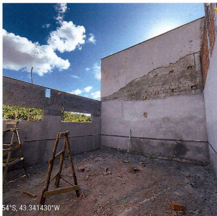
Imagem 06 – Serviços de chapisco e reboco
