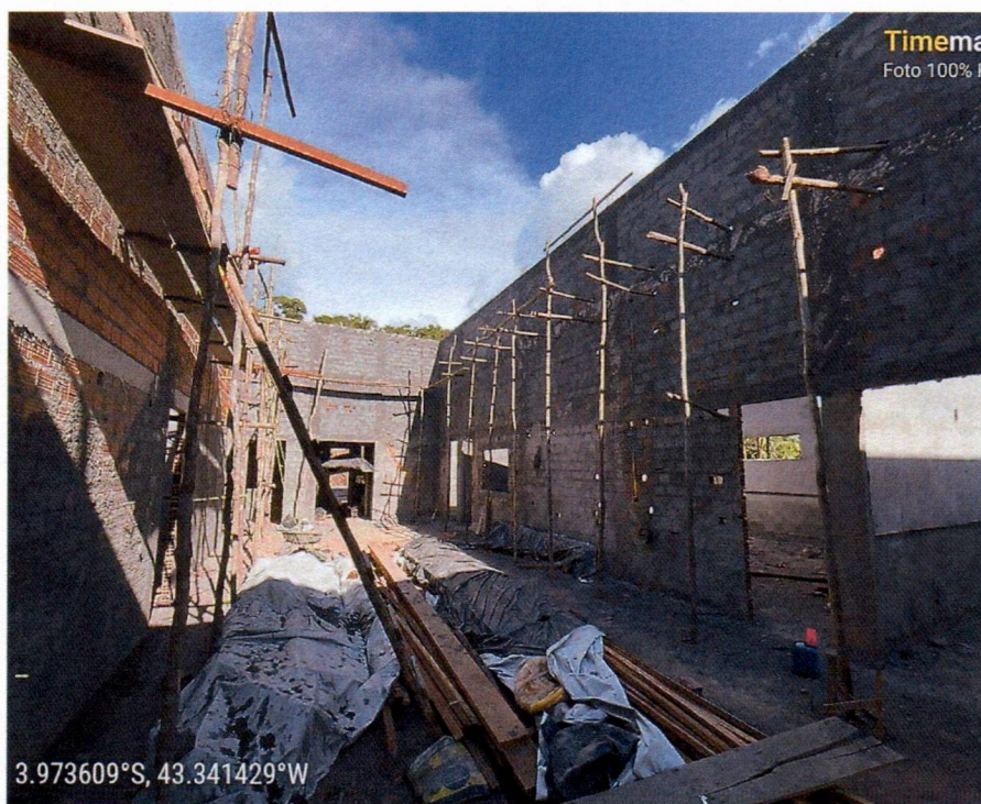
Imagem 05 – Serviços de chapisco e reboco
