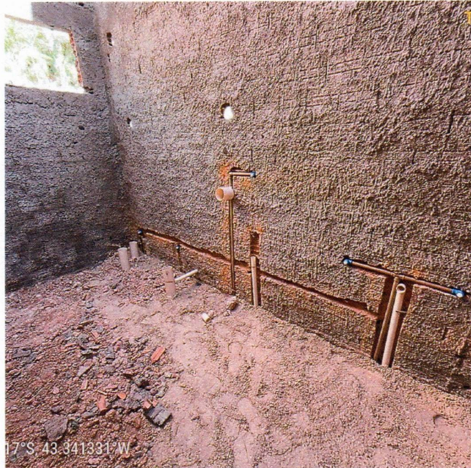
Imagem 10 – Serviços de instalações hidrossanitárias
