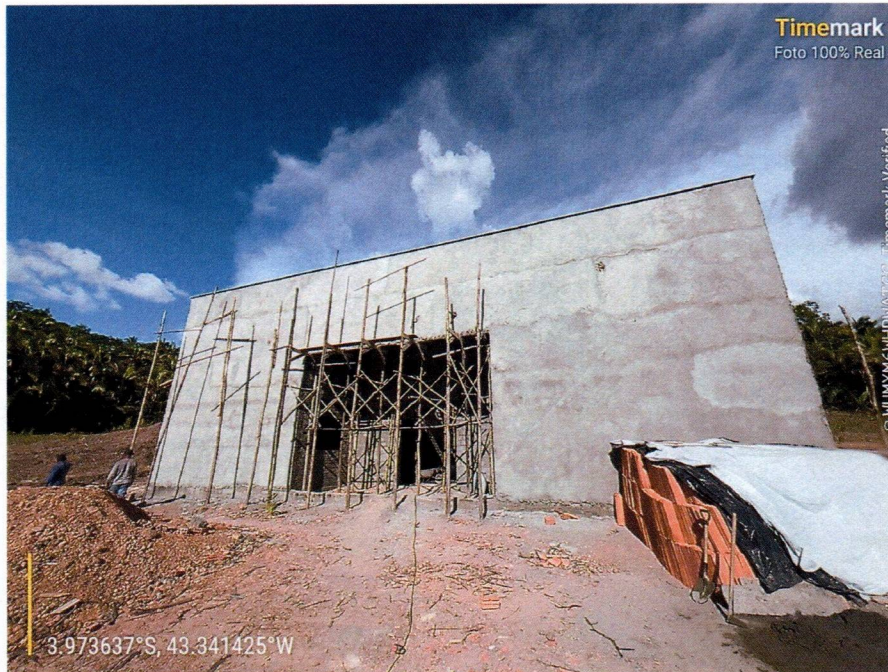
Imagem 1 – Execução da alvenaria, chapisco e reboco externo da escola.
