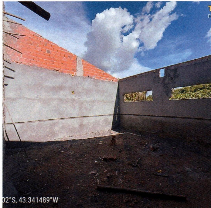
Imagem 08 – Serviços de chapisco e reboco
