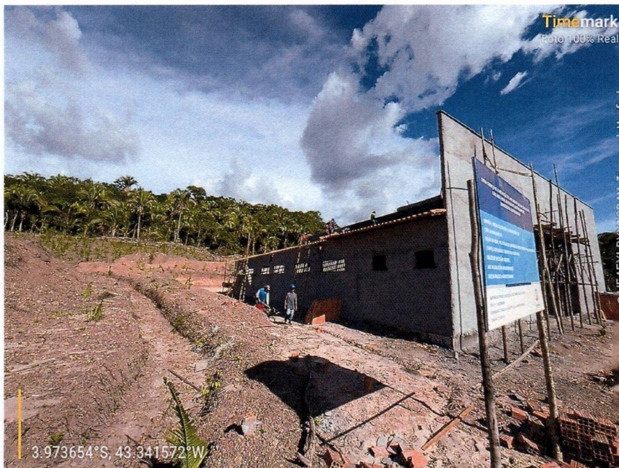
Imagem 2 – Execução da alvenaria, chapisco e reboco externo da escola.
