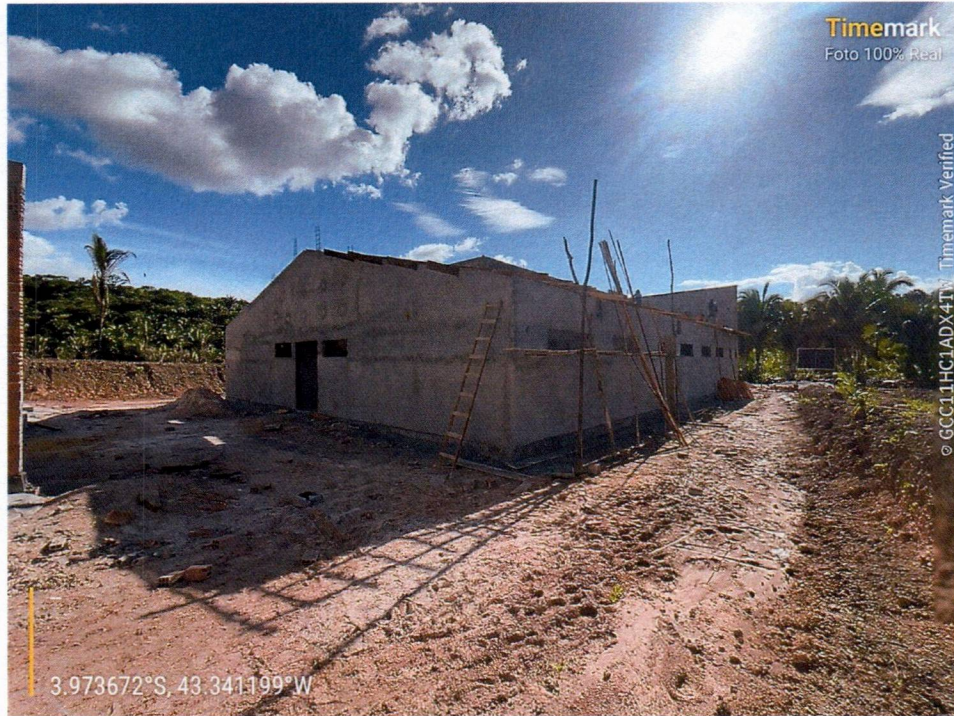
Imagem 5 – Execução da alvenaria, chapisco e reboco externo da escola.
