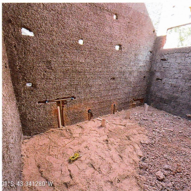
Imagem 11 – Serviços de instalações hidrossanitárias
