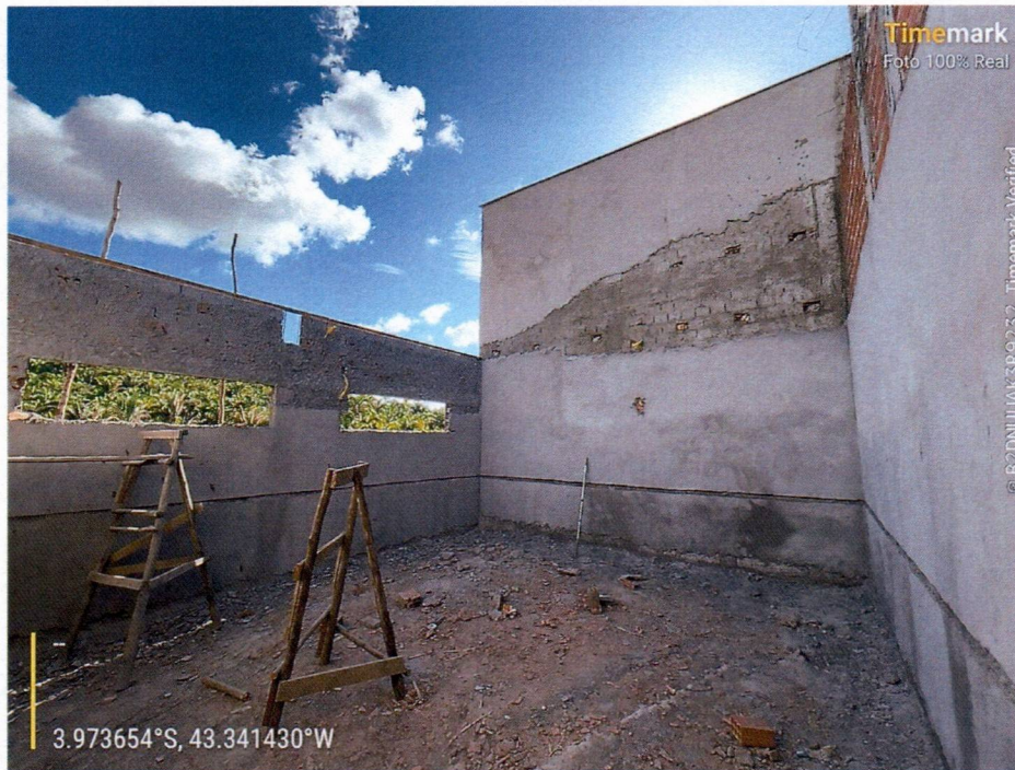
Imagem 7 – Execução da alvenaria, chapisco e reboco interno da escola.
