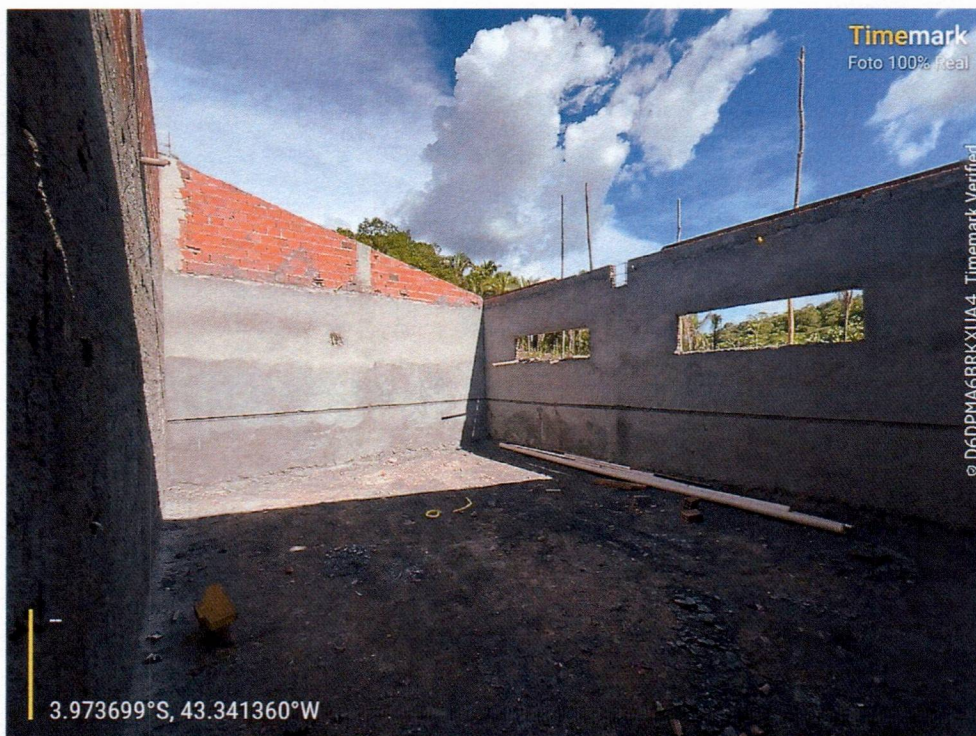
Imagem 6 – Execução da alvenaria, chapisco e reboco interno da escola.
