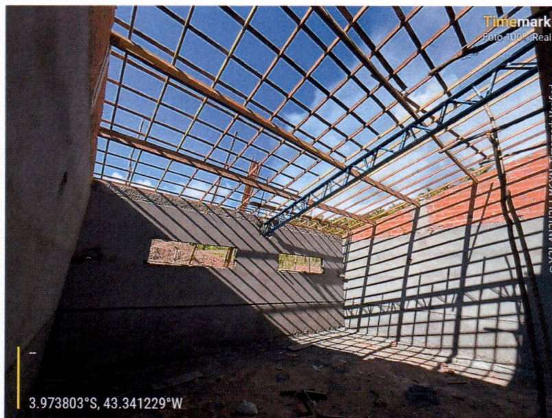
Imagem 12 – Instalação da viga treliçada metálica e execução de trama de madeira.
