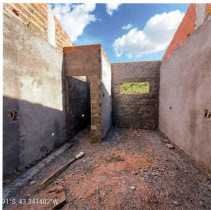
Imagem 09 – Serviços de chapisco e reboco
