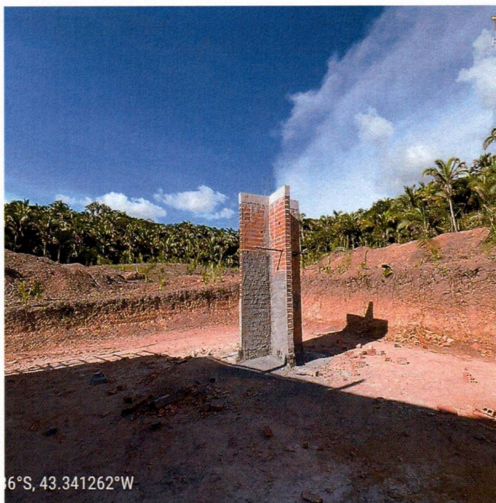
Imagem 14 – Serviços de estrutura de caixa de água
