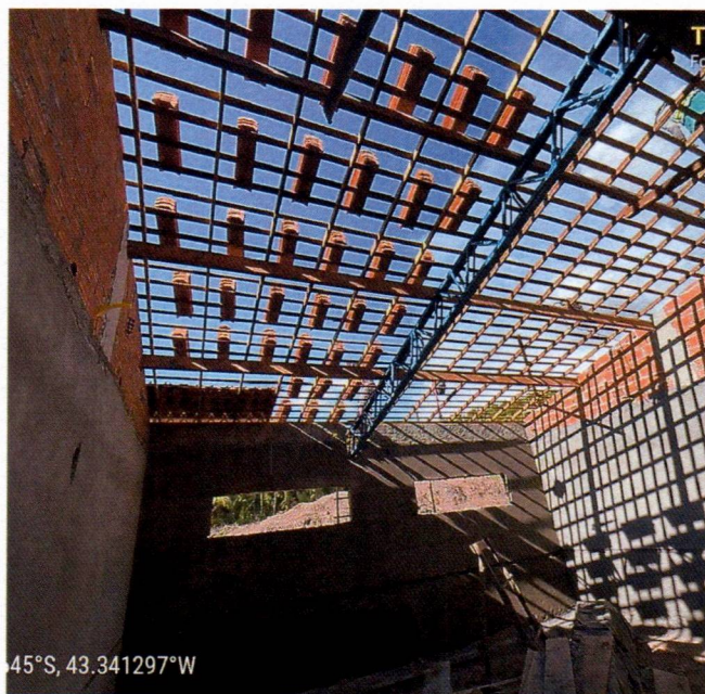
Imagem 02 – Serviços de cobertura
