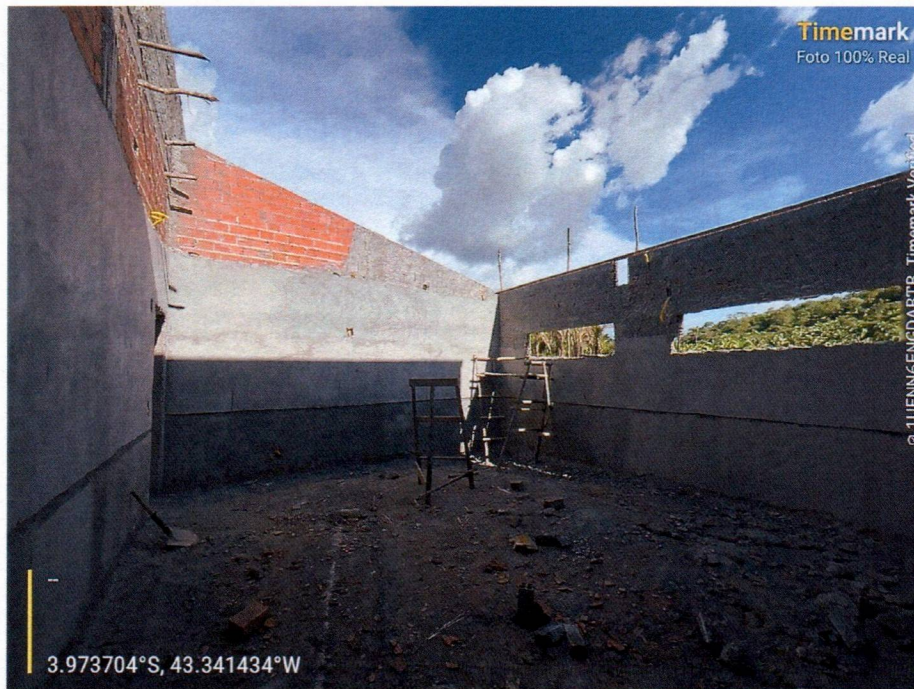
Imagem 8 – Execução da alvenaria, chapisco e reboco interno da escola.
