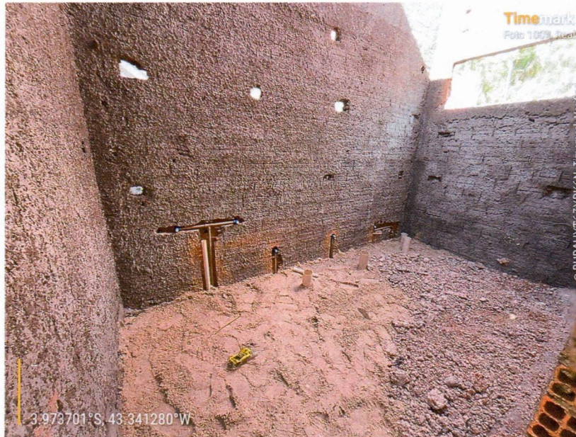
Imagem 11 – Execução das instalações hidrosanitárias dos banheiros.
