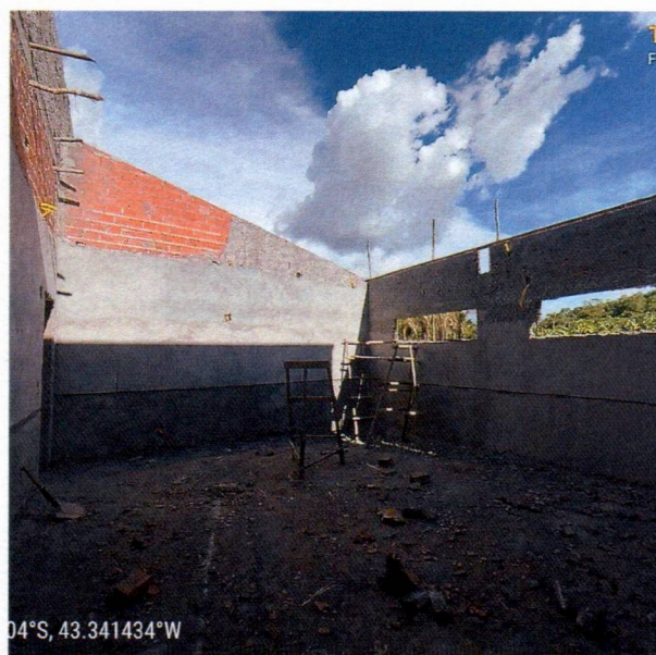
Imagem 07 – Serviços de Chapisco e Reboco
