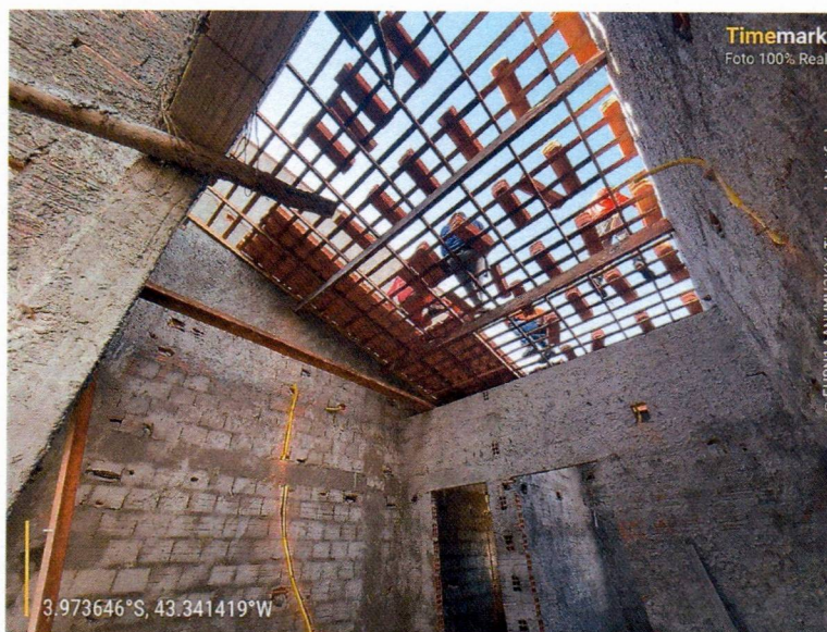
Imagem 03 – Serviços de cobertura
