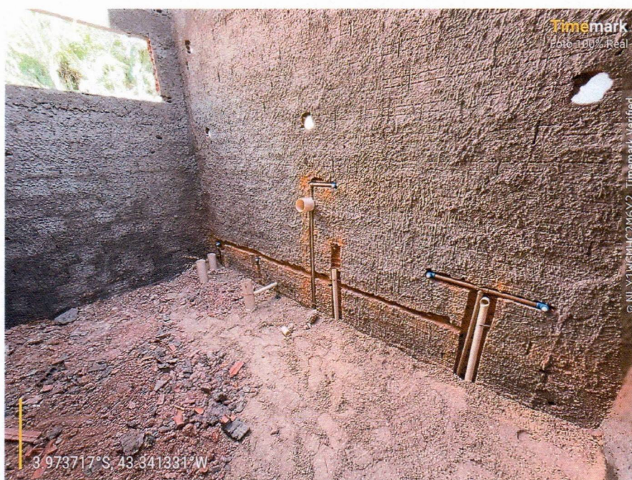
Imagem 10 – Execução das instalações hidrosanitárias dos banheiros.
