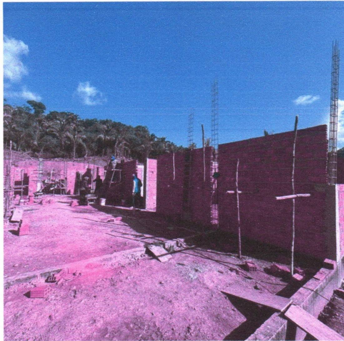
Imagem 10 – Serviços de alvenaria e estrutura de concreto
