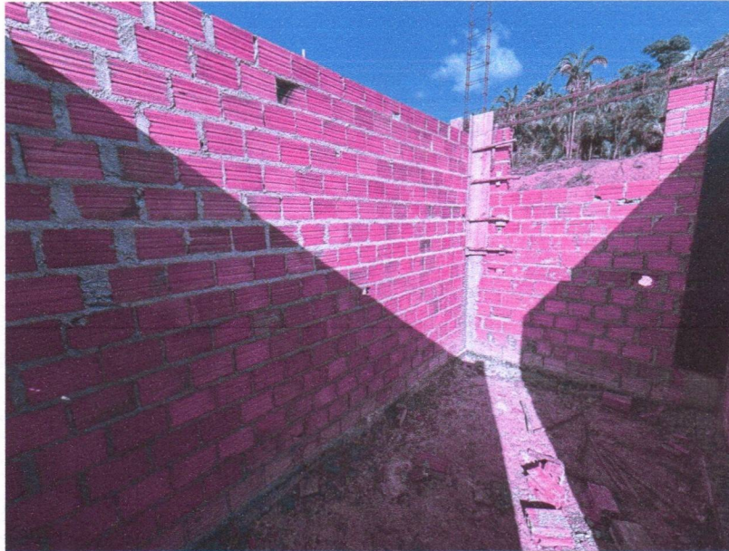
Imagem 04 – Serviços de alvenaria e estrutura de concreto
