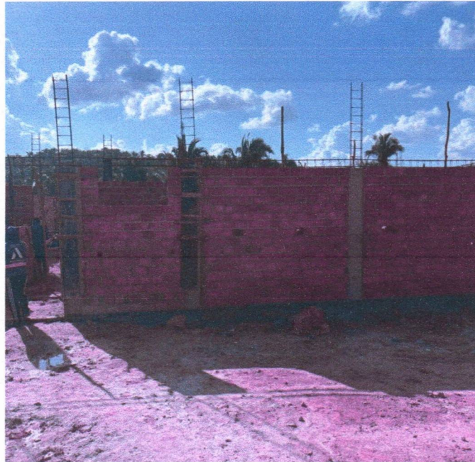
Imagem 02 – Serviços de alvenaria e estrutura de concreto
