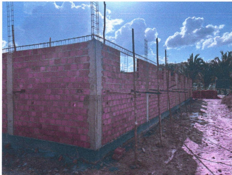
Imagem 03 – Serviços de alvenaria e estrutura de concreto
