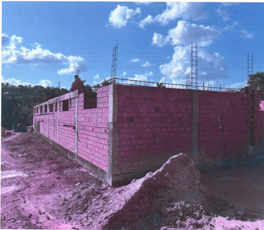
Imagem 01 – Serviços de alvenaria e estrutura de concreto
