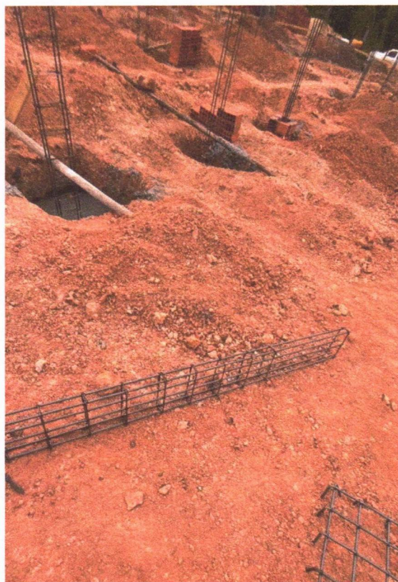
Imagem 6 – Execução da concretagem das sapatas e dos arranques dos pilares.
