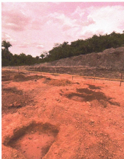
Imagem 4 – Execução das escavações.
