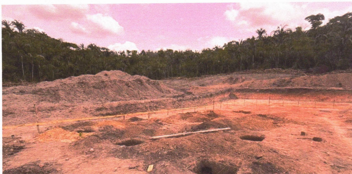
Imagem 3 – Execução do gabarito e escavações para as fundações.
