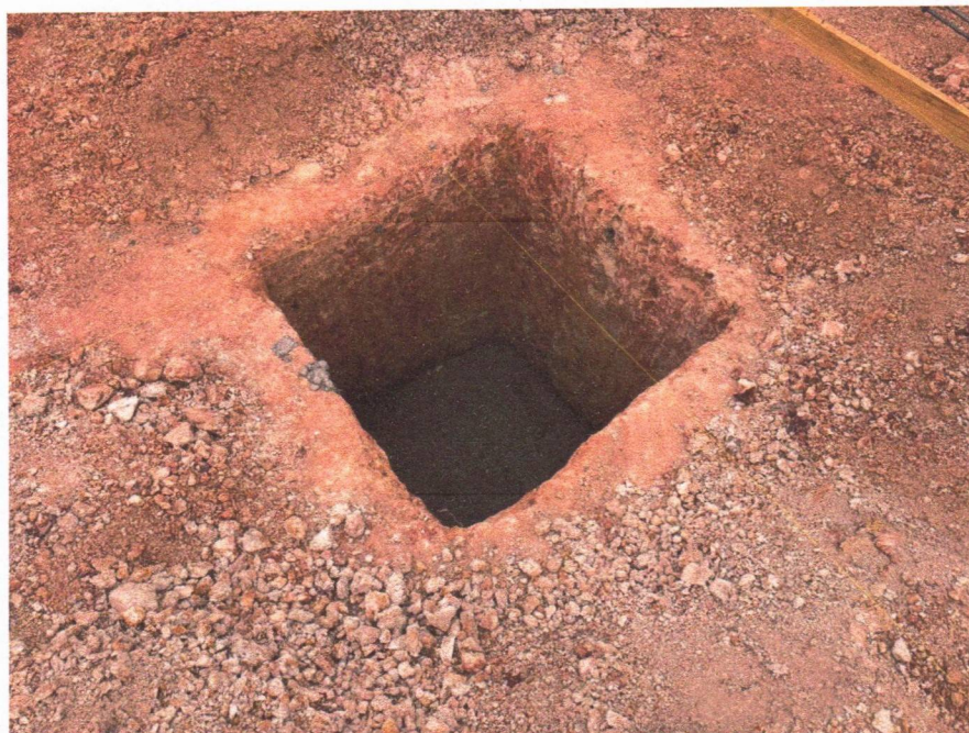
Imagem 5 – Execução do lastro de concreto.
