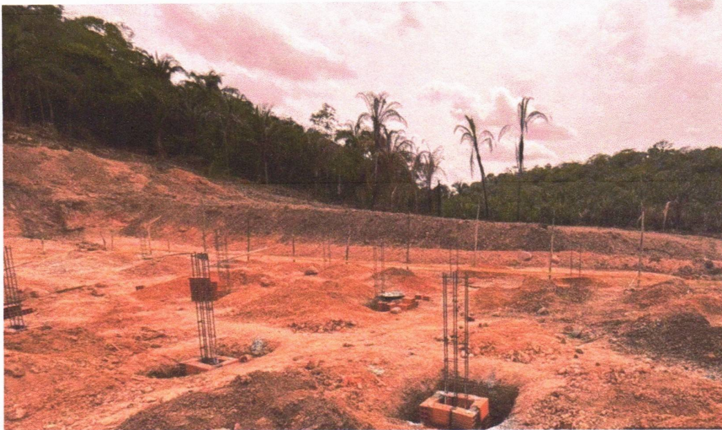
Imagem 7 – Execução da concretagem das sapatas e dos arranque dos pilares.
