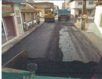
EXECUÇÃO DE RECAPEAMENTO ASFÁLTICO
