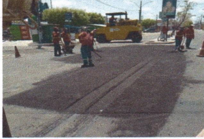
EXECUÇÃO DE TAPA BURACO
