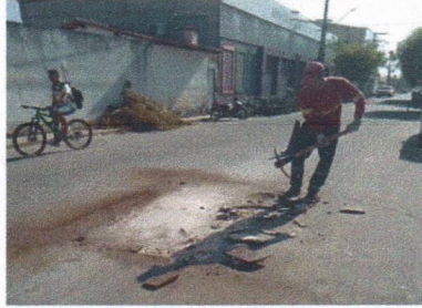
EXECUÇÃO DE TAPA BURACO
