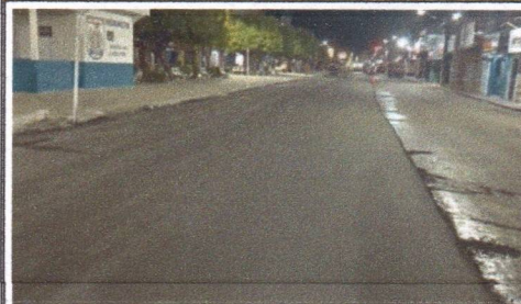
EXECUÇÃO DE RECAPEAMENTO ASFÁLTICO
