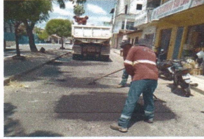
EXECUÇÃO DE TAPA BURACO
