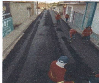
EXECUÇÃO DE RECAPEAMENTO ASFÁLTICO
