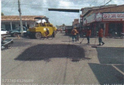
EXECUÇÃO DE RECAPEAMENTO ASFÁLTICO
