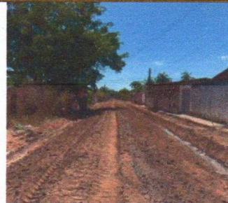
EXECUÇÃO DE BASE
