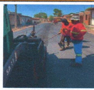
EXECUÇÃO DE PAVIMENTAÇÃO ASFÁLTICA
