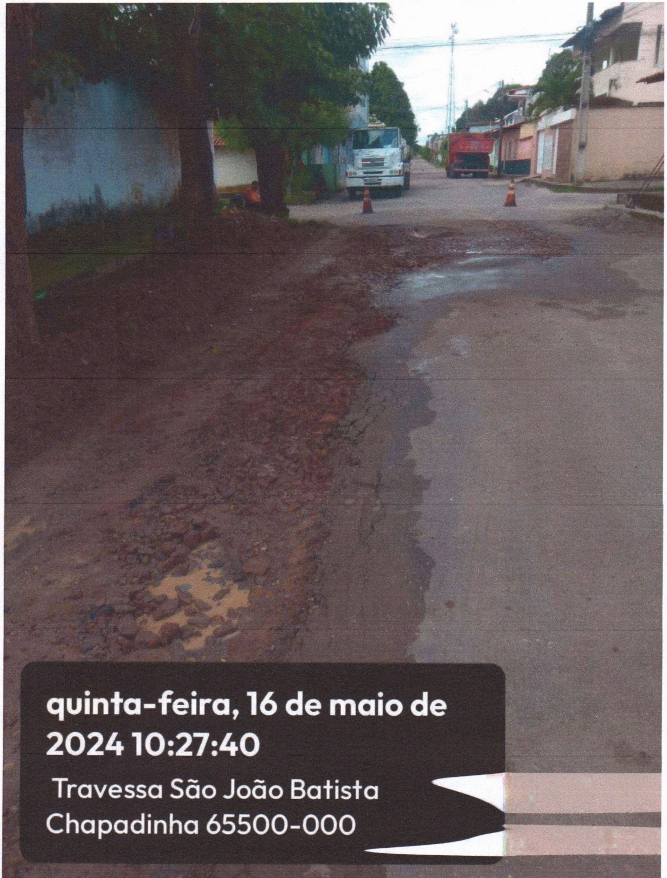
Figura 7 – EXECUÇÃO DE TAPA BURACO.
