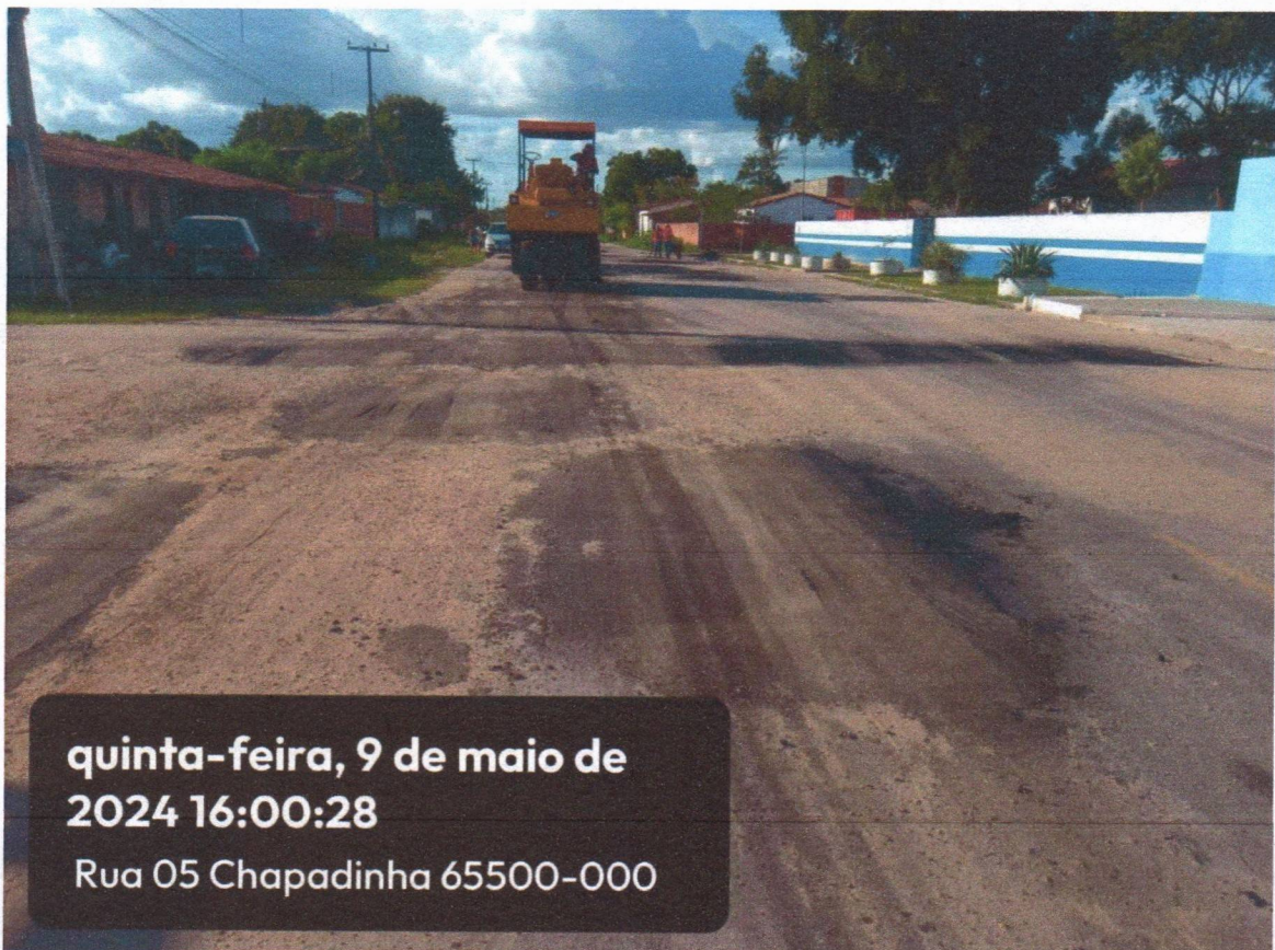
Figura 4 – SERVIÇO DE TAPA BURACO.
