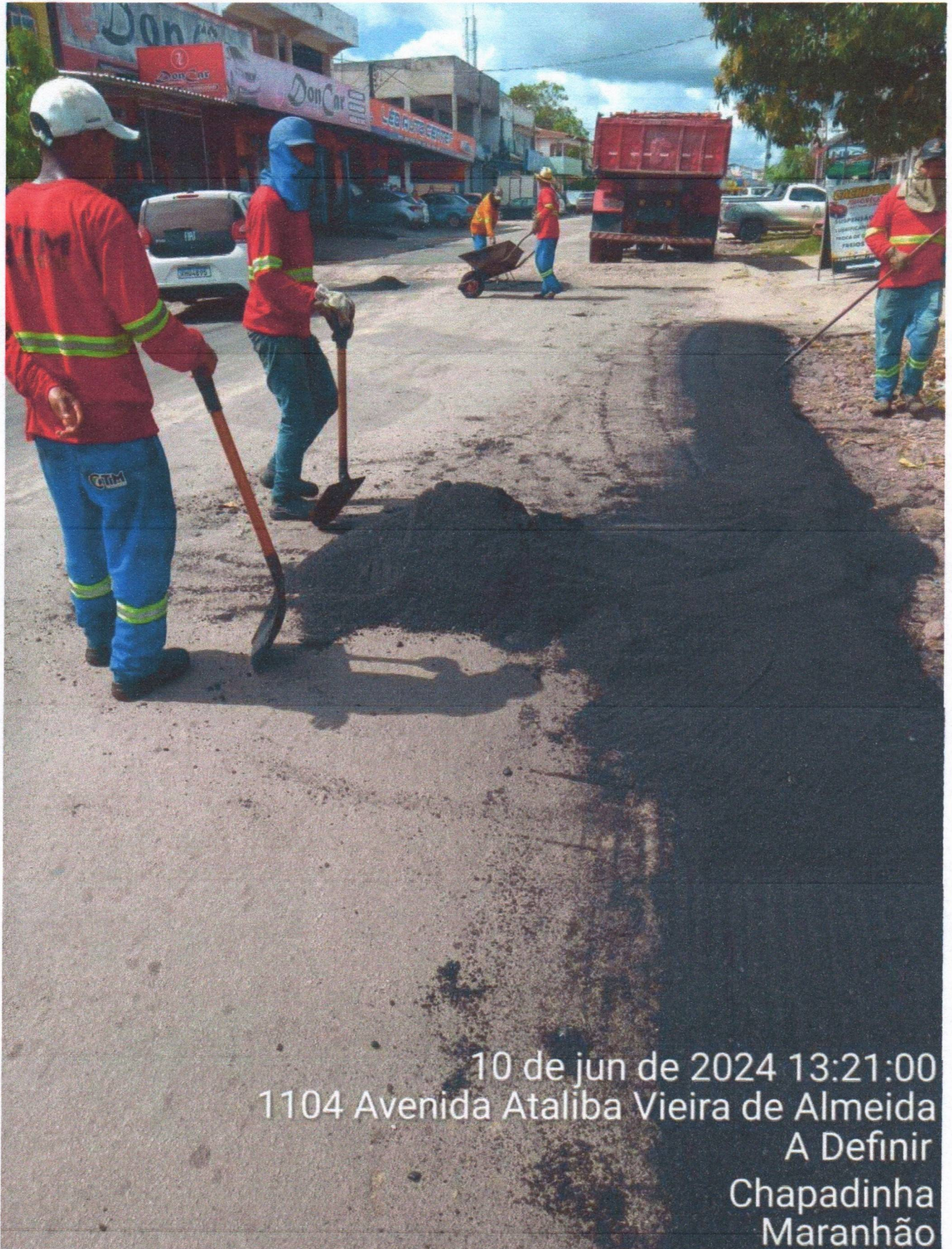
Figura 13 – SERVIÇO DE TAPA BURACO.
