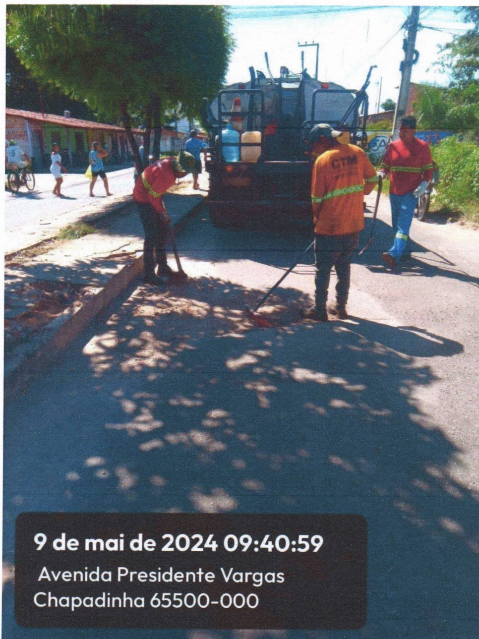
Figura 1 – SERVIÇO DE TAPA BURACO.
