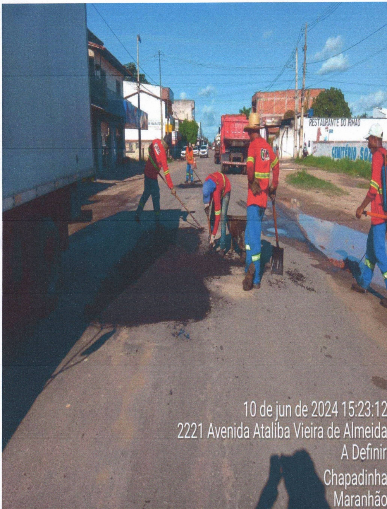
Figura 14 – SERVIÇO DE TAPA BURACO.
