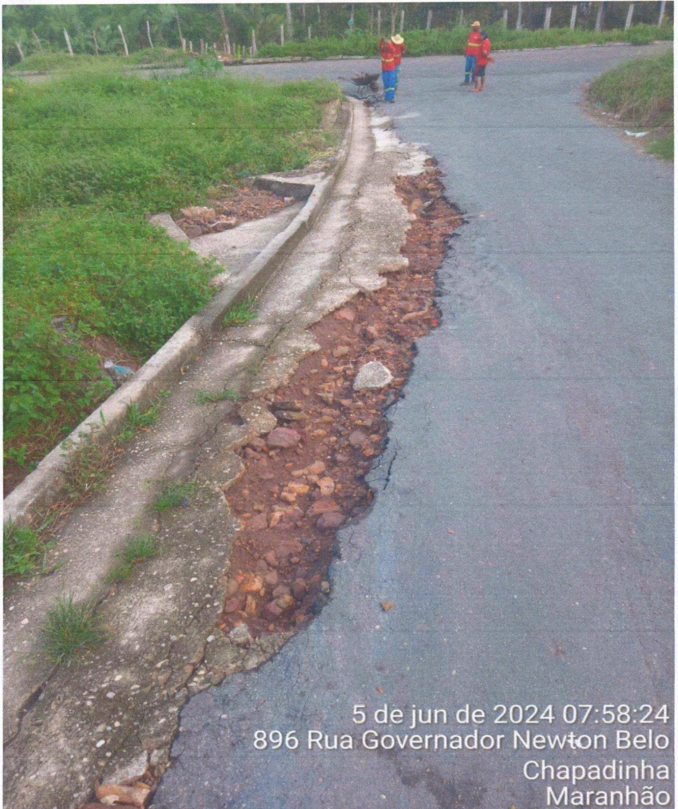
Figura 9 - SERVIÇO DE TAPA BURACO.
