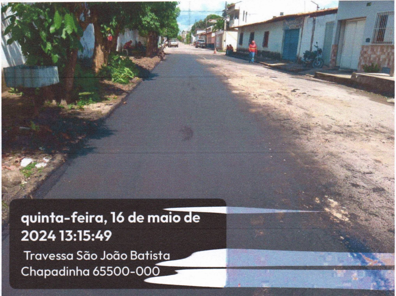
Figura 8 – EXECUÇÃO DE TAPA BURACO.
