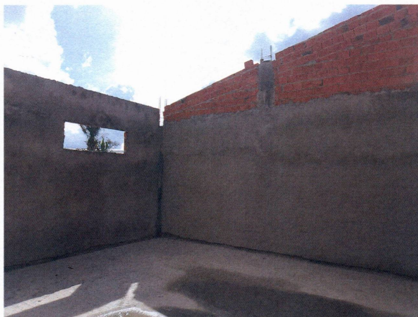
Imagem 8 – Execução de reboco e contrapiso interno das salas.
