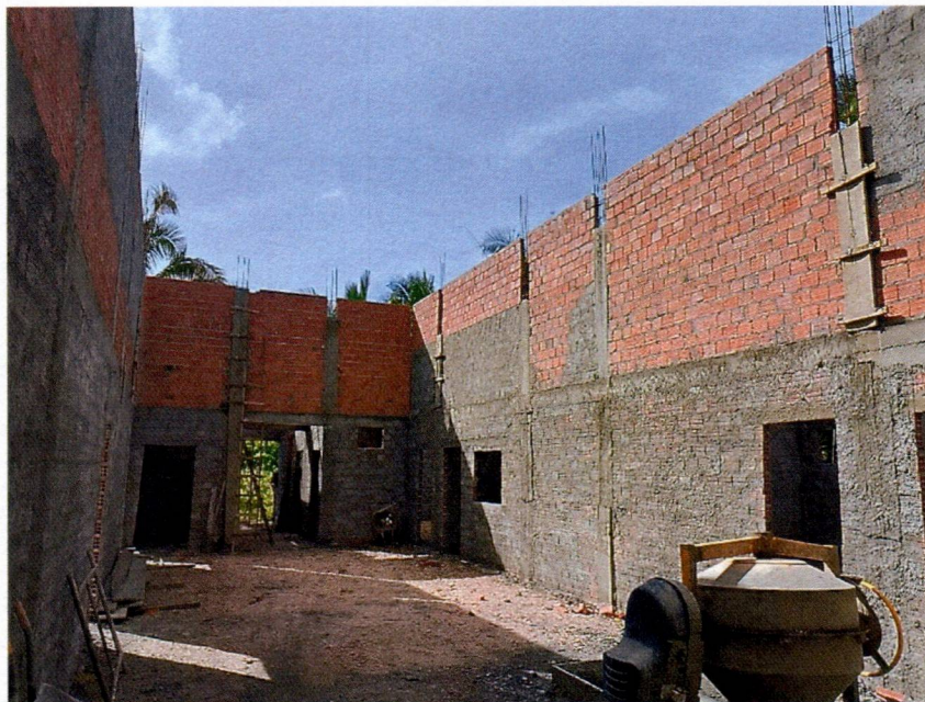
Imagem 4 – Execução da alvenaria, concretagem dos pilares e chapisco.
