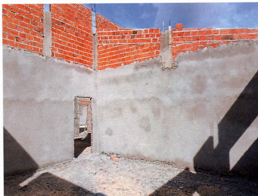
Imagem 6 – Execução da viga superior e do reboco.
