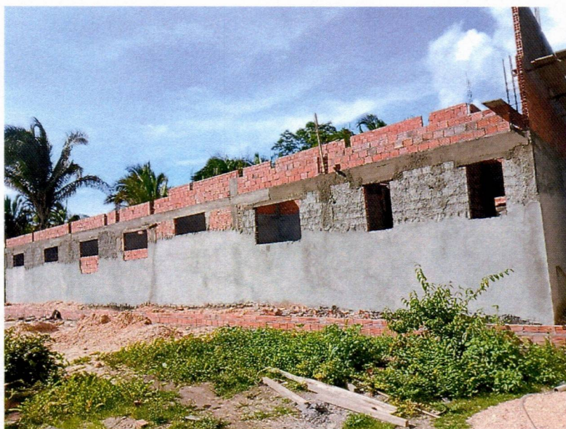
Imagem 1 – Execução da alvenaria, concretagem dos pilares, chapisco e reboco.
